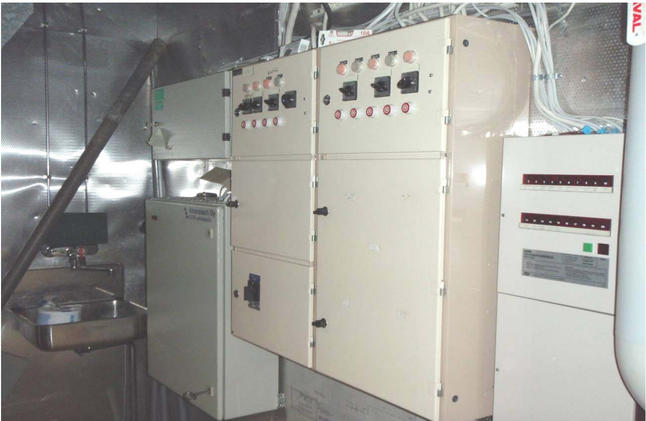
S-KUVA 6. Vanhan osan IV- konehuoneen keskus
