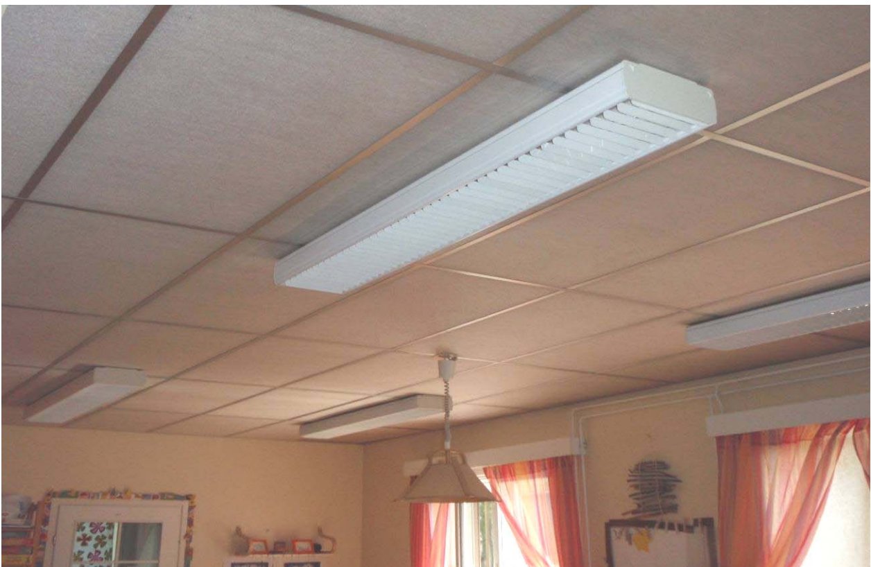
S-KUVA 10. Vanhan osan huoneiden valaistus
