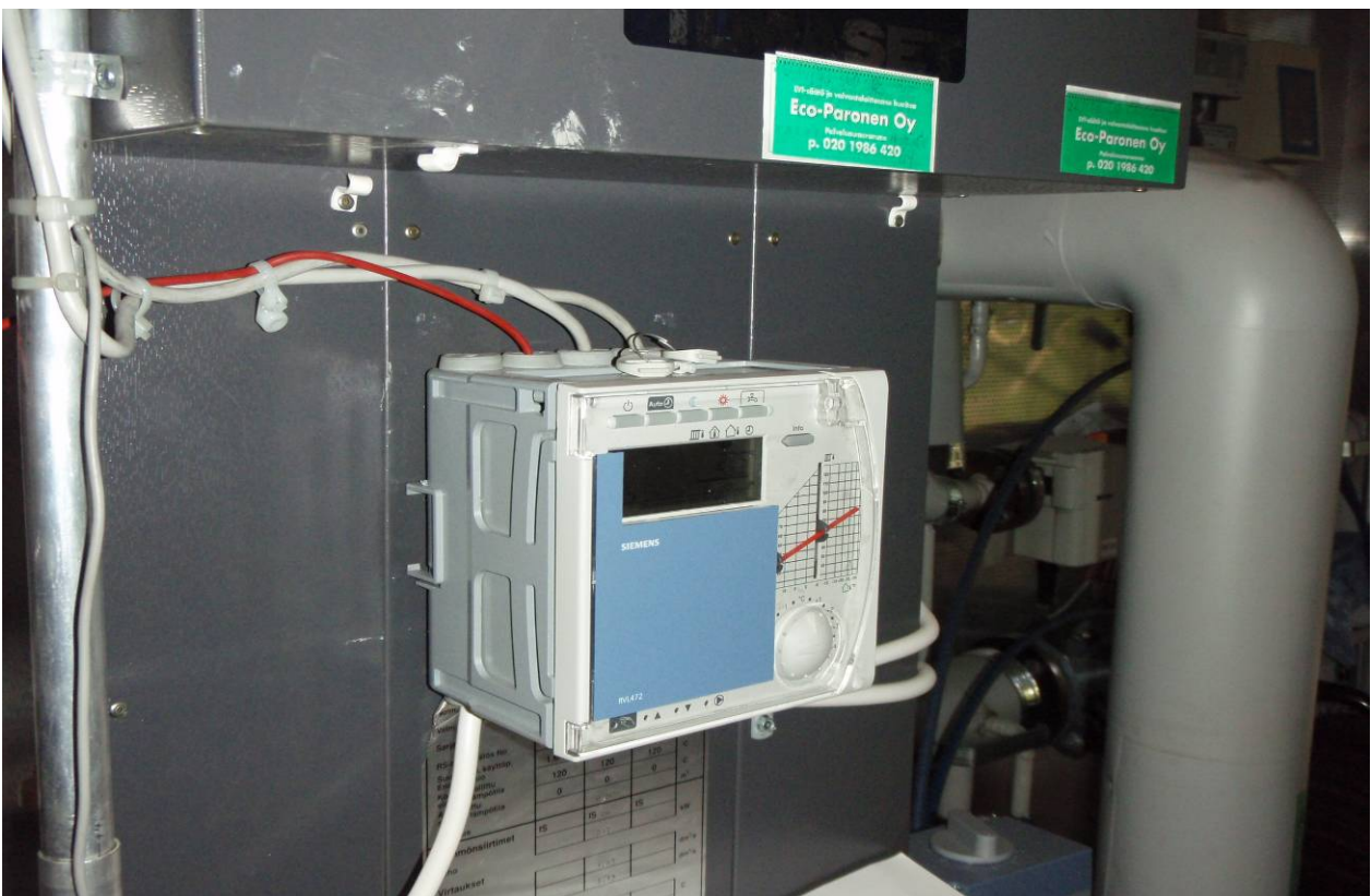
S-KUVA 14. Lämmitysjärjestelmän yksikkösäädin
