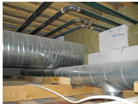
Kuva 9. Alaslasketun katon yläpuolista tilaa.
