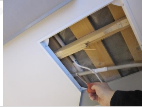
Kuva 5. Tarkastusluukku sisäkatossa
