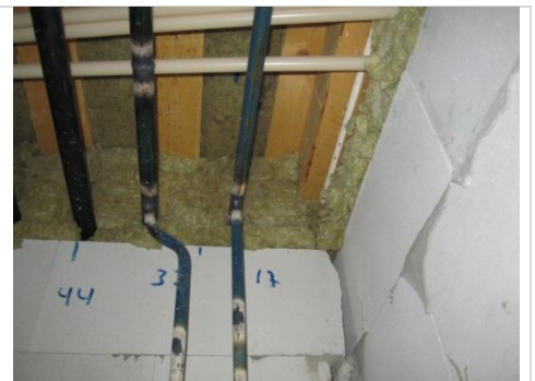
Kuva 10. Alaslasketun katon yläpuolella näkyvää mineraalivillaa.
