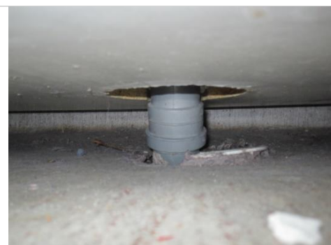
Kuva 14. Käsienvesualtaan allaskaapin alla.
