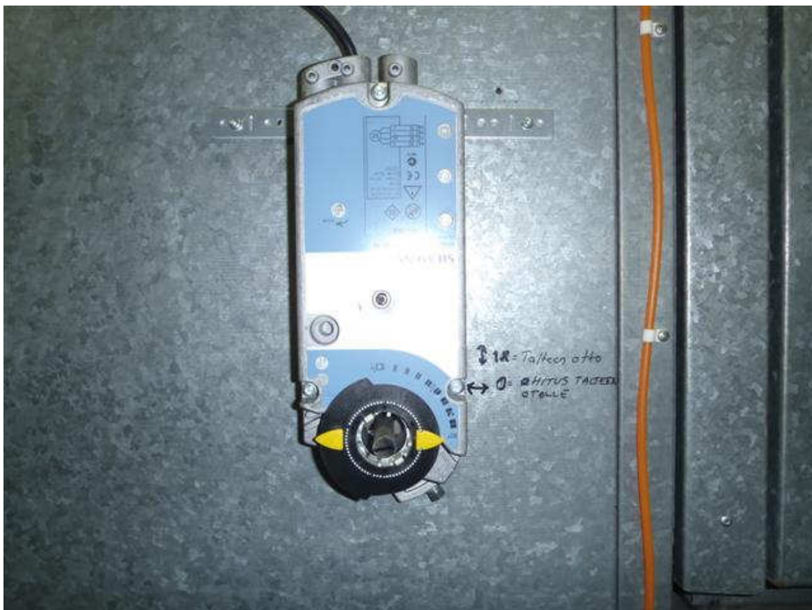
Kuva6. LTO:n ohituspeltimoottori
