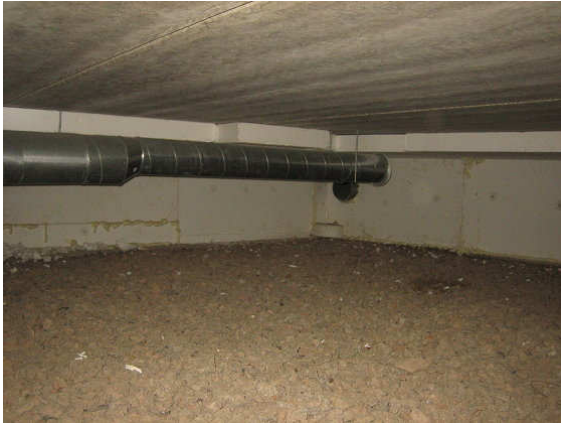
Kuva 3 Alustatilan täyttönä on kuivaa hienoainesta sisältävää karkeaa sepeliä.
