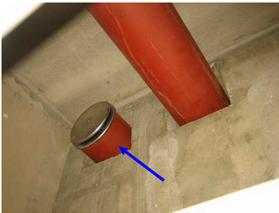
Kuva 17 Tuloilmaa putkikanaaliin.
