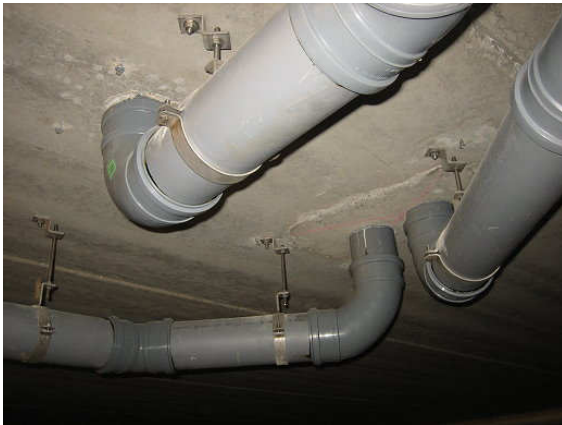
Kuva 9 Ontelolaatan viemärläpivientejä on tiivistetty polyuretaanivaahdolla.
