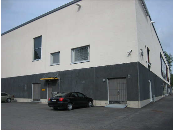
Kuva 1 Rakennusosan 1 alustatila on kulmauksessa.
