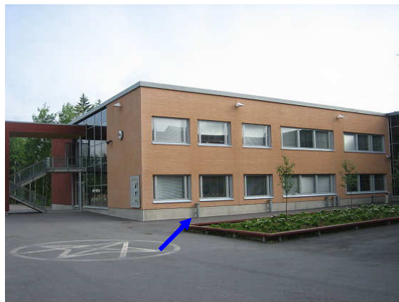
Kuva 5 Rakennusosa 2. Ulkoseinälinjan vierustalla on alustatilan tuuletusputkia.
