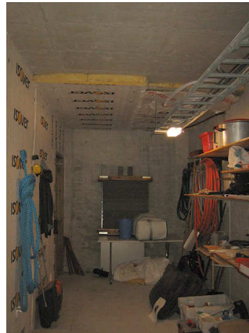
Kuva 16 Putkikanaalia rakennusosan 1 päädyssä. Vasemmalla on ulko-ovi.
