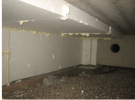
Kuva 8 Sokkeli-elementit ja ontelolaatan reunus- tut on eristetty polystyreenilevyin.
