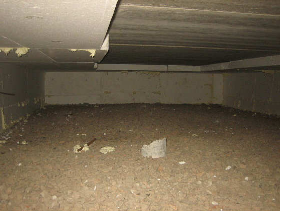
Kuva 4 Reunoilla ja seinillä on polystyreenilevyt.
