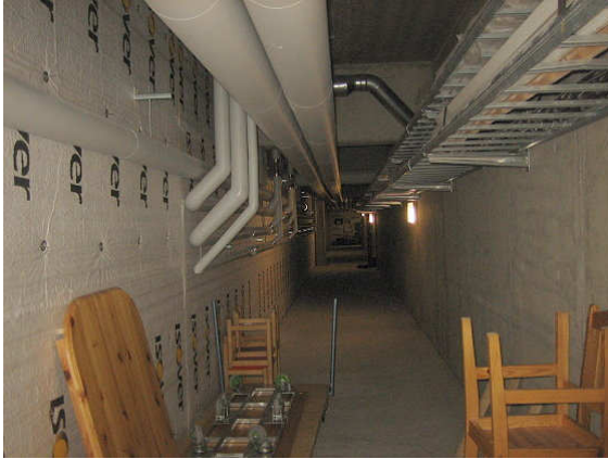
Kuva 13 Putkikanaalia rakennusosan 2 kohdalla.
