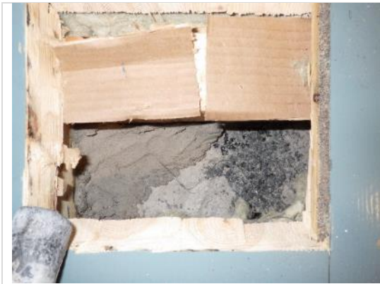
Kuva 65. Lattian koolaus on tuettu laastikasan päältä.
