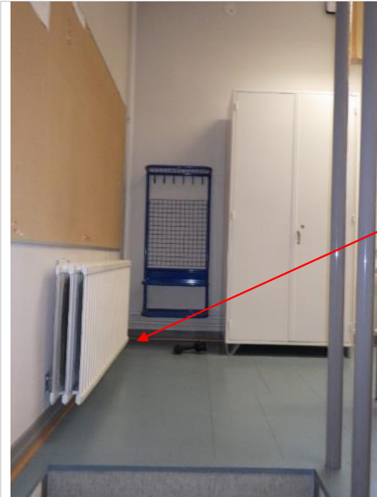
Kuva 58. Yleiskuva rakenteiden avauskohdasta.
