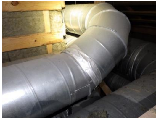
Kuva 56. Ilmanvaihtoteipillä tiivistetty IV-kanavan liitos yläpohjassa.
