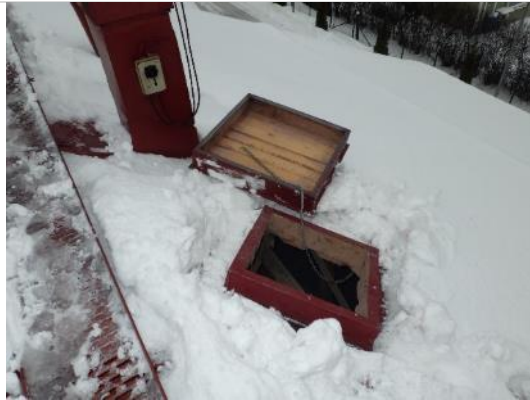
Kuva 33. Yläpohjan tuuletustilan tarkastusluukku.
