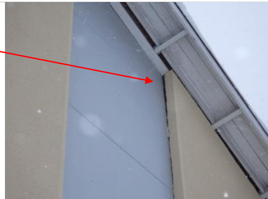
Kuva 6. Lähikuva julkisivun kaareutumuksesta.
