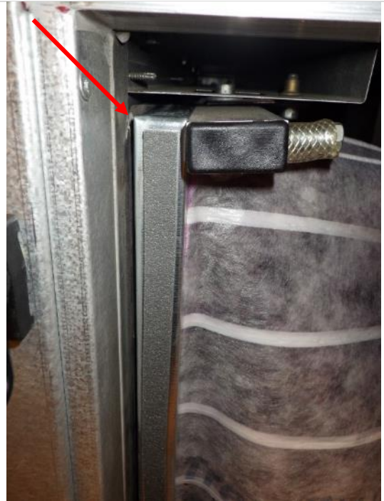
Kuva 51. Suodatinkasetin kehyksen kulmassa on sauma, jonka kautta ohivuoto tapahtuu.
