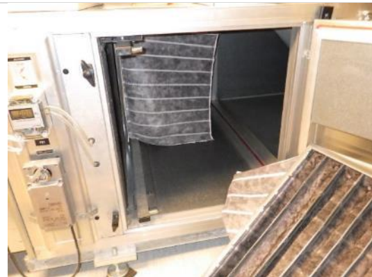
Kuva 48. Yleiskuva IV-koneen suodatinyksiköstä.
