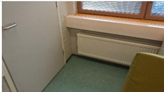
Kuva 11. Tilan 014 eli luokan 104 ulkoseinän ja alapohjan liitoskohta.
