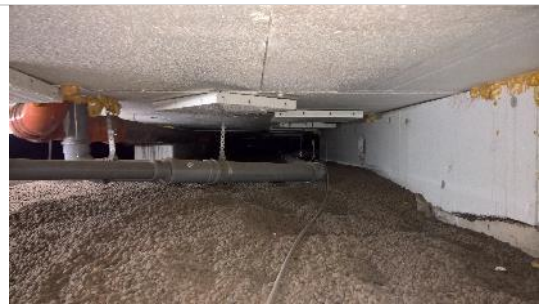
Kuva 26. Yleisnäkymä ryömintätilasta, joka normaalikuntoinen.
