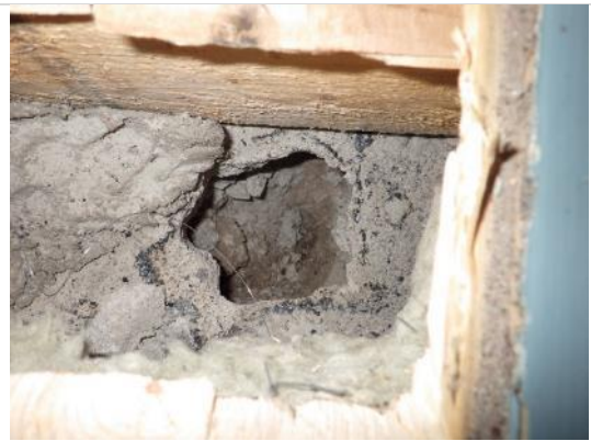
Kuva 66. Betonilaatan alapuolella on hiekkätäyttö.
