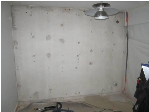
Kuva 1 Yleiskuva kohdehuoneen päätyulkoseinälle.
