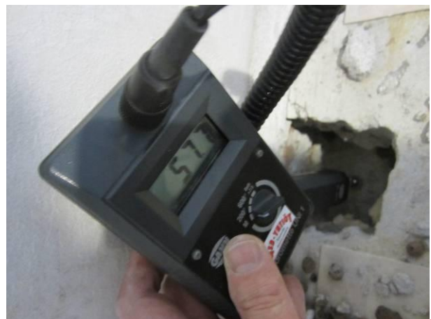
Kuva 8 Rakenneavauskohdassa pohjalaatan kosteus oli kuivaa rakennetta vastaava.
