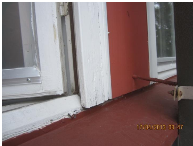
kuva 25 Ikkunoiden puupintojen ulkomaalipinnoissa on jonkin verran kulumia, puu on halkeillut.
