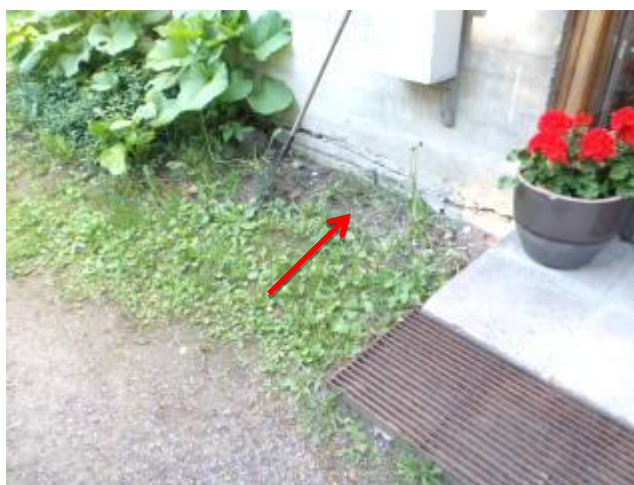
kuva 2 Lisäksi sokkelivierillä on maanpainaumia.
