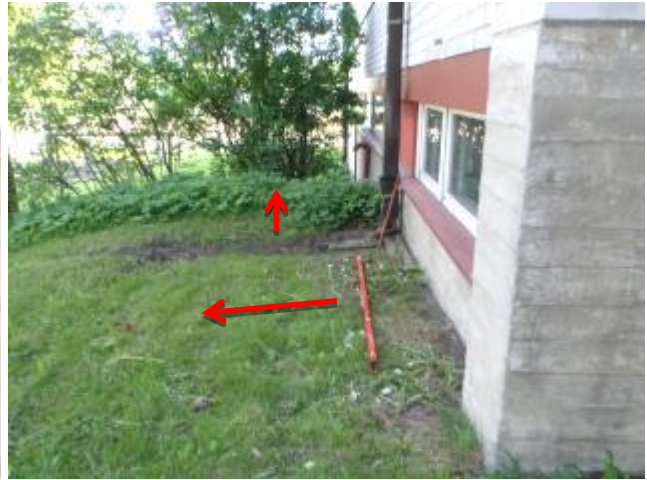
kuva 9 Kattosadevedet ovat suurimmaksi osaksi johdettu suoraan pihapinnoille... kuva 10 ...joista ne betonikourujen avulla pyritään siirtämään kauemmas talon viereltä.
