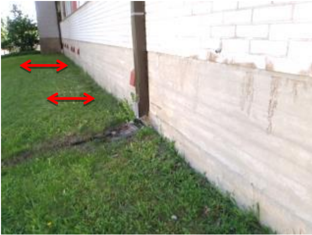
kuva 9 Kattosadevedet ovat suurimmaksi osaksi johdettu suoraan pihapinnoille... kuva 10 ...joista ne betonikourujen avulla pyritään siirtämään kauemmas talon viereltä.
