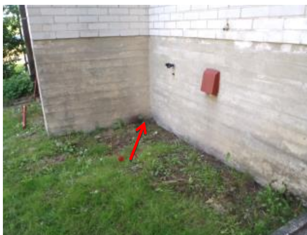
kuva 4 ...täälläkin on sokkelivierillä maanpainaumia.
