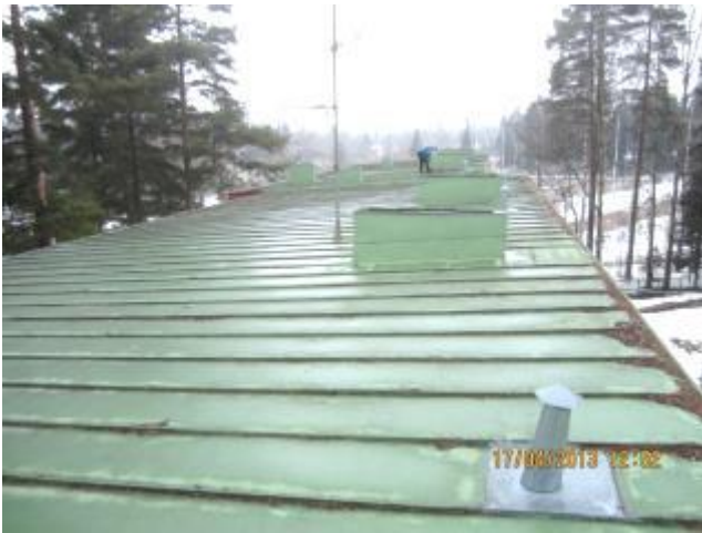
kuva 33 Yleiskuva vesikatolta, lisätty tuuletusventtiilit.
