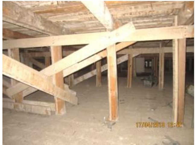
kuva 32 Kattotuolit ovat paikalla tehdyt.
