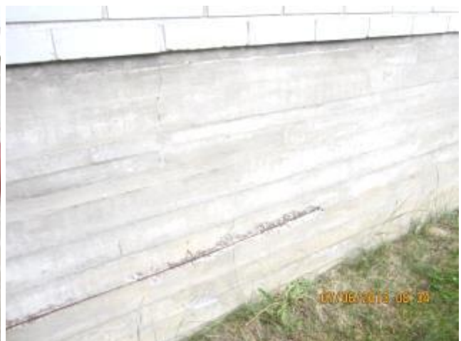
kuva 11 Sokkelissa on paljon kosteusjälkiä ja kulumia.. kuva 12 ...sekä useassa kohdin on harjaterästä näkyvissä.
