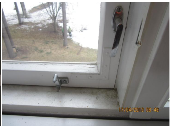
kuva 26 Vesijälkiä tuuletusikkunassa.
