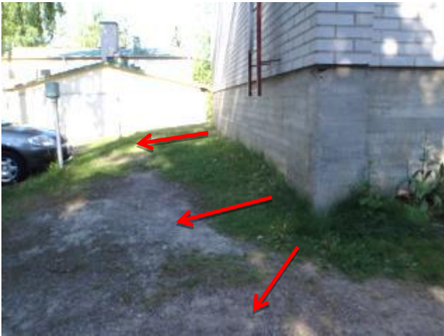
kuva 5 Eteläpäädyn pintakallistukset ovat riittävät.
