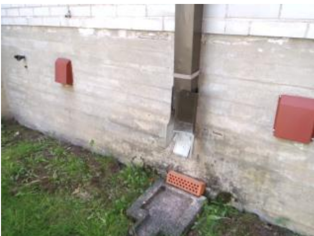
kuva 11 Sokkelissa on paljon kosteusjälkiä ja kulumia.. kuva 12 ...sekä useassa kohdin on harjaterästä näkyvissä.
