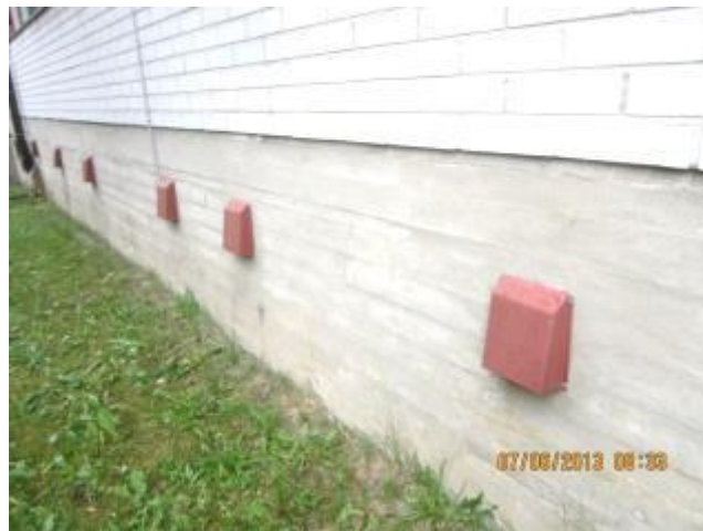
kuva 41 Alkuperäinen, painovoimainen poistoilma-venttiili asunnon wc-pesuhuoneessa. kuva 42 Kellaritiloja palvelevia korvausilmareittejä on näkyvissä rakennuksen sokkelissa.
