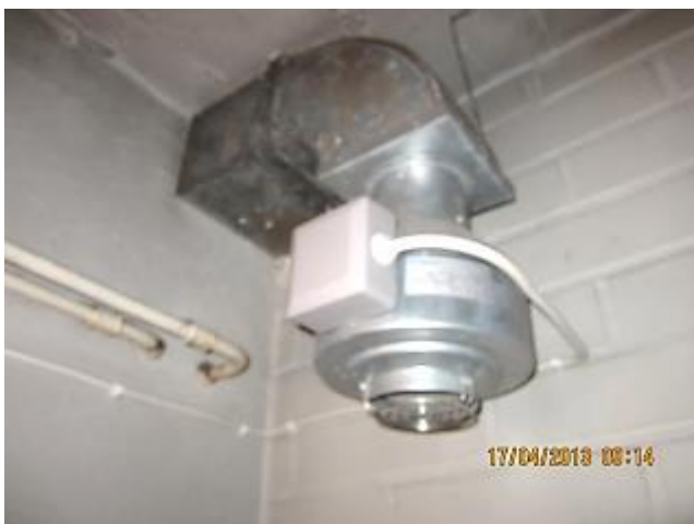
kuva 43 Kuivaushuonetta palveleva poistopuhallin. kuva 44 Painovoimainen tiilimuurattu poistoilmahormi vesikatolta kuvattuna.
