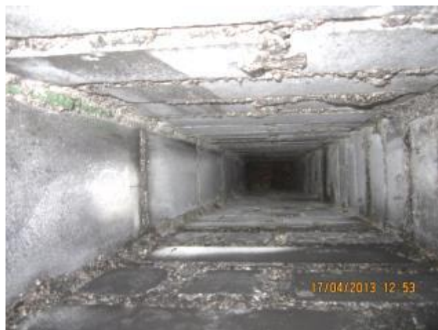
kuva 43 Kuivaushuonetta palveleva poistopuhallin. kuva 44 Painovoimainen tiilimuurattu poistoilmahormi vesikatolta kuvattuna.
