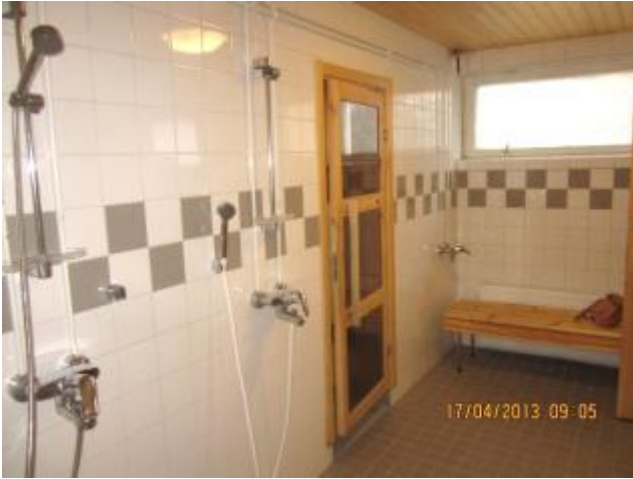
kuva 23 Peruskorjatun talosaunan pesuhuoneessa on hyväkuntoinen 15x15 laatoitus.
