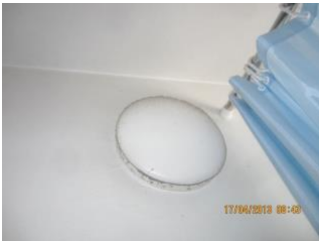
kuva 41 Alkuperäinen, painovoimainen poistoilma-venttiili asunnon wc-pesuhuoneessa. kuva 42 Kellaritiloja palvelevia korvausilmareittejä on näkyvissä rakennuksen sokkelissa.
