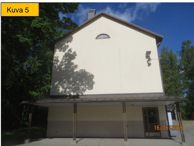
Kuvat 5 ja 6. Itäpään sisäänkäynnin yhteydessä oleva pitkä katos. Puurakenteiset pilarit ovat taipuneet (nurjahdus). Suositellaan akuuttia uusimista.
