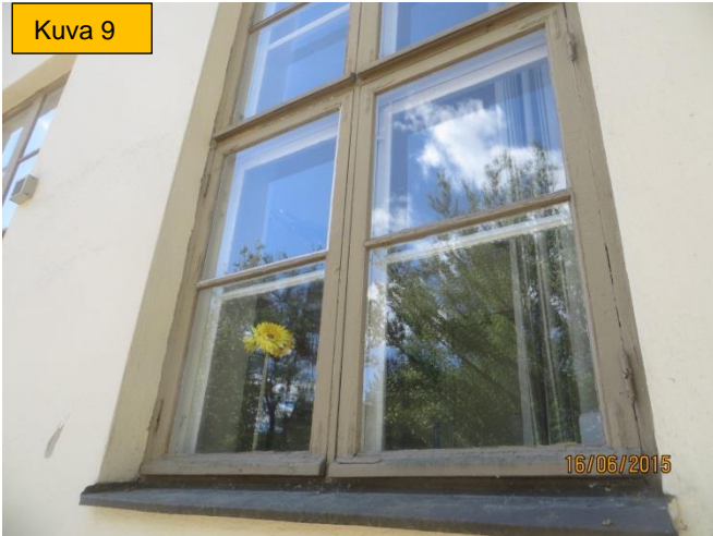
Kuva 9. Pohjoispuolen ikkunoiden ulkopuoliteiden kunto on välttävä. Kuva 10. Eteläpuolen ikkunoiden ulkopuoliteiden kunto on heikko.
