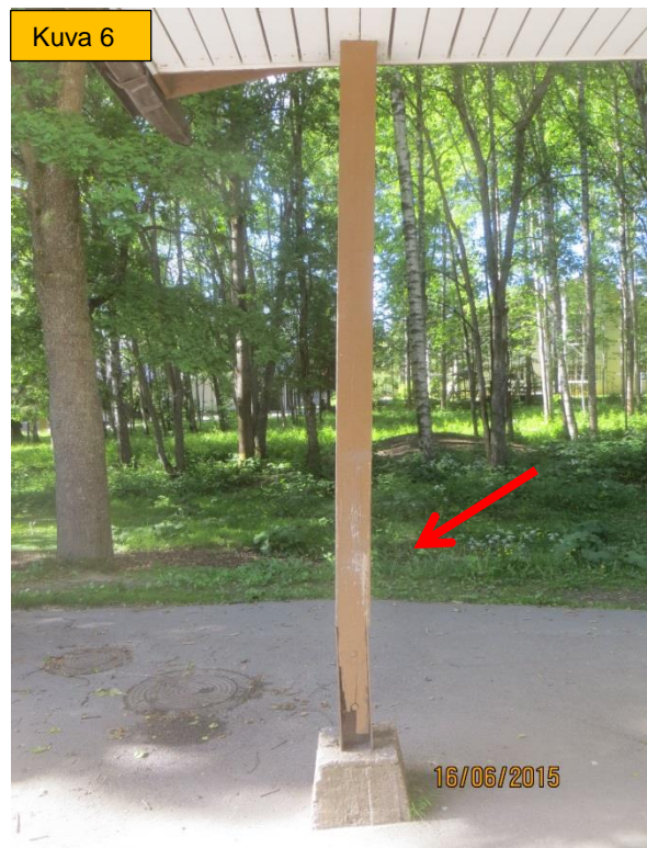
Kuvat 5 ja 6. Itäpään sisäänkäynnin yhteydessä oleva pitkä katos. Puurakenteiset pilarit ovat taipuneet (nurjahdus). Suositellaan akuuttia uusimista.
