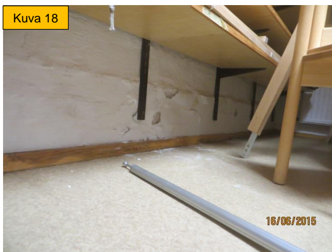
Kuva 17 ja 18. Luokan 1 vieressä olevassa portaassa alustilassa havaittiin kosteusjälkiä ja koholla olevia pintakosteuslukemia.
