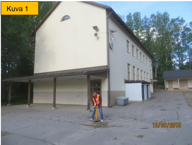
Kuva 1. Yleiskuvaa julkisivuista pohjoiseen (pitkä sivu) ja itään (pääty).
