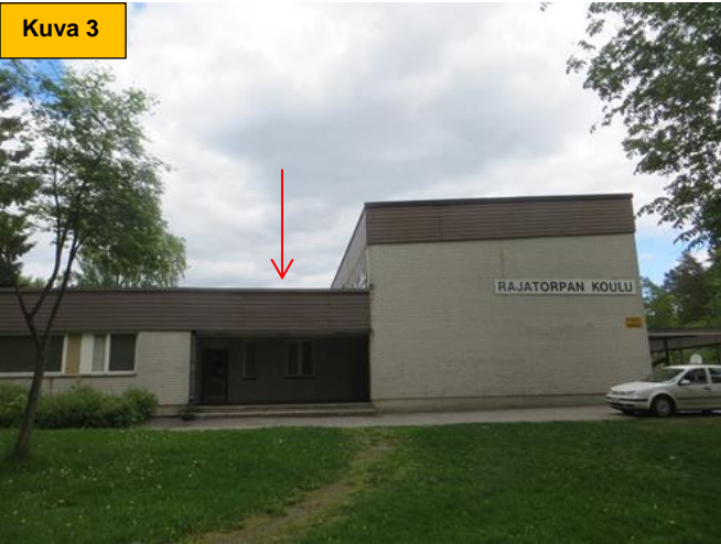
Kuva 3. Matalan rakennusosan katosrakenteen painuma eteläpäädyssä. Kuva 4. Matalan rakennusosan eteläpään syöksyputken vedet kastelevat sokkeliulkoseinää.
