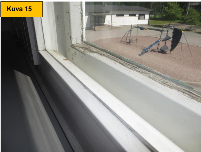
Kuva 15. Alkuperäiset 2-lasisten puikkunoiden ulkopiitteet ja karmivälit ovat kuluneet. Kuva 16. Tuuletusluukkujen lukitusmekanismi ei toimi kunnolla ja ikkunat ovat epätiivitä.
