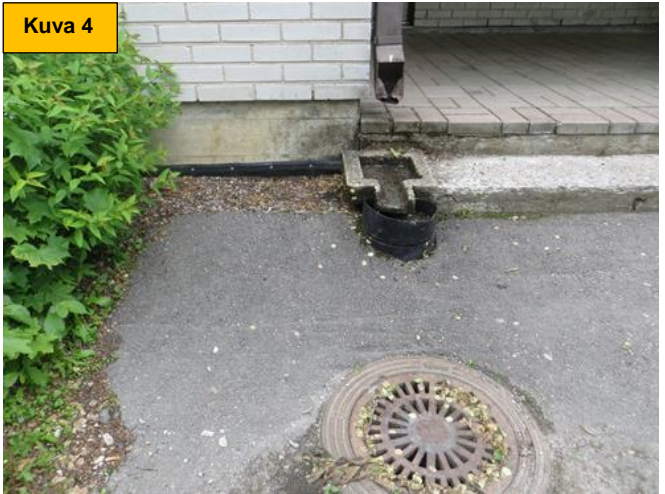
Kuva 3. Matalan rakennusosan katosrakenteen painuma eteläpäädyssä. Kuva 4. Matalan rakennusosan eteläpään syöksyputken vedet kastelevat sokkeliulkoseinää.
