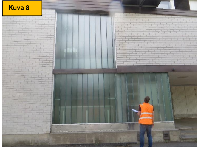
Kuva 8. Pohjoispään lasiruutuelementit. Sokkelipinnoilla näkyy verkkohalkeilua.
