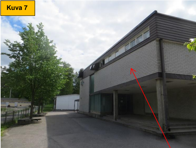
Kuva 7. Pohjoispään julkisivu. Liikuntasalin märkätilat.
