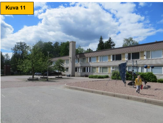
Kuva 11. Piha-alue ja julkisivu, vanha lämmityskattilan piippu.
