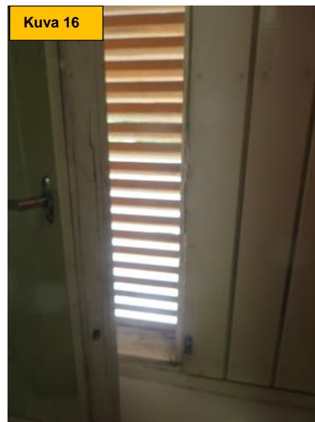
Kuva 15. Alkuperäiset 2-lasisten puikkunoiden ulkopiitteet ja karmivälit ovat kuluneet. Kuva 16. Tuuletusluukkujen lukitusmekanismi ei toimi kunnolla ja ikkunat ovat epätiivitä.
