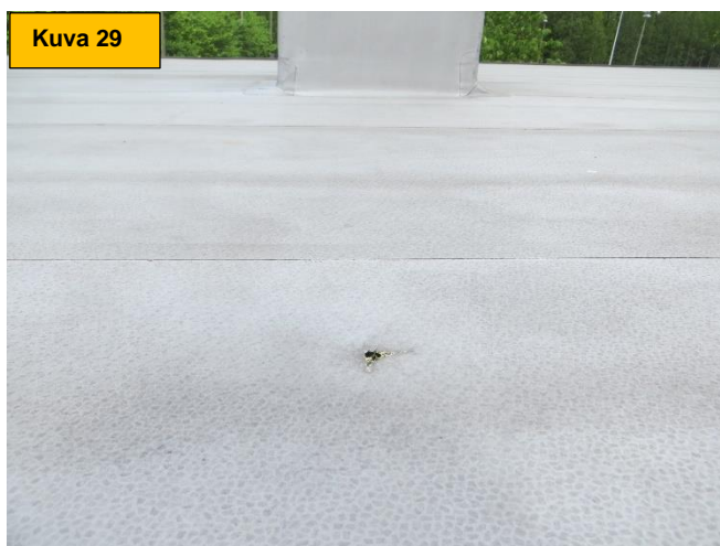
Kuva 28 ja 29. Katolle syntyneitä reikiä. Suurin osa rei'istä on syntynyt, kun pellin päälle koolatun puun naulankantaan on astuttu.
