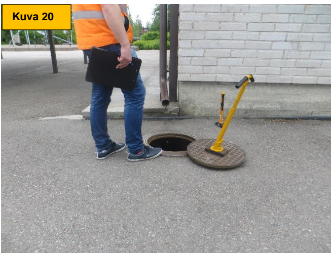
Kuva 20 ja 21. Salaojien tarkastuskaivo ja salaojaputki pohjoisnurkalla. Kaivossa oli vesi juoksupinnan alapuolella.
