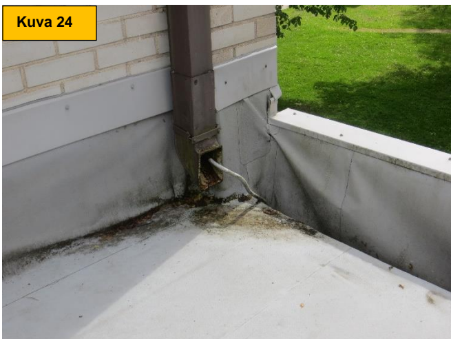
Kuva 24. Matala rak.osa. eteläpään pvc-katteessa on pussiintuneita osia ja mahdollisia vuotokohtia. Kuva 25. Matala rak.osa, sadevesikouru.
