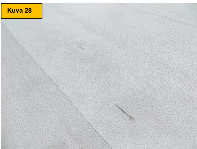
Kuva 28 ja 29. Katolle syntyneitä reikiä. Suurin osa rei'istä on syntynyt, kun pellin päälle koolatun puun naulankantaan on astuttu.
