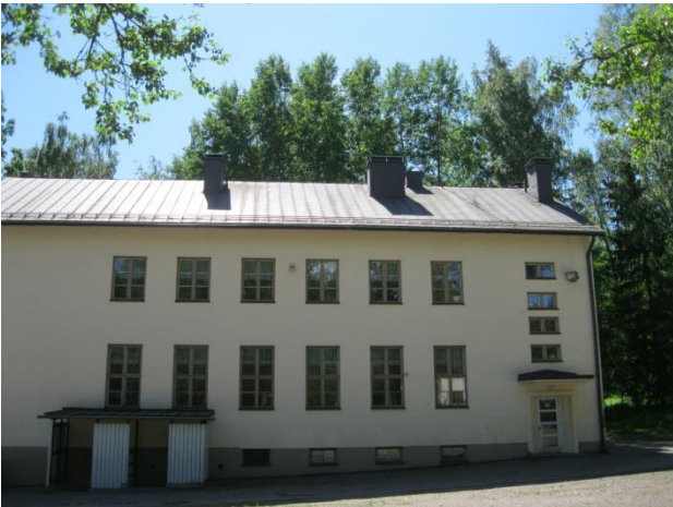
Kuva 8. Vesikatolla sijaitsevat ilmanvaihtohormien ulospuhallus aukot.
