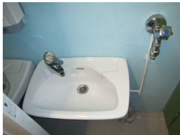
Kuva 15. 1-ote hanat ovat ikääntyneitä malleja.
