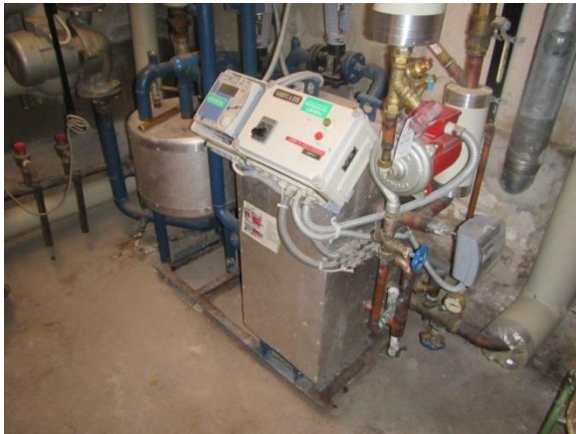
Kuva 4. Kaukolämmön alajakokeskus.
