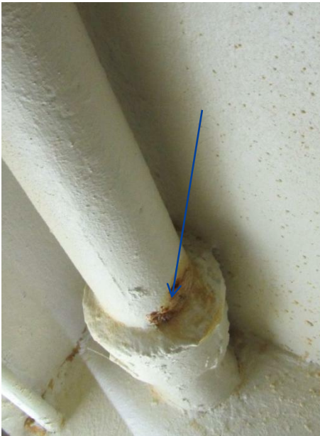
Kuva 21. Merkkejä grafitoitumisesta.
