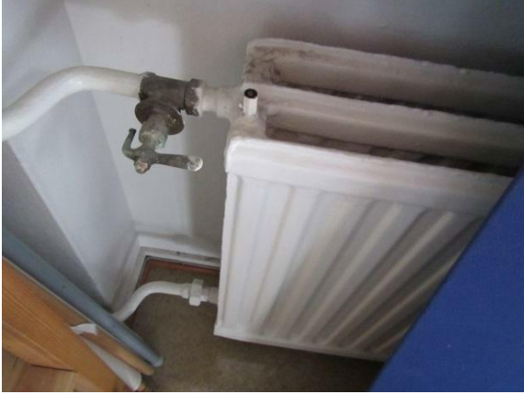
Kuva 10. Alkuperäinen patteriventtiili ja patteri.
