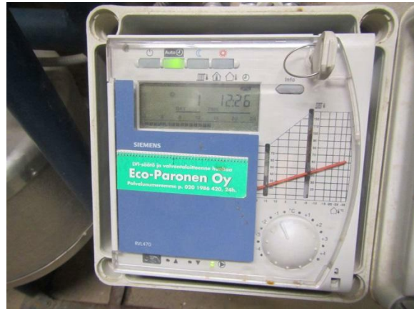
Kuva 5. Lämmöntuotantolaitteiden säätölaite.
