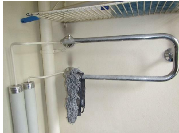
Kuva 9. Siivouskomeron käyttövesipatteri.
