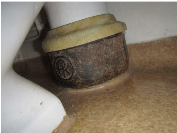
kuva 18. WC-istuimen alkuperäinen kytkentäviemäri (2 krs.).
