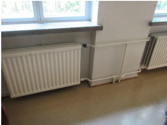
Kuva 8. Luokkatilojen teräslevypattereita.
