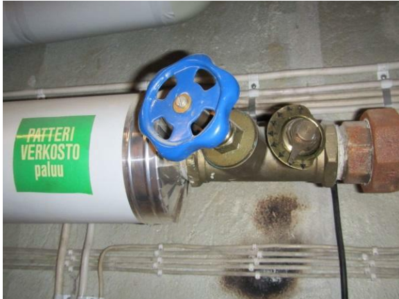
Kuva 6. Patteriverkoston linjasäätöventtiili 1980-luvulta
