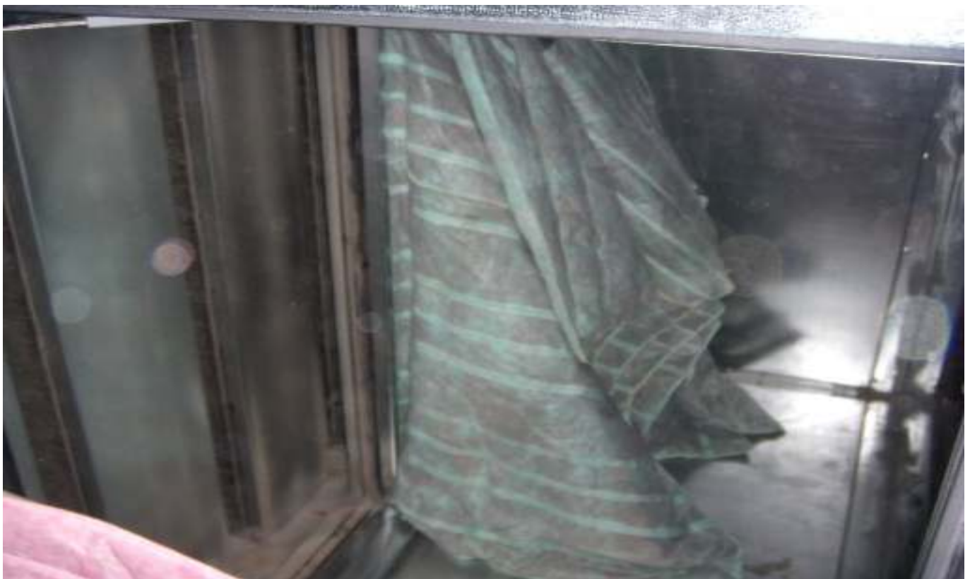
KUVA 4. Toinen poistoilmasuodatin on uusittu ja toinen on vanha.
