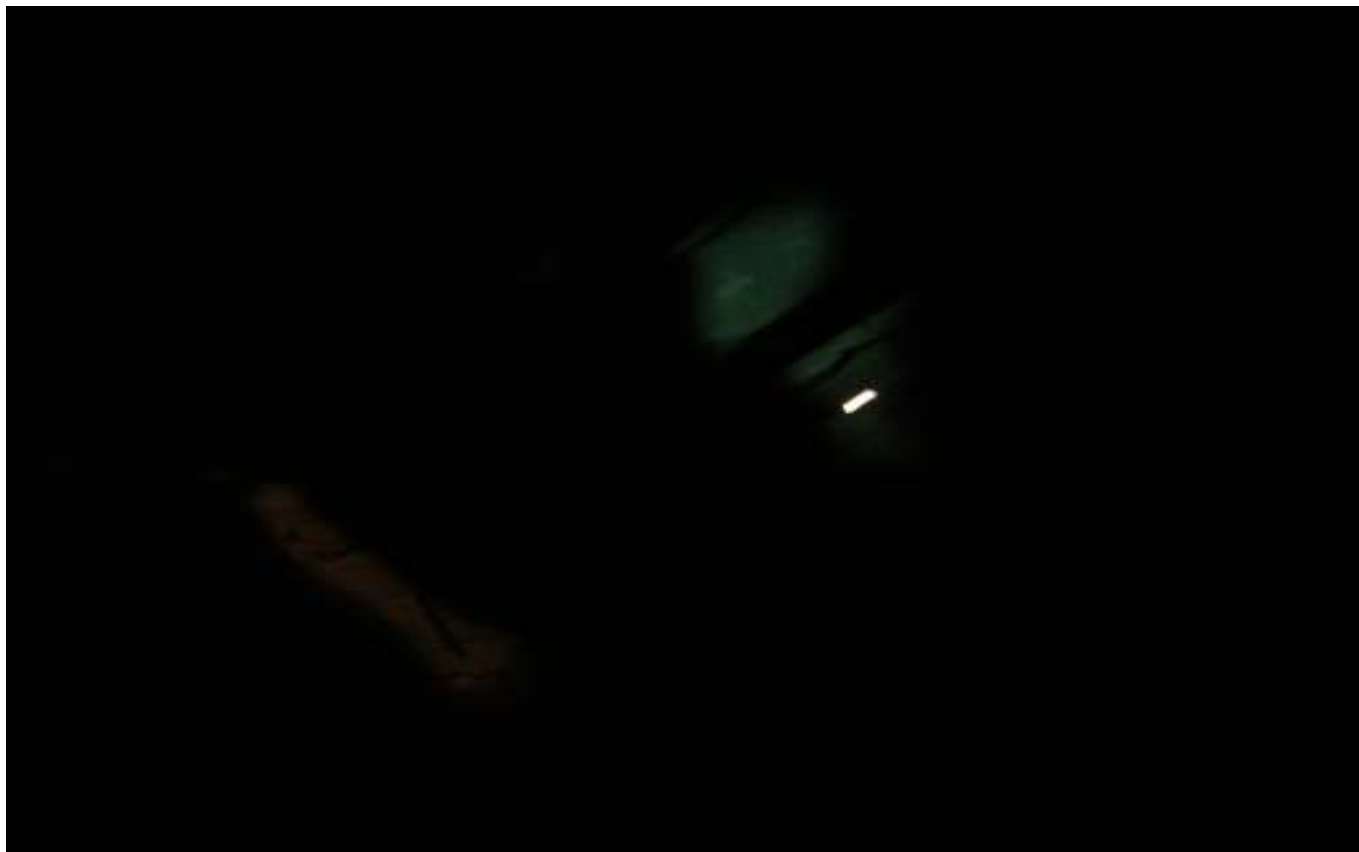
KUVA 24. Tuloilmakanavien tiiveydessä on puutteita (kuva on otettu kanavan sisältä ja näkyvä valopilkku on reikä kanavaliitoksessa).
