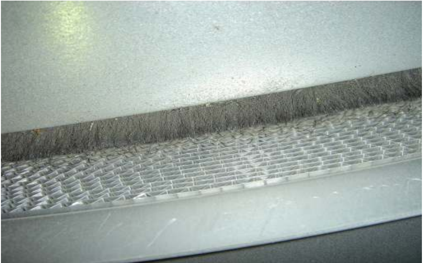
KUVA 16. LTO- kennon tulisi olla puhdas, kuten kuvassa oleva kenno-osa on (vertaa esim. kuvan 15 kennoon).
