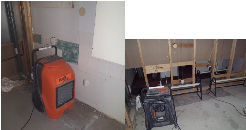
Kuvat 18-19. Kotikeittiötilan ja viereisen WC:n väliseinä on purettu ja tilojen kuivatus on käynnissä.
