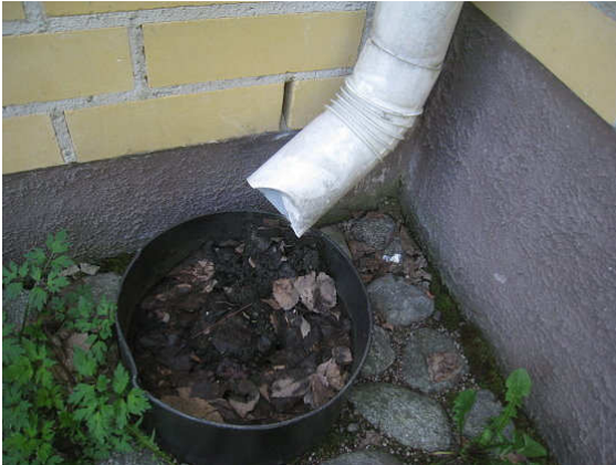
Kuva 1 Kattovesikaivossa kasvijätettä.
