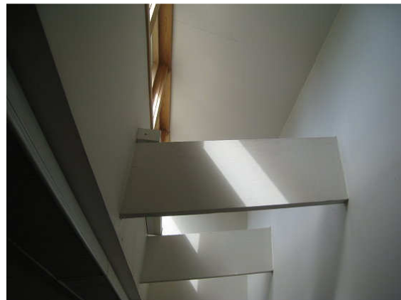
Kuva 28 Kattolyhdyn valokuilussa ei havaittu vesivuotojälkiä.
