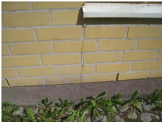
Kuva 9 Julkisivutiilimuurauksessa halkeamia.
