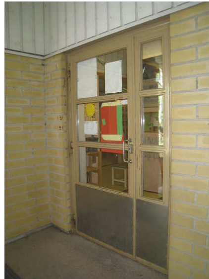
Kuva 14 Teräsrakenteinen ikkunallinen ulko-ovi.
