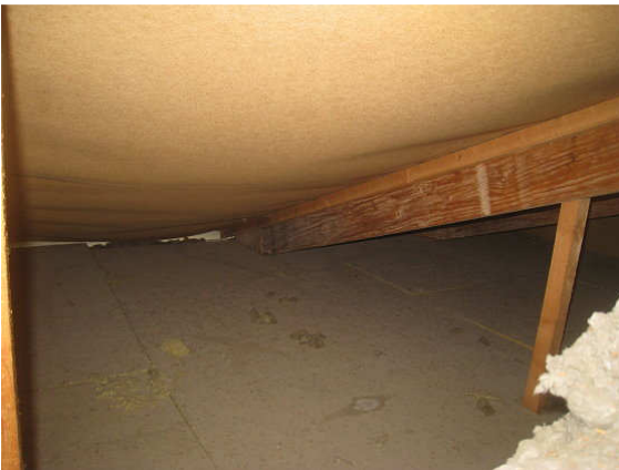
Kuva 25 Yläpohjaa tilan 20 yläpuolelta.
