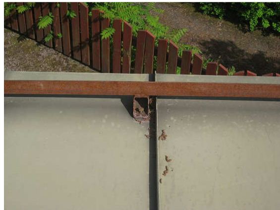
Kuva 20 Lumiesteet kiinnitetty pulteilla, jotka eivät ole tiiviit.
