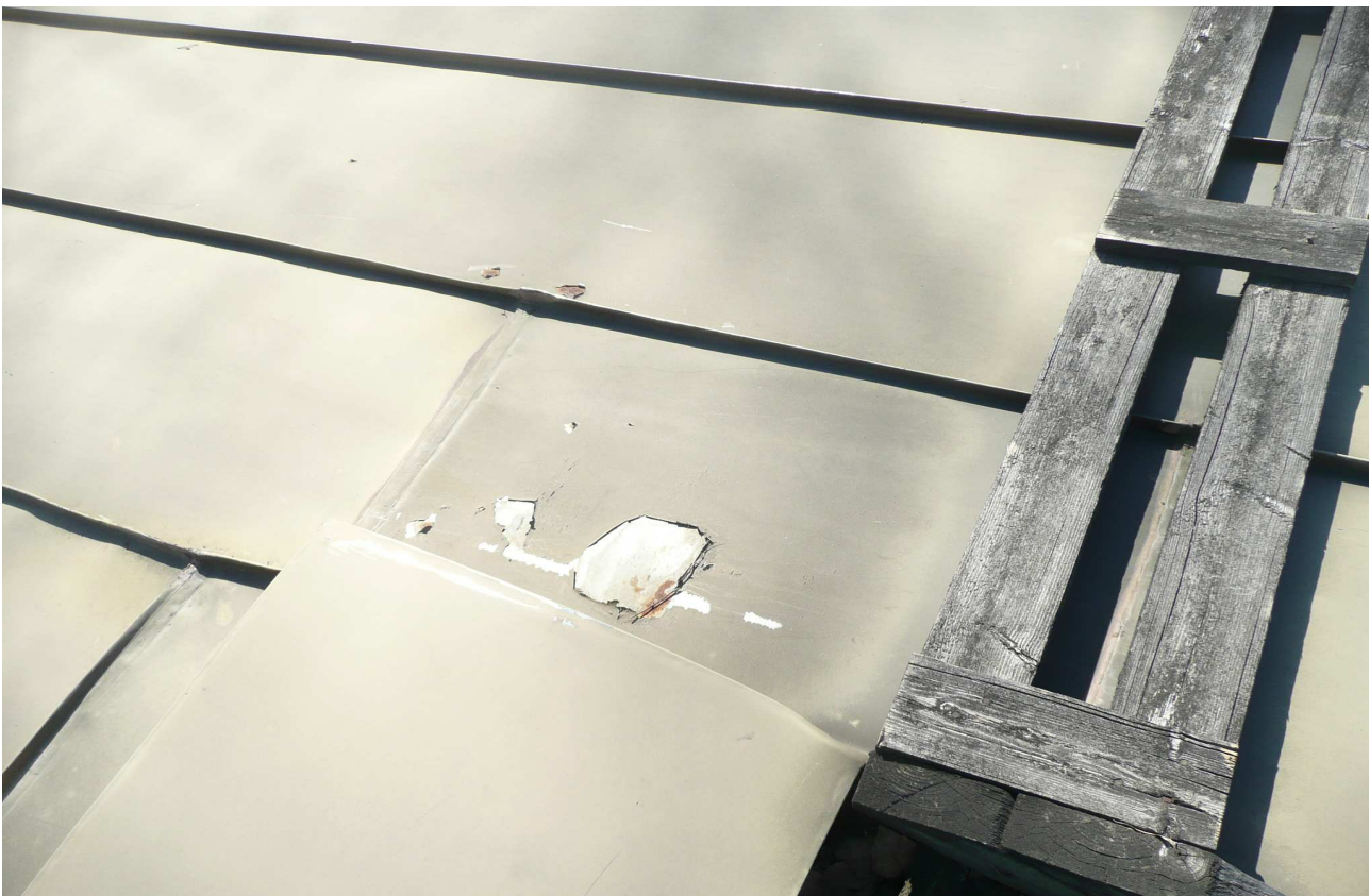
RAK- kuva 7. Yleiskuva vesikatolta.
