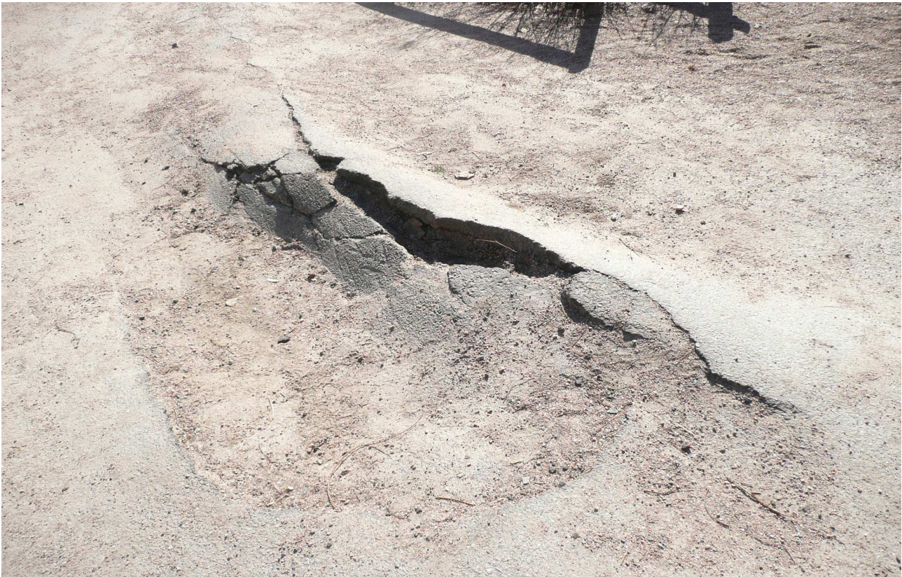
RAK- kuva 1. Yleiskuva piha-alueesta.
