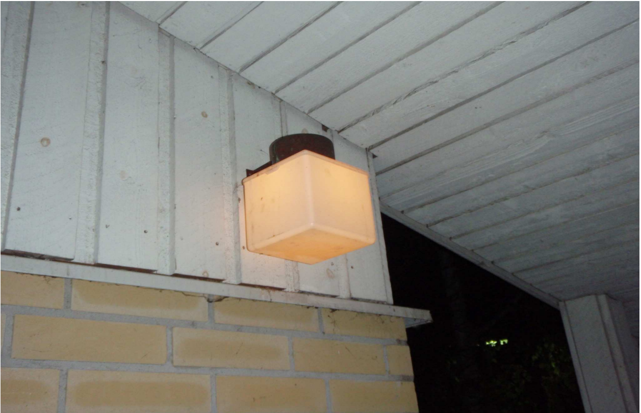
S- kuva 1. Sisäänkäynnin valaistus.
