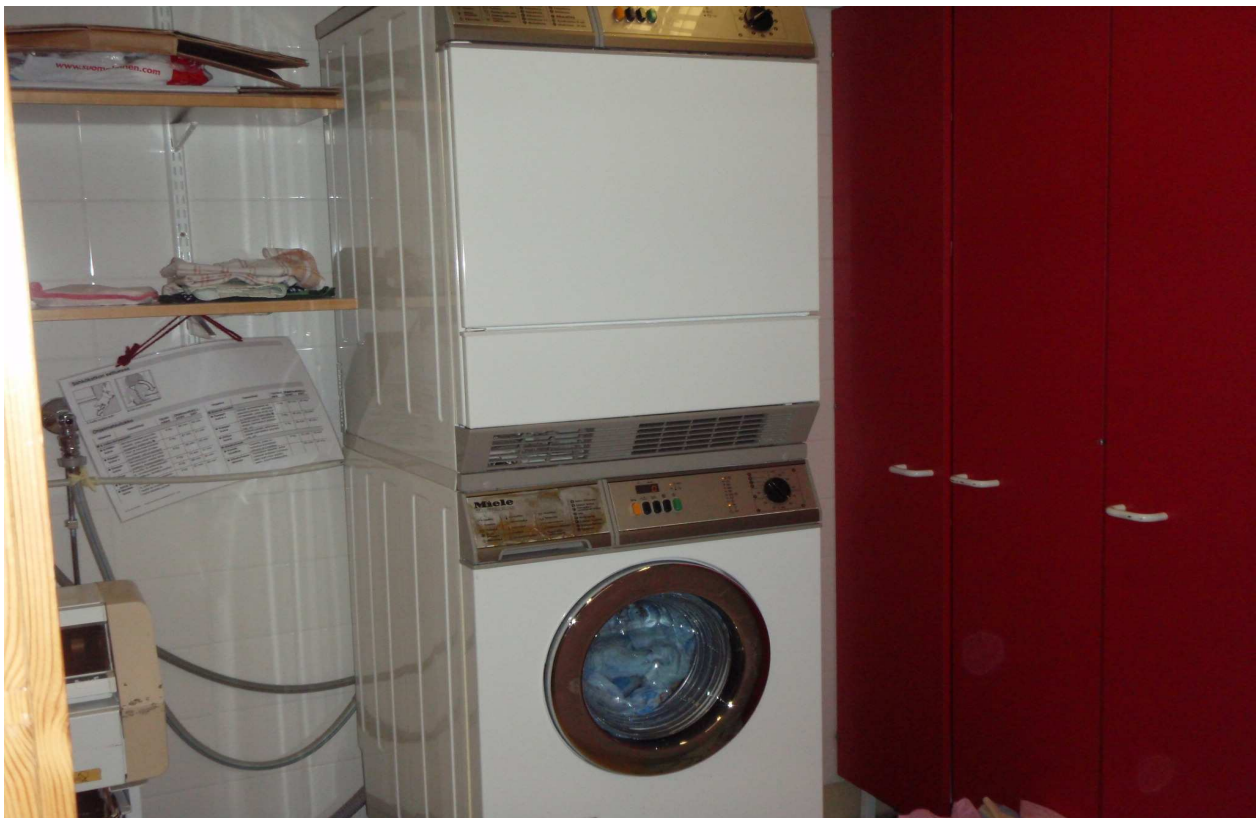
S- kuva 14. Pesukone ja kuivausrumpu.
