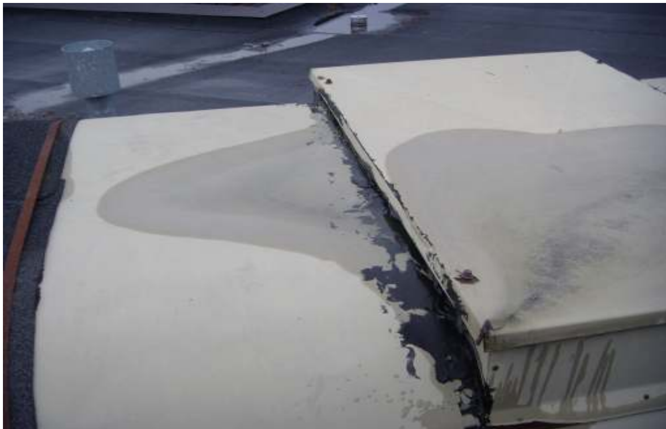
KUVA 11. Yleiskuva ilmastointikanavien suojaellityksestä.
