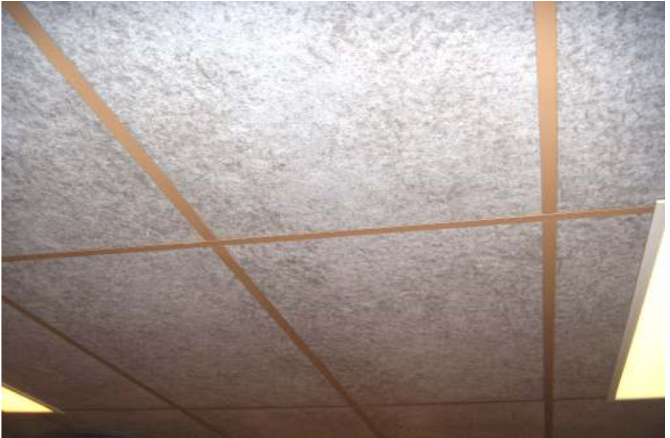
KUVA 17. Yleiskuva opettajienhuoneen katosta.
