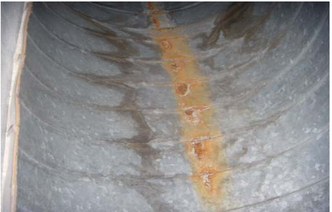
KUVA 8. Yleiskuva vesikatolla olevasta ilmastointikanavasta.
