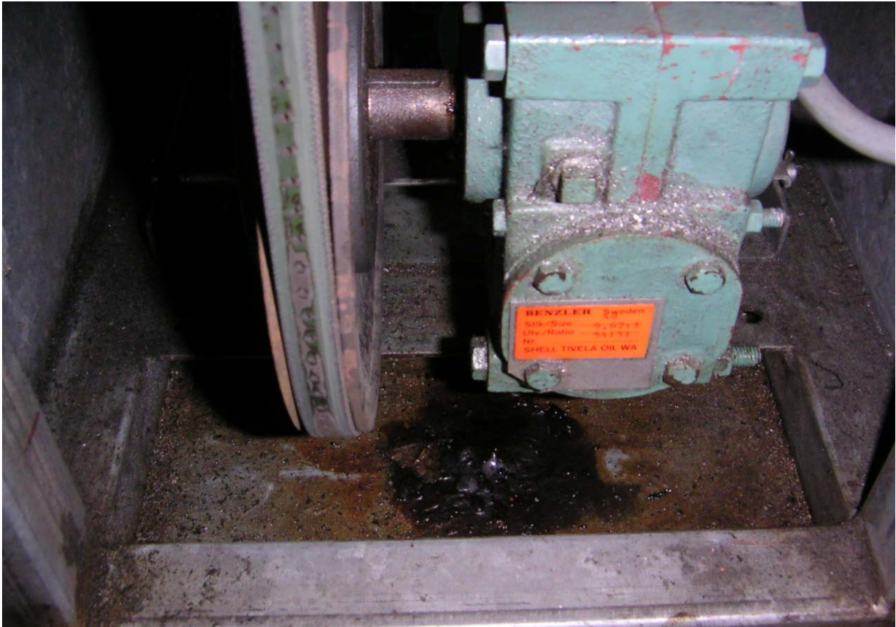
Kuva 5. LTO:n vaihteisto vuotaa.
