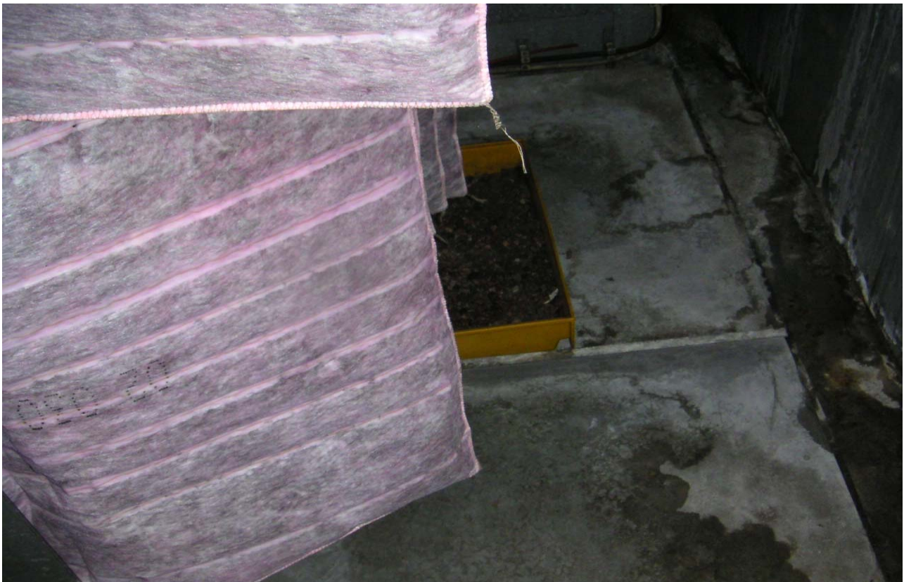
KUVA 8. Tuloilmakammiossa on hiekkalaattikko.
