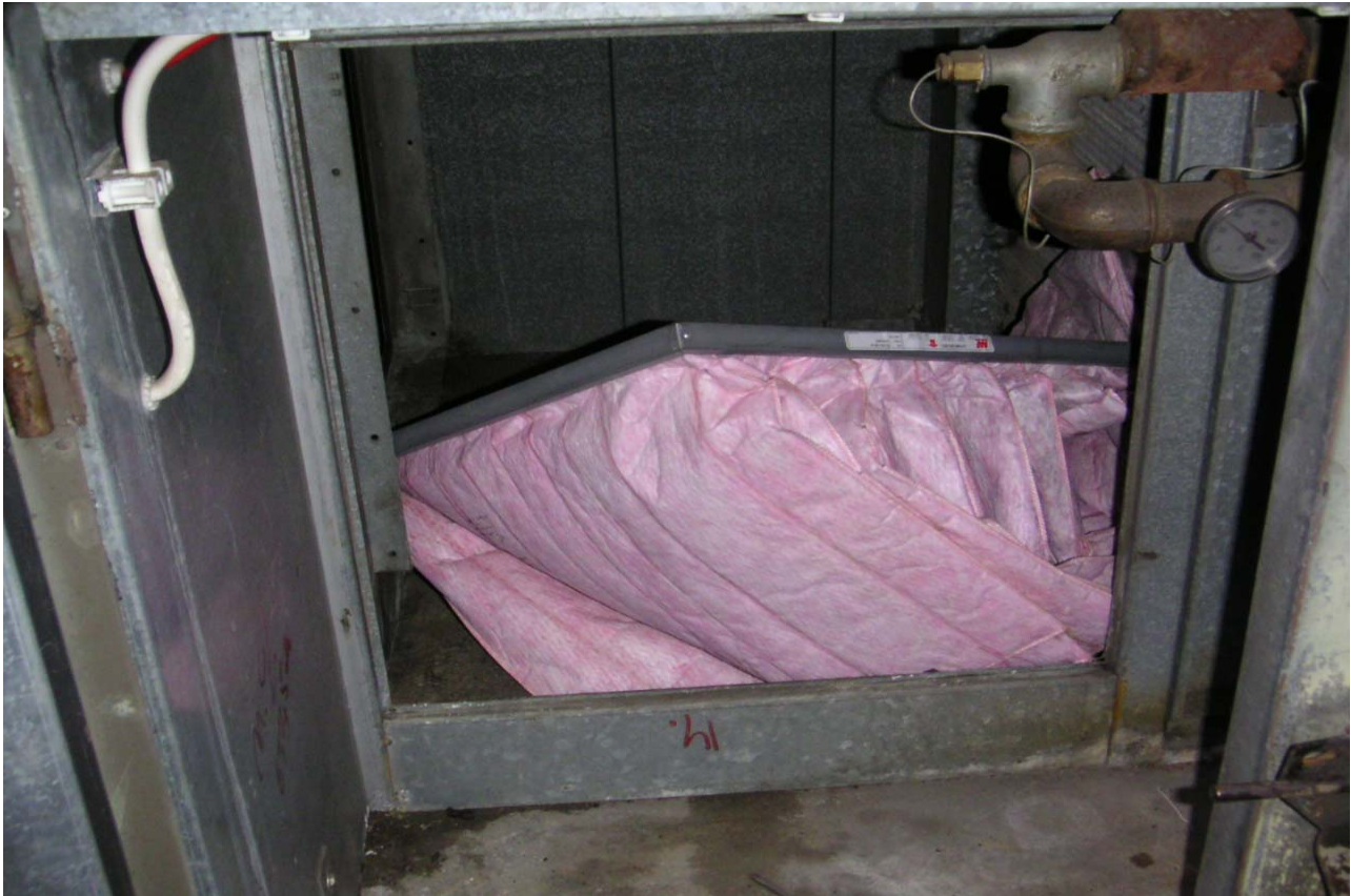
KUVA 9. Suodatin pääsee irtoamaan kehyksestä.
