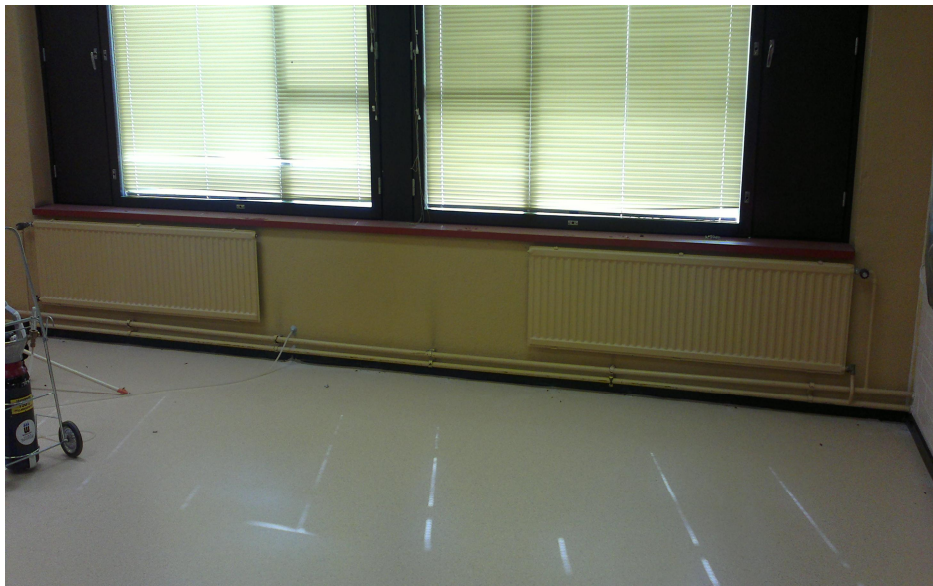
Kuva 4. Kuva luokkahuoneen 154 ikkunaseinältä.
