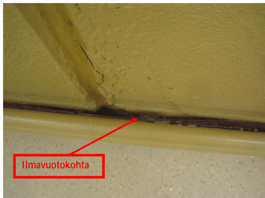
Kuva 3. Kuva on otettu 29.7 käynnin jälkeen tehtyjen korjausten jälkeen.
