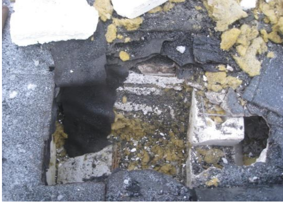
Kuvat 5 ja 6: Avaus 3. Kuvassa 5 on kantavien palkkien liitoskohta. Uuden bitumikermin alla on 2-kerroksinen ohut kumi. Kova villa vaikutti kostealta. Kuvassa 6 tuuletusrako.
