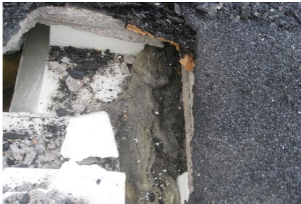
Kuvat 1 ja 2: Avaus 1. Kuvassa 1 Nilcon-laattojen välisissä saumoissa pehmeä villa on kauttaaltaan tummentunut. Kuvassa 2 tuuletusrako, Nilcon-laatassa pehmeä villa on normaaliväristä ja kuivaa.
