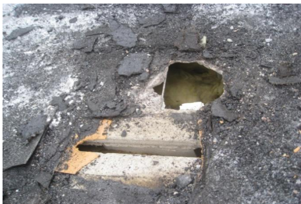
Kuvat 3 ja 4: Avaus 2. Kuvassa 3 Nilcon-laattojen välisissä saumoissa pehmeä villa vaikutti paikoitellen olevan kostea. Villa on kauttaaltaan tummentunut. Kuvassa 4 tuuletusrako, Nilcon-laatassa pehmeä villa on normaaliväristä ja kuiva.
