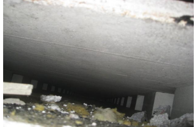
Kuvat 5 ja 6: Avaus 3. Kuvassa 5 on kantavien palkkien liitoskohta. Uuden bitumikermin alla on 2-kerroksinen ohut kumi. Kova villa vaikutti kostealta. Kuvassa 6 tuuletusrako.
