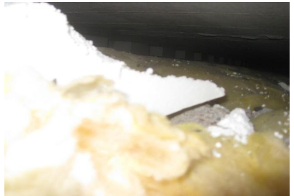
Kuvat 1 ja 2: Avaus 1. Kuvassa 1 Nilcon-laattojen välisissä saumoissa pehmeä villa on kauttaaltaan tummentunut. Kuvassa 2 tuuletusrako, Nilcon-laatassa pehmeä villa on normaaliväristä ja kuivaa.
