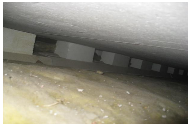
Kuvat 3 ja 4: Avaus 2. Kuvassa 3 Nilcon-laattojen välisissä saumoissa pehmeä villa vaikutti paikoitellen olevan kostea. Villa on kauttaaltaan tummentunut. Kuvassa 4 tuuletusrako, Nilcon-laatassa pehmeä villa on normaaliväristä ja kuiva.
