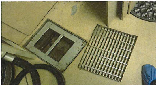
Kuva 5. Tilan 001 lattiakaivon vesilukko oli tyhjentynyt itseksensä.
