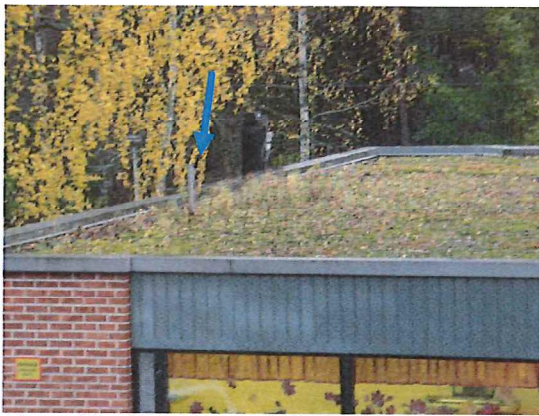
Kuva 10. Käytöstä poistettu tuuletusviemäri.
