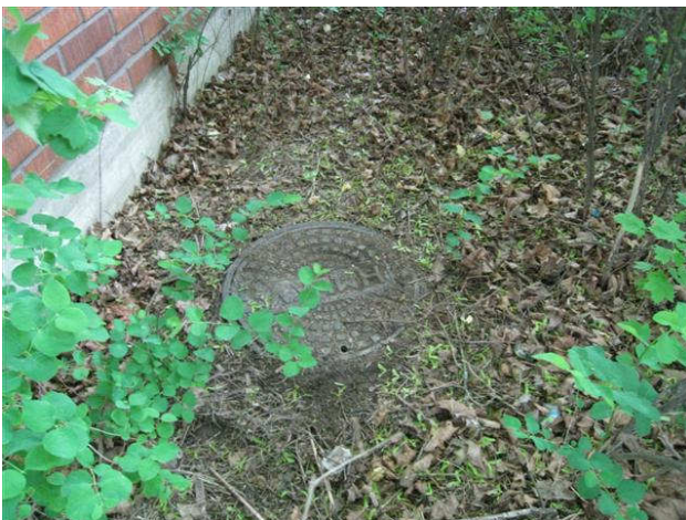
Kuva 53 Viemärikaivon tarkastusluukku A–B –talon päädyssä.
