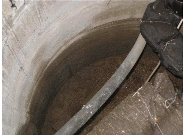
Kuva 56 Putkinousukaivon pohjalla oli hieman vettä.
