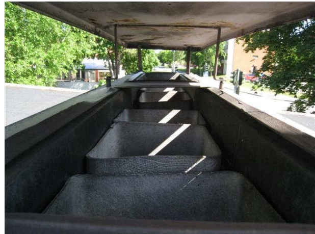
Kuva 4 IV -kanaviin pääsee vettä viistosateella.
