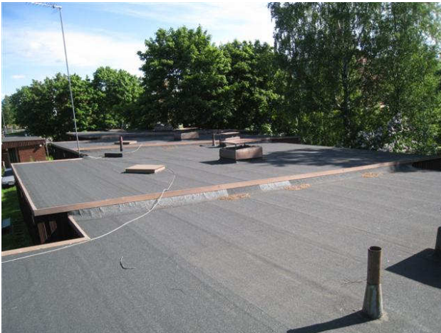
Kuva 15 Yleiskuva A–B –talon vesikatolta.
