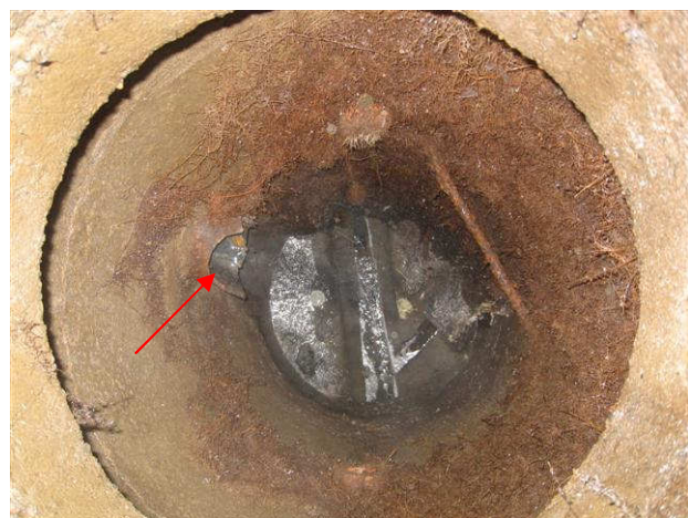
Kuva 54 A–B –talon viemärikaivossa on juuria, vasemmalta tulee A–B –talon viemäri, pohjalla muista taloista tulevia viemäreitä.
