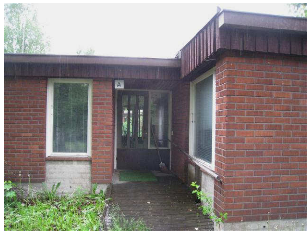
Kuva 28 Tyypillinen sisäänkäynti ja vanha puinen luiska.
