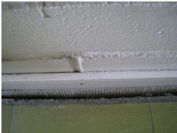
Kuva 45 Peruslaatan liikuntasauaman rako
