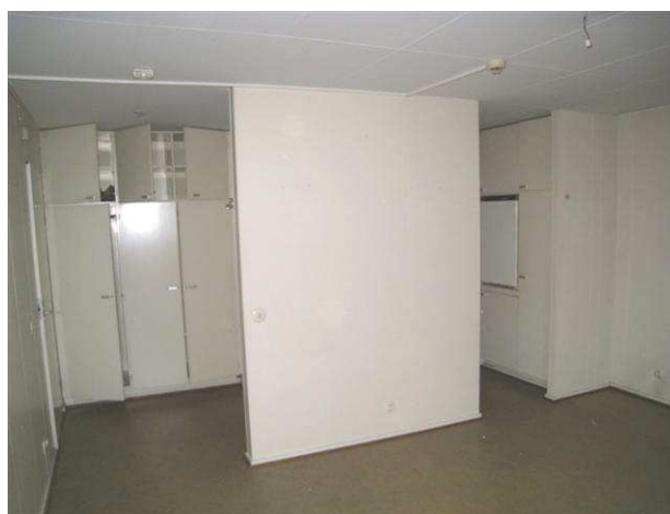
Kuva 34 Vasemmalla eteistila, keskellä wc-suihku-tila ja oikealla keittokomero
