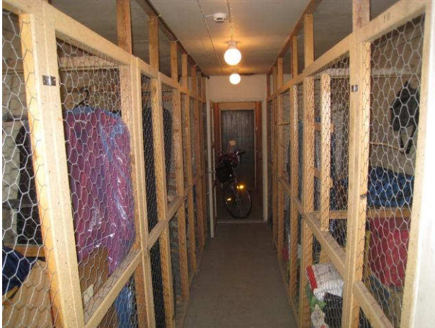
Kuva 49 Talokohtainen yhteinen varastotila, jossa on asuntojen häkkivarastot.
