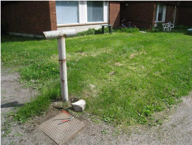
Kuva 51 Putkikanaalin luukku ja tuuletusputki huoltorakennuksen edessä.
