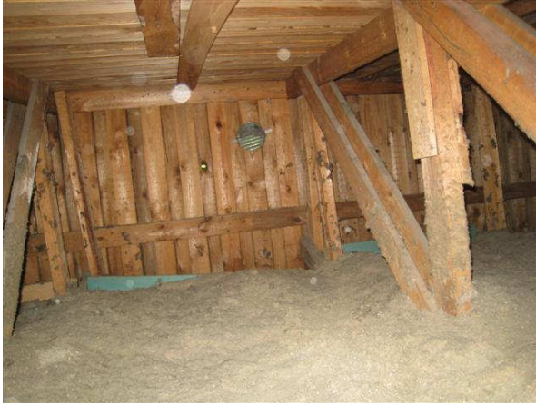
Kuva 19 Yläpohjaontelo, jossa on lisätty puhallusvillaa alkup. eristeiden päälle.
