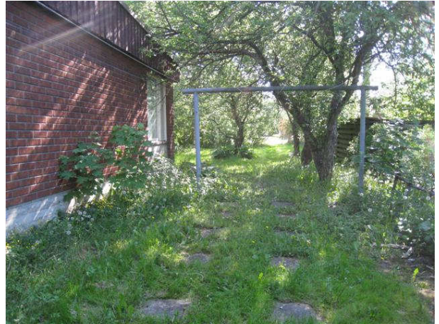
Kuva 58 Kuivausteline ja painuneet betonilaatitukset.
