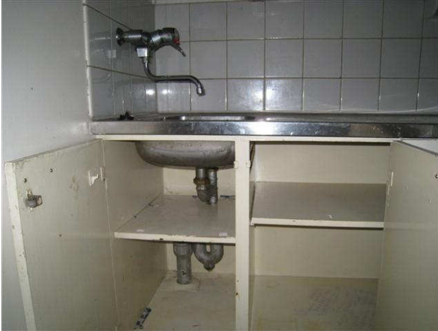
Kuva 37 Alkuperäiset keittiökalusteet ja valurautainen vesilukko.
