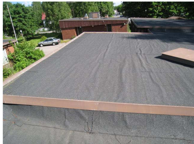
Kuva 16 Joskus uusittu pintahuopa on poimuillut.
