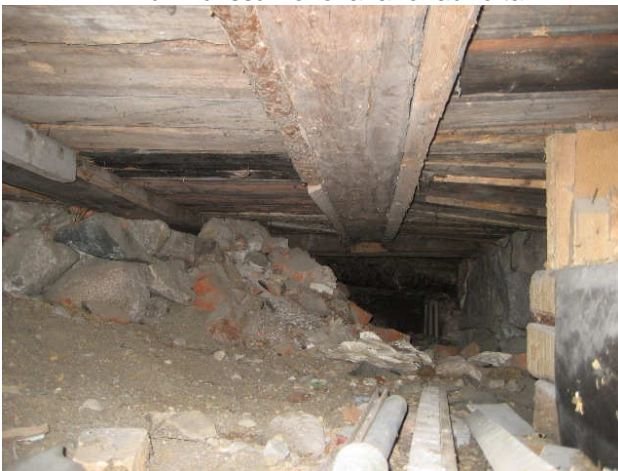
Kuva 7 Näkymä länsisivun kulkuluukusta alustatilaan Orvokkitien suuntaan. Ryömintätila on ahdas ja siellä on rojua ja purkutiiliä.
