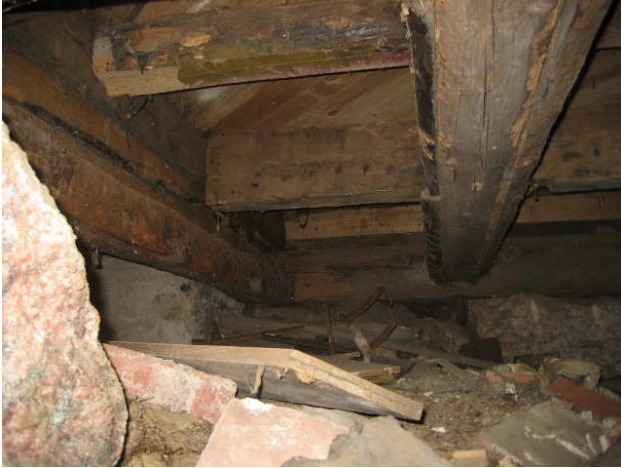
Kuva 9 Näkymä alustan länsisivun luoteiskulmalle. Rakenteet ovat kuivia.
