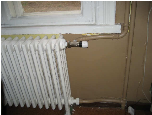
Kuva 35 Patteriputkia on alapohjarakenteessa mm. itäsivun oleskelutilan kohdalla.
