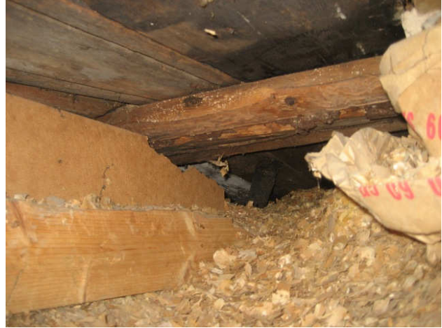
Kuva 10 Näkymä luukusta oikealle, jossa alkuperäisen alapohjan alle on lisätty kutterinpurua..
