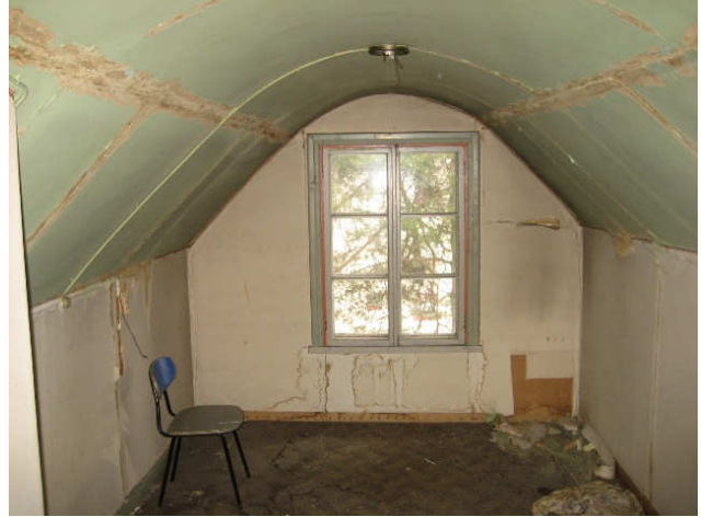
Kuva 22 Yleiskuva kuistin päällä olevasta huoneesta Orvokkitien puolella.
