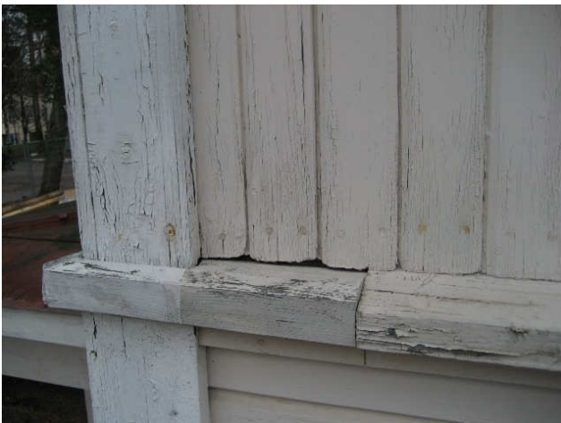
Kuva 13 Luoteiskulmalla oleva jakolistan jatkos on huonosti tehty.
