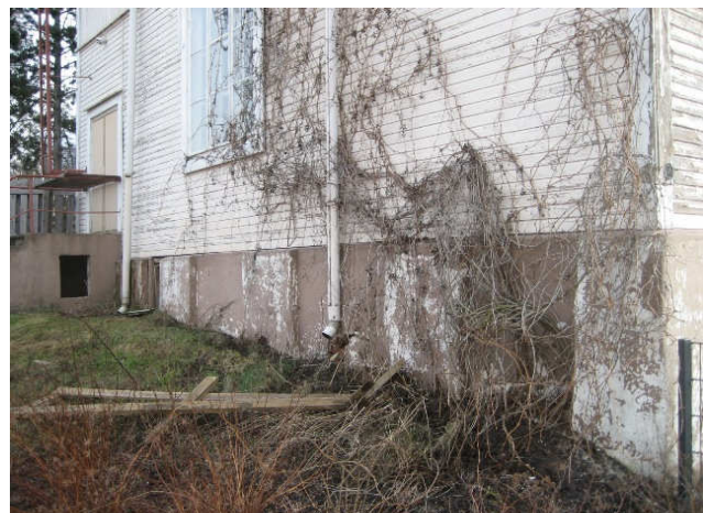
Kuva 2 Länsisivulla sokkeli vieressä on multa- maata ja istutuksia. Taustalla olevien portaiden vierestä on kulkuluukku alustatilaan.
