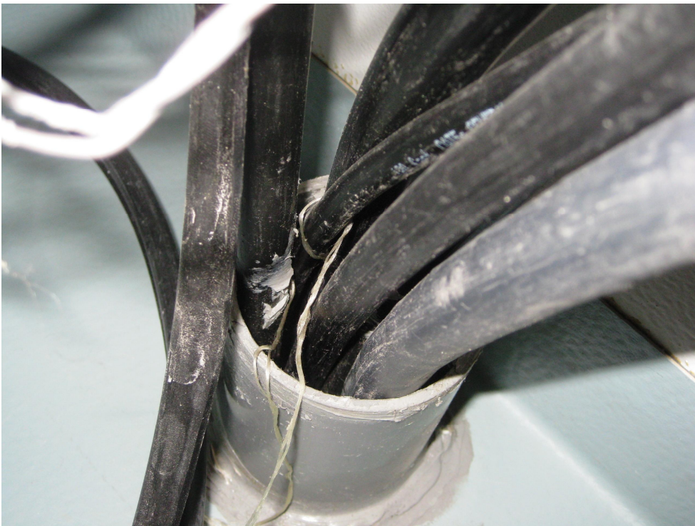
Kuva 2. Kaapeliläpiviennin suojaputkessa olevien kaapeleiden välit ja kaapelipun ja suojaputken väli tiivistetään Hilti CFS-F FX palokatkoavaahdolla materiaalivalmistajan ohjeiden mukaan.
