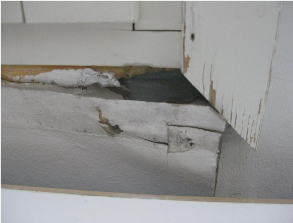
Kuva 7. Kosteudesta vaurioituneet ikkunalistoitukset ja ikkuna alapuoliset levytykset vaihdetaan uusiin.
