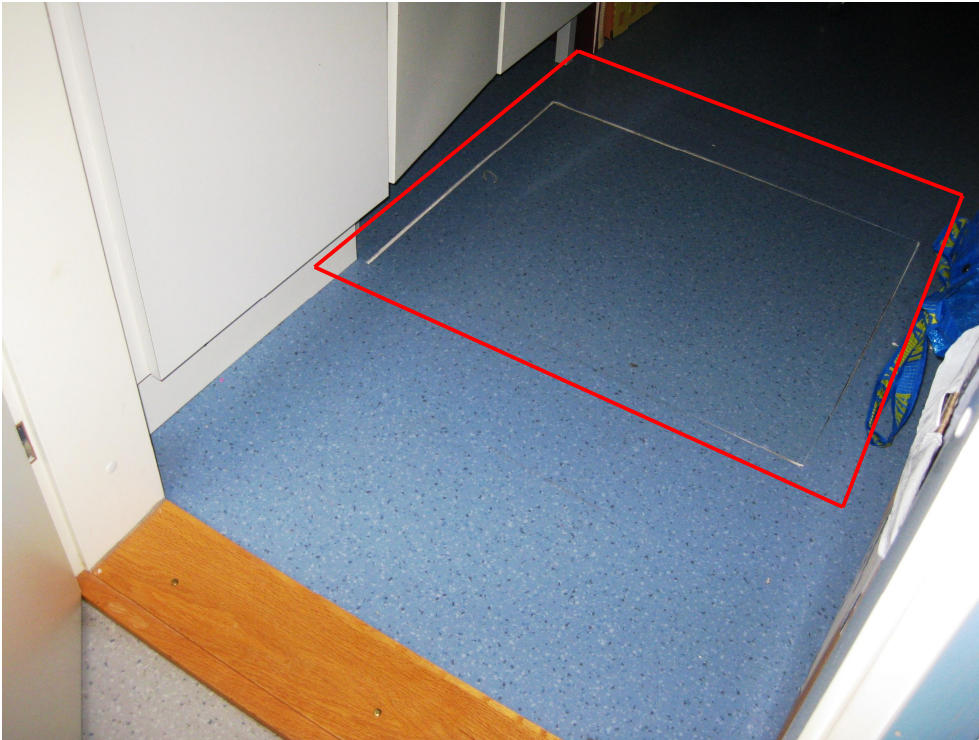
Kuva 3. Opetusvälinevarastossa 131 oleva alustatilan kulkuluukku.
