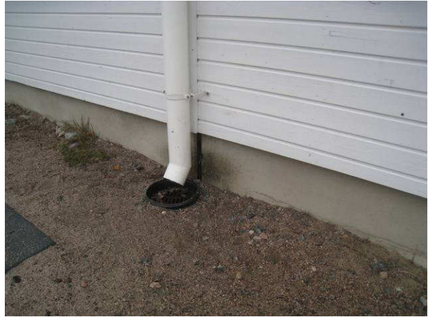
Kuva 8 Eteläsivun maanpinta on tasainen.
