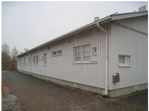
Kuva 6 Pohjoissivun luoteiskulma ja venttiilit sokkelissa.
