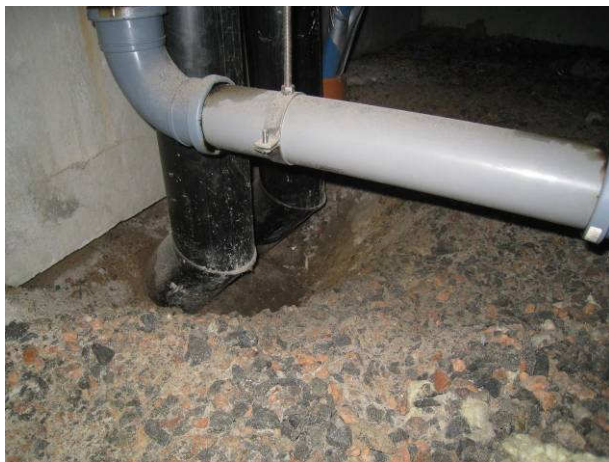
Kuva 5 Lämpöputkien nousukohta sokkelipalkin alta länsipäädyssä.
