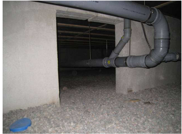
Kuva 2 Kulkuaukot ontelosta toiseen.
