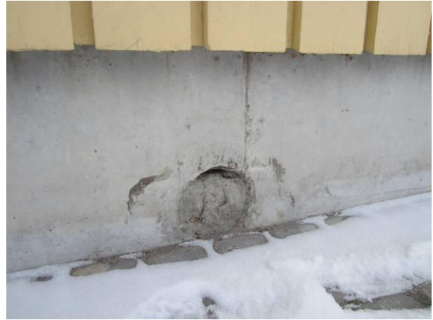
Kuva 4 Laastilla tukittu entinen korvausilmaputken reikä.
