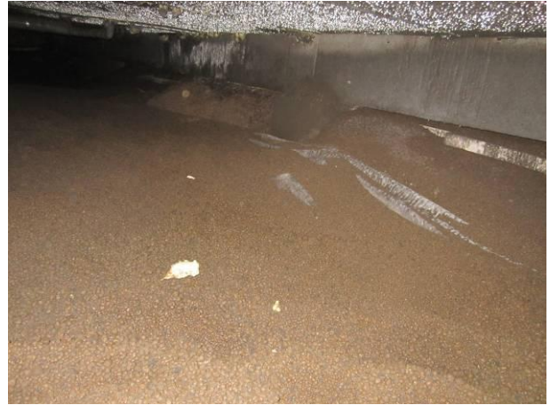
Kuva 16 Tilan Prh 05 alla on vesilammikko kevytsoran sisällä
