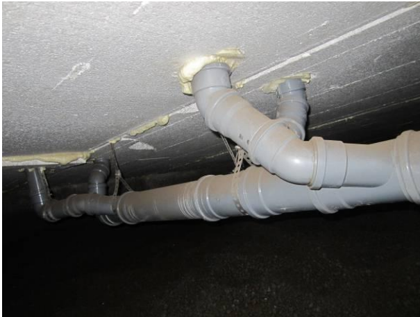
Kuva 21 Viemärläpiviennit on tiivistetty pääosin hyvin.
