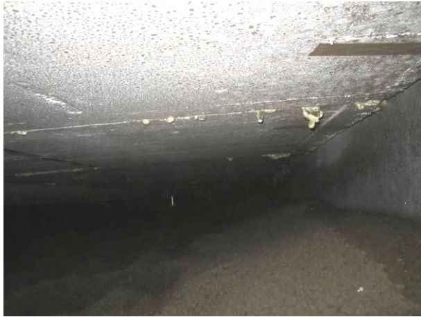
Kuva 13 Vastatäyttö tilan RH 50 alla
