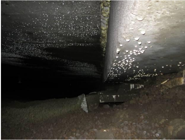
Kuva 15 Vastatäyttöä ei ole.
