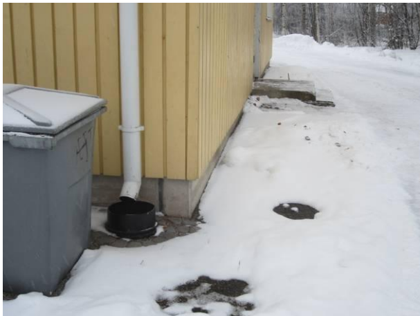
Kuva 1 Perusvesikaivolta vaikuttava kansi.
