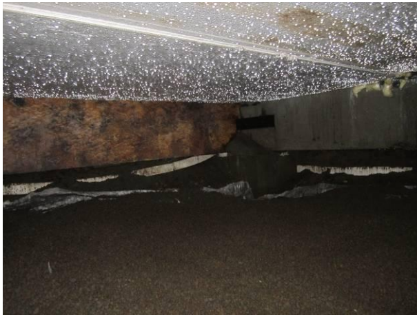
Kuva 17 Leikkih. 01 kulmaus, jossa on vaneria ja kosteaa. tilan korkeus 1-1,1 metriä.
