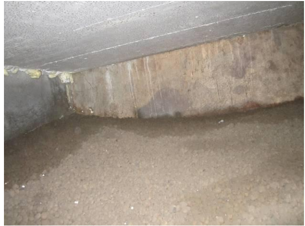
Kuva 14 Muottivaneria tila Lepoh 52 alla.
