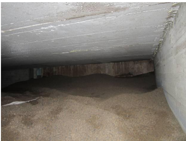
Kuva 11 Yhteishalli 40 alustatila, muuten ~ok, mutta on hieman muottivaneria.
