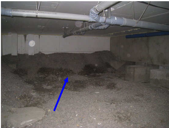
Kuva 3 Kostea sepeliä vastatäytön alaosalla.
