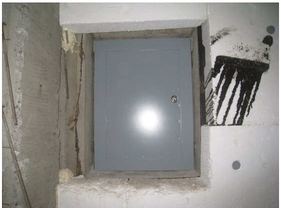
Kuva 18 Alustatilasta luukku porrashuoneen portaiden alle.
