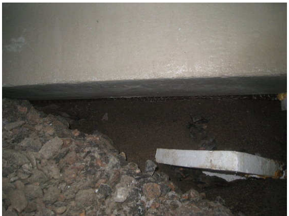
Kuva 16 Sokkeli-elementin ulkopinnassa on pato-levyt. Kostea hiekkaa.
