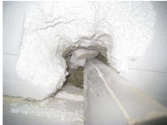
Kuva 10 Tyypillinen tiivistämätön läpivienti.
