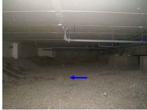
Kuva 2 Täyttönä on karkeaa hienoainesta sisältävää sepeliä. Viettää sokkeli-elementtejä kohden.
