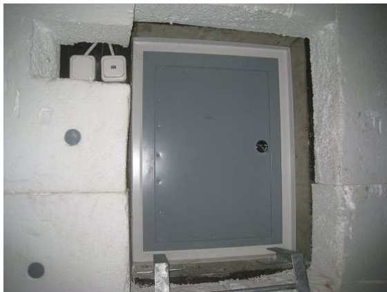
Kuva 17 C-osan alustatilan sisäänkäynti on lämmönjakuhuoneen kautta.
