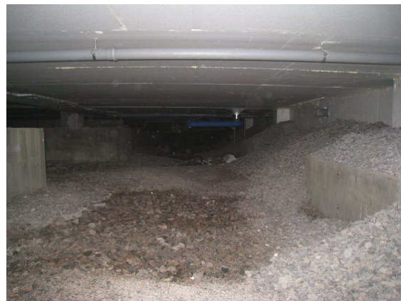
Kuva 12 Kosteaa sepeliä. Taaempänä pienellä alueella rakennusjätettä.
