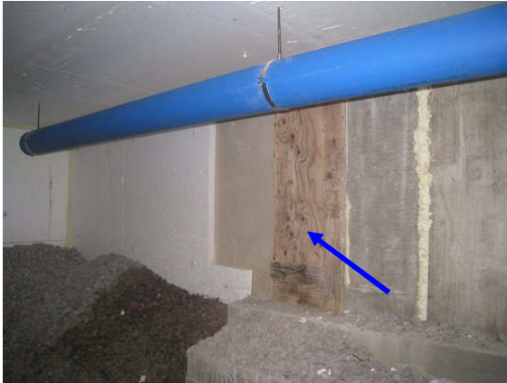
Kuva 7 Sokkelielementissä kiinni vanerilevyä.
