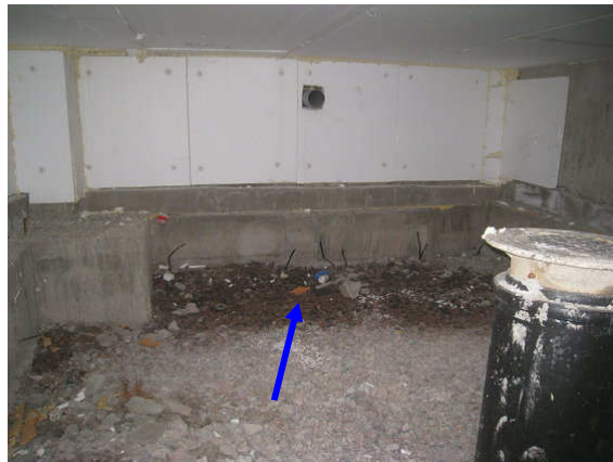
Kuva 4 Kostea sepeliä. Sokkeli-elementissä korvausilmaventtiili.
