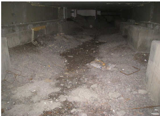
Kuva 5 Kostea sepeliä, pinnalla laastisäkki.
