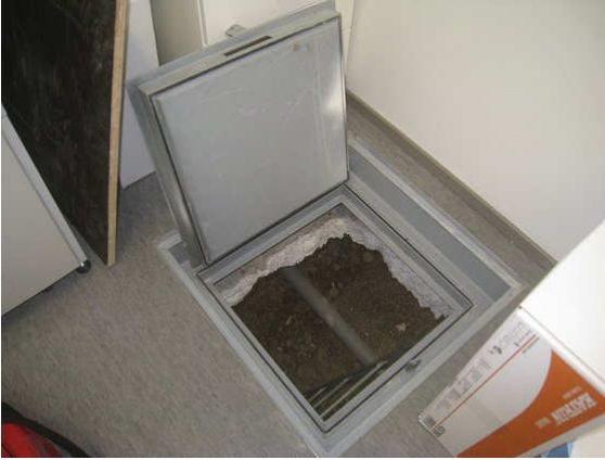
Kuva 1 Lattialuukku A-osan alustatilaan.
