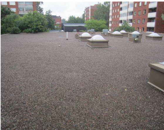
Yleiskuvaa kohteen vesikatteelta.
