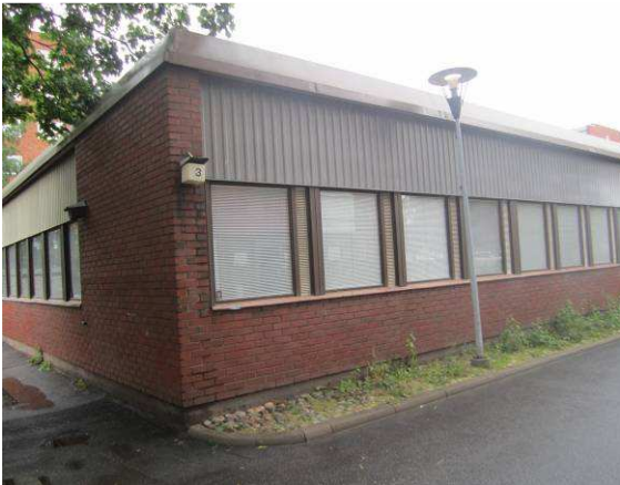
Yleiskuvaa rakennuksen tiili-/peltiverhoillusta julkisivusta.
