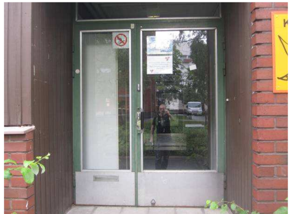
Metallirakenteiset ulko-ovet ovat alkuperäisiä.
