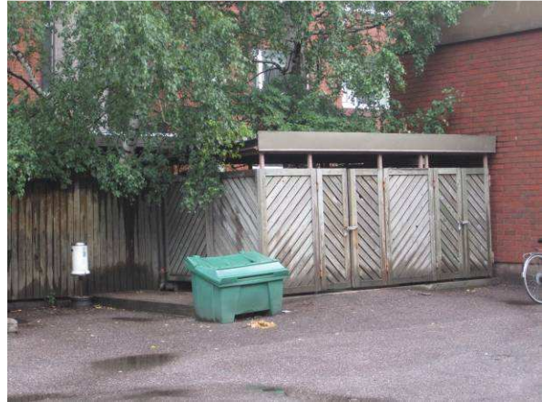
Jäteastiat sijaitsevat puu-/metallirakenteisessa katoksessa.
