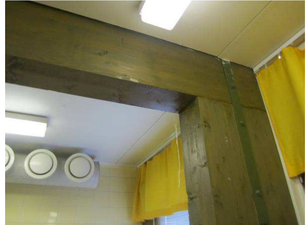
Kantava runko koostuu liimapuu pilareista ja palkeista.
