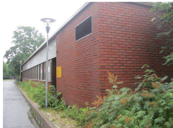
Rakennuksen seinustoilla on osin kiveys.
