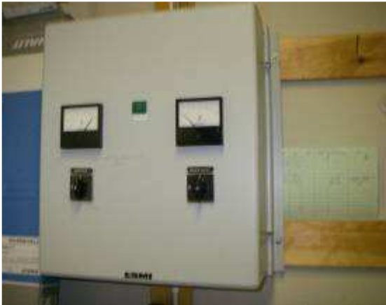
Turvavalokeskus sähköpääkeskuksilassa
