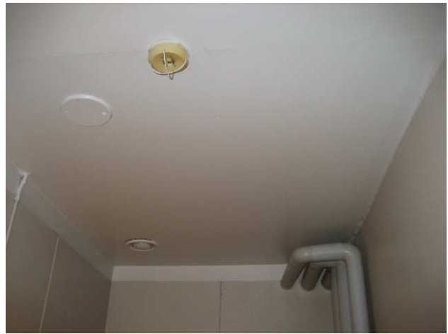
Kuva 16 Wc-tilan 028 pinnat on kunnostettu.
