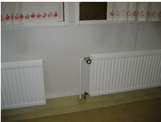
Kuva 7 Keittiöön on tehty korjausten yhteydessä betonista nk. holkkalista.
