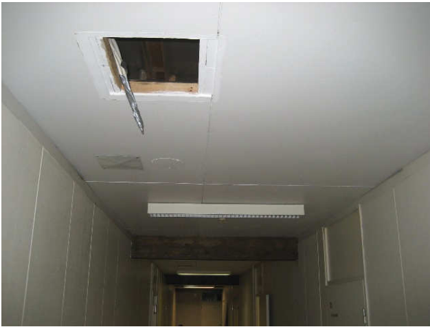
Kuva 17 Alakaton kattoluukku käytävällä 007.
