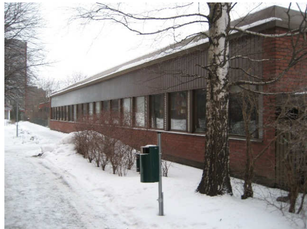
Kuva 2 Länsisivulla viereinen piha on ylempänä ja maanpinta rakennusvierellä on tasainen. Salaojakaivoja ei havaittu.
