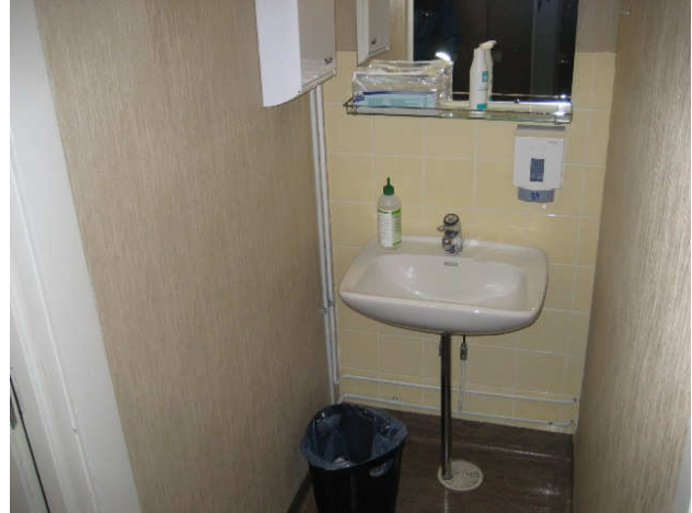
Kuva 10 Sosiaalitalan pintarakenteita, lattiassa on vesieristeenä muovimatto ja seinissä on muovitapettia ja laatoitusta.
