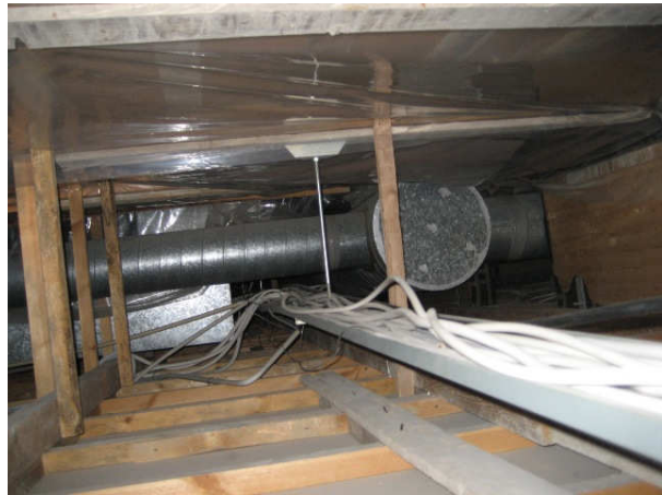
Kuva 22 Näkymä alakattotilaan käytävältä 039.
