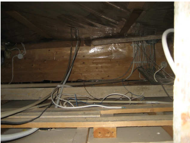
Kuva 19 Näkymä alakaton päälle käyt. 007.
