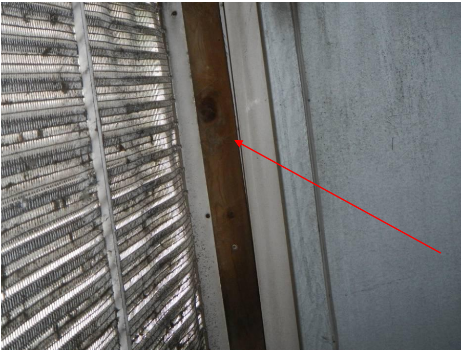
Kuva 13. Raitisilmakammion sisällä on lautarunko näkyvillä, joka voi toimia mikrobin kasvualustana.
