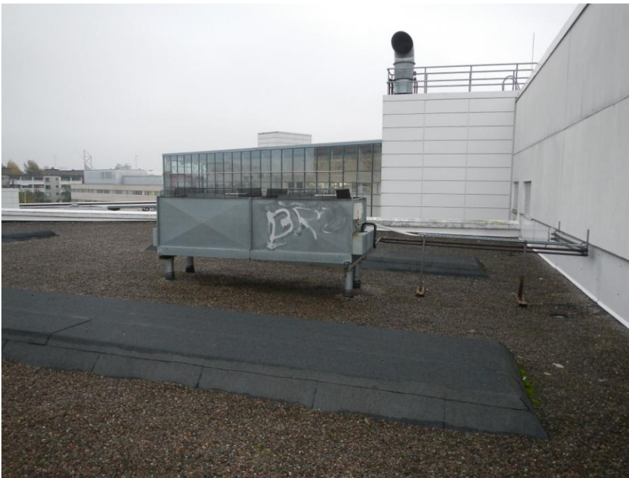
Kuva 34. Yleiskuva LA30 ilmalauhduttimesta.
