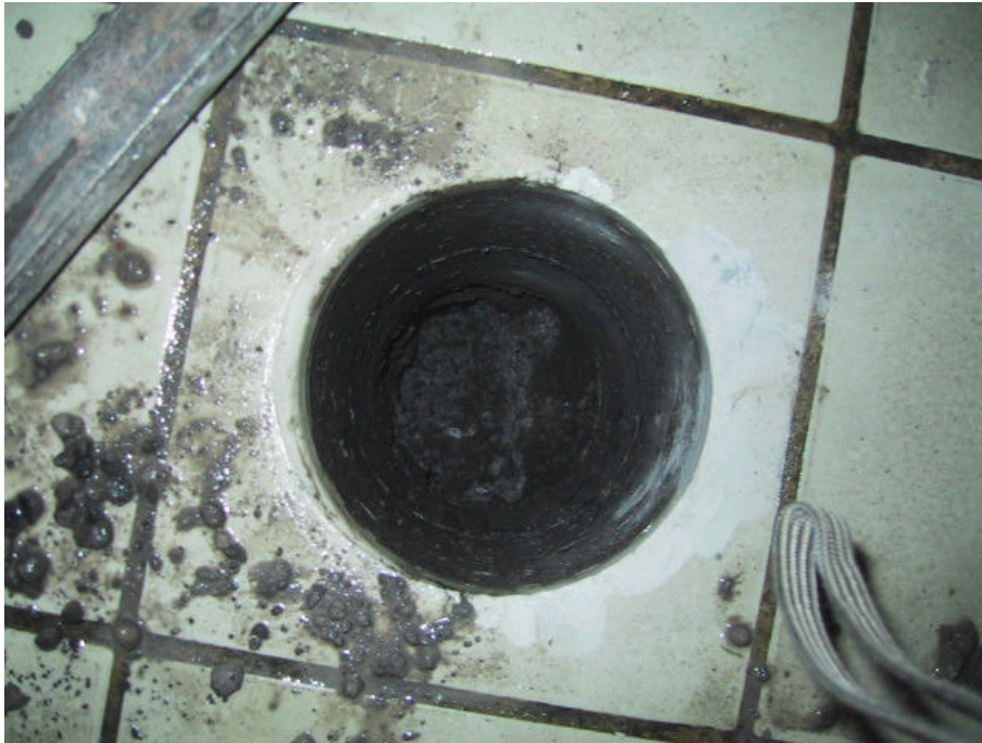
Kuva 1 Alapohjan avauskohta huonetilasta 106 Yleisö-WC Naiset.
