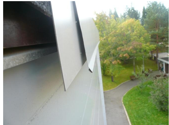
Kuvat 66 ja 67. Kermi on käännetty seinälinjan yli. Seinällä on myrskypelti
