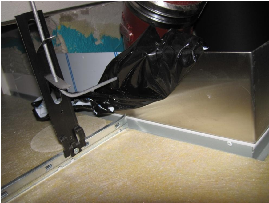
Kuva 21. Vesi valunut muovia pitkin akustiikkalevyn päälle
