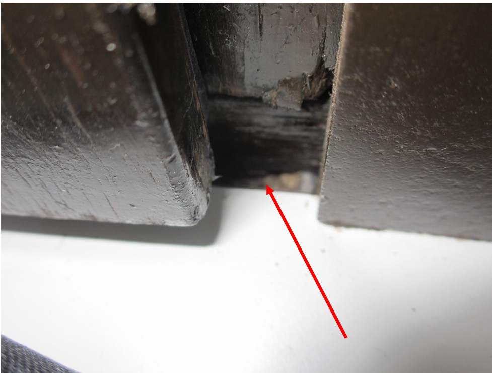
Kuva 2. Ikkunan alakarmin ja ikkunapenkin välissä oli rako, josta mitattiin voimakasta ilmavuotoa merkkiainekokeessa.
