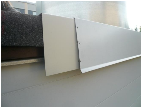
Kuvat 66 ja 67. Kermi on käännetty seinälinjan yli. Seinällä on myrskypelti
