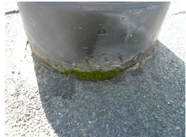
Kuvat 56 ja 57. Läpivientien juuriin pääsee vettä ja siitä johtuen läpiviennin juuressa kasvaa osin myös sammalta
