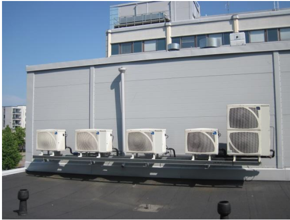
Kuvat 58 ja 59. IV-konehuoneen seinän läpivientejä. Läpiviennit olivat paikoin epätiivitä
