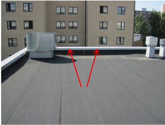
Kuvat 64 ja 65. Peltiä avattiin nuolten väliseltä alueelta. Oikeanpuoleisessa kuvassa päällimmäinen pelti on poistettu
