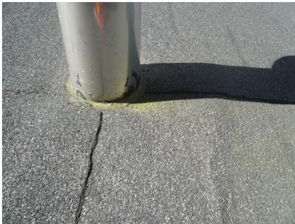
Kuvat 34 ja 35. Läpivientien juuriin pääsee vettä ja siitä johtuen läpiviennin juuressa kasvaa osin myös sammalta. Kermikate kallistuu paikoin läpivientiin päin
