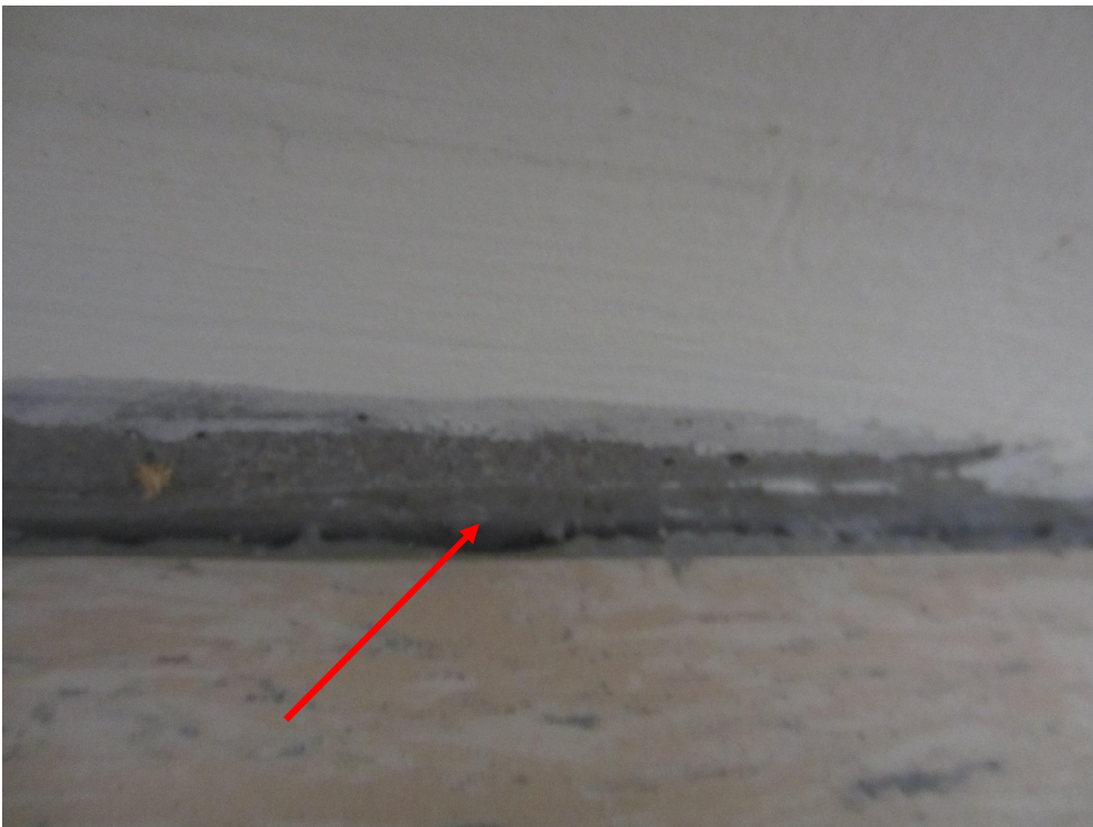
Kuva 5. Jalkalistan irrotuksen jälkeen päivähoitotiloista tutkitun huoneen (152) lattia-seinäliitymässä havaittiin halkeama, josta mitattiin merkkiainekokeessa voimakasta ilmavuotoa.
