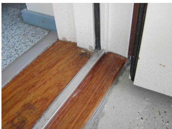
Kuvat 12 ja 13. Kynnyksen ja parvekelaatan välinen sauma on rakoille
