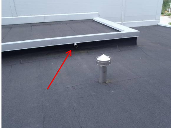
Kuvat 36 ja 37. Vedenojjausputki
