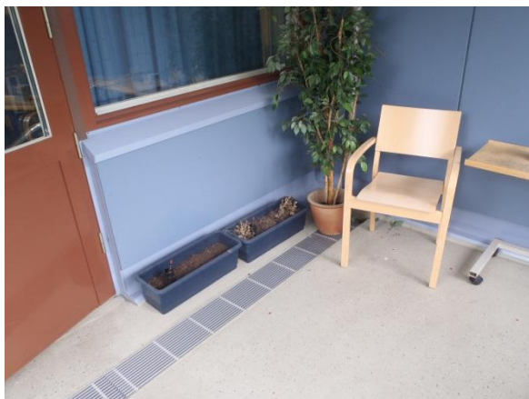
Kuvat 8 ja 9. Ulkoseinän alaosan pellitystä
