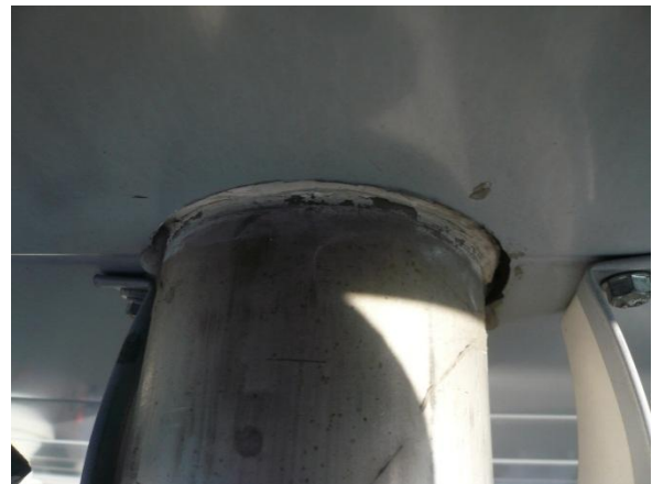
Kuvat 58 ja 59. IV-konehuoneen seinän läpivientejä. Läpiviennit olivat paikoin epätiivitä
