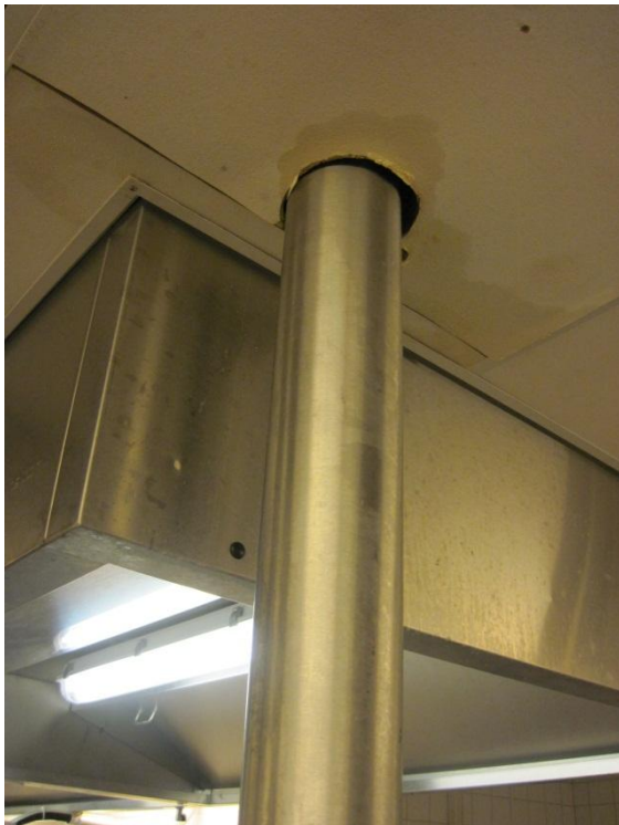
Kuvat 24 ja 25. Biojäteputki
