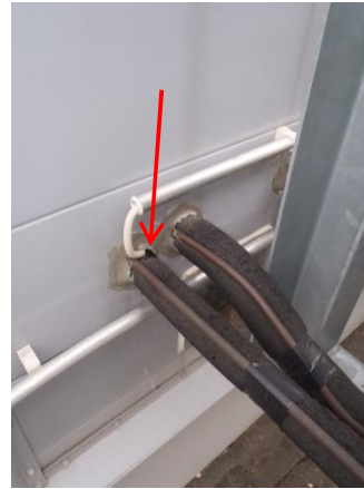
Kuvat 58 ja 59. IV-konehuoneen seinän läpivientejä. Läpiviennit olivat paikoin epätiivitä
