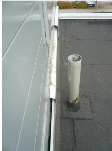
Kuvat 32 ja 33. Rakenneavaus moduulilinjalta E. Läpivientilaippa puuttuu, läpivientiä tiivistetty bitumermillä. Kuvan 33 läpivienti on
