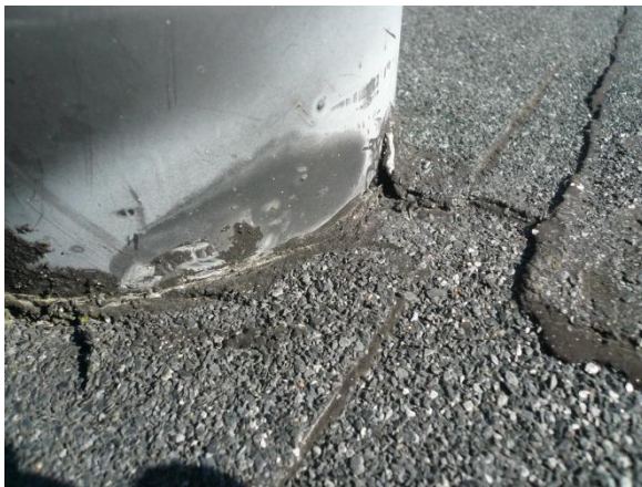
Kuvat 56 ja 57. Läpivientien juuriin pääsee vettä ja siitä johtuen läpiviennin juuressa kasvaa osin myös sammalta
