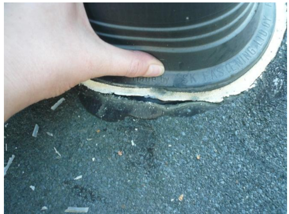
Kuvat 54 ja 55. Vasemman puoleisessa kuvassa vesikaton läpivientejä. Oikeanpuoleisessa kuvassa läpivienti syöksytorven vierestä
