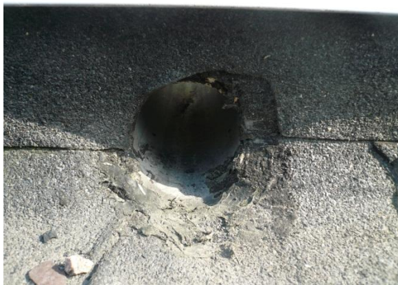
Kuvat 38 ja 39. Bitumikermi on irti putken ympäriltä
