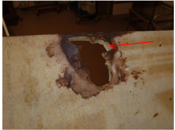
Kuvat 22 ja 23. Akustiikkalevyn alapinta ja yläpinta. Nuolen kohdalla otettiin materiaalinäyte 1.
