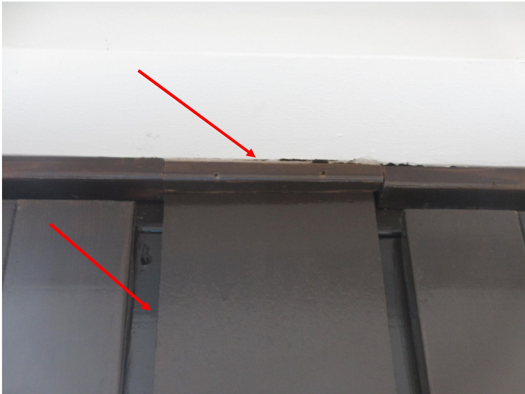
Kuva 3. Ikkunoiden välissä olevan peitelistan alta sekä peitelistan ja ikkunan yläpuolisen pielirakenteen välistä mitattiin merkkiainekokeessa voimakasta ilmavuotoa.
