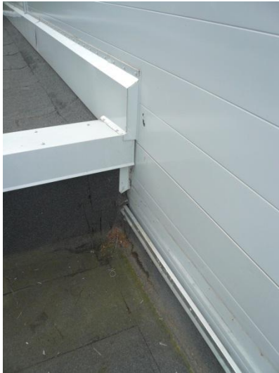
Kuvat 32 ja 33. Rakenneavaus moduulilinjalta E. Läpivientilaippa puuttuu, läpivientiä tiivistetty bitumermillä. Kuvan 33 läpivienti on
