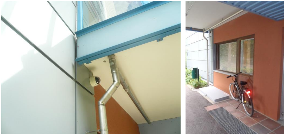
Kuvat 6 ja 7. Parvekelaatan ja seinän liittymä alapuolelta
