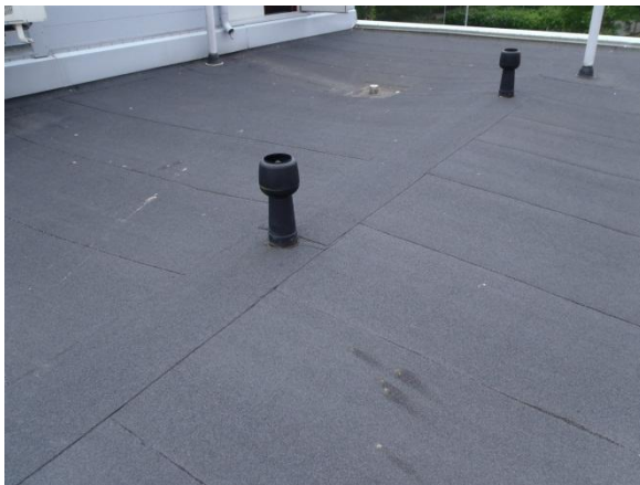
Kuvat 54 ja 55. Vasemman puoleisessa kuvassa vesikaton läpivientejä. Oikeanpuoleisessa kuvassa läpivienti syöksytorven vierestä
