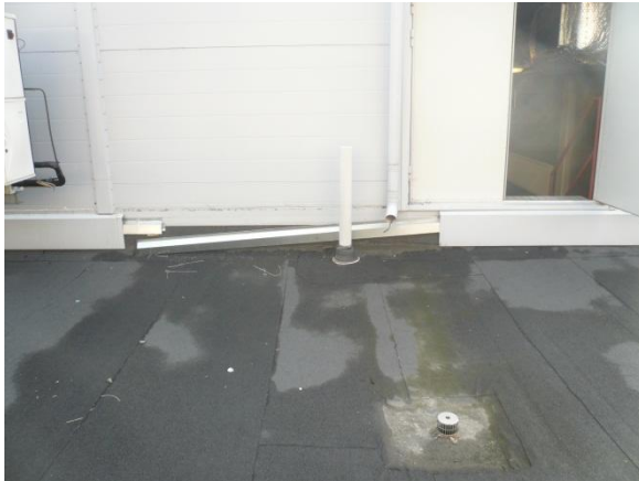
Kuva 50. Juuripellitystä avattiin IV-konehuoneen oven vierestä
