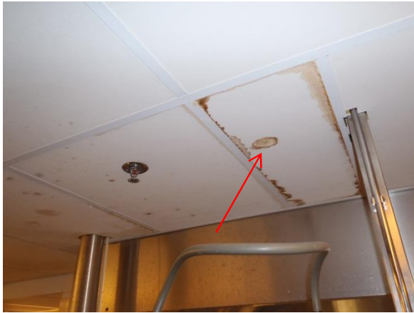
Kuvat 22 ja 23. Akustiikkalevyn alapinta ja yläpinta. Nuolen kohdalla otettiin materiaalinäyte 1.
