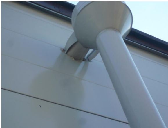
Kuvat 60 ja 61. Syöksytorven ja seinän liitos on epätiivis.
