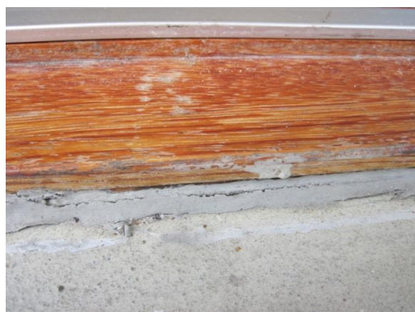
Kuvat 12 ja 13. Kynnyksen ja parvekelaatan välinen sauma on rakoille
