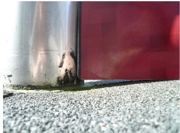
Kuvat 34 ja 35. Läpivientien juuriin pääsee vettä ja siitä johtuen läpiviennin juuressa kasvaa osin myös sammalta. Kermikate kallistuu paikoin läpivientiin päin
