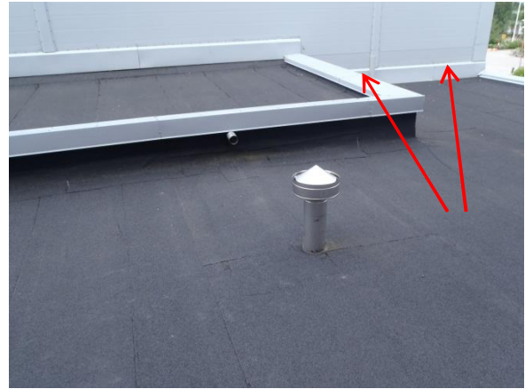
Kuvat 30 ja 31. IV-konehuoneen seinä moduulilinjalta E. Juuripellitystä avattiin nuolien väliseltä alueelta
