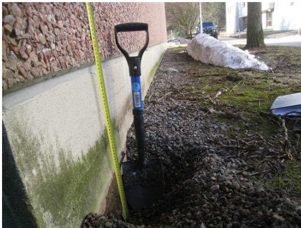
Kuva 3 Sokkelin vierellä on mursketta n. 20 cm, sitten on tiivistä maata.
