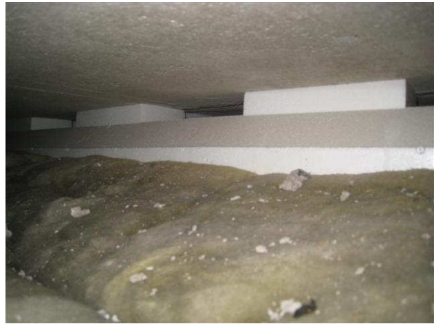
Kuva 26 Nilcon-laatan onteloa ja villoitusta tuule- tusputken kautta kuvattuna.
