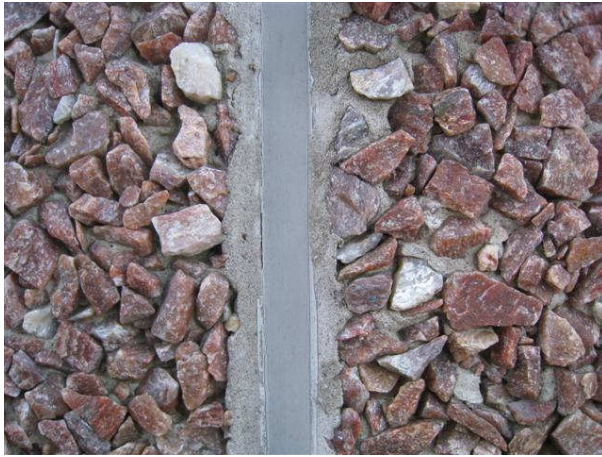
Kuva 9 Pesubetonipinta vaikutti ehjältä ja saumaukset on uusittu.
