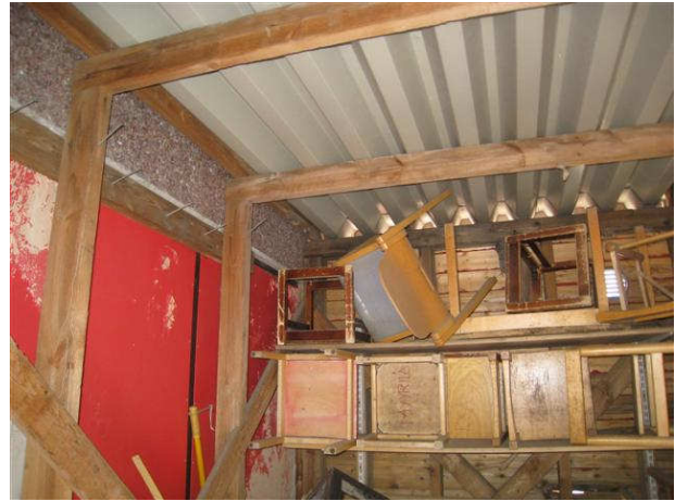
Kuva 14 Eteläsivun varaston kattorunko.
