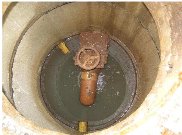
Kuva 6 Perusvesikaivossa salaojien päät, vesipinta/ juoksup. on n. 145 maanpinnasta.
