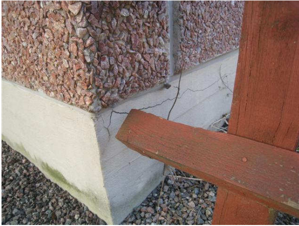
Kuva 7 Sokkelin halkeamavaurio.
