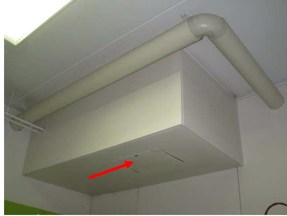
Kuva 22 Kosteusvaurioitunutta lastulevyä.
