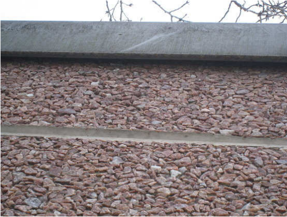
Kuva 15 Rästäspelien etäisyys vaihtelee julkisivuun nähden.
