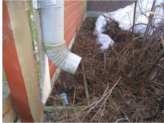
Kuva 16 Varastojen katolta vedenpoisto sokkelin juureen.
