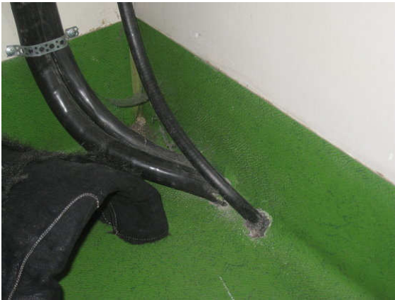
Kuva 23 Tiivistämättömiä läpivientejä.
