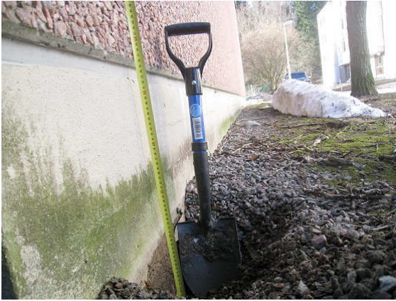
Kuva 3 Sokkelin vierellä n. 200 mm murskettua ja sitten tiivistä maata.
