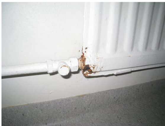
Kuva 29 Lähes puhkiruostunut patteri.
