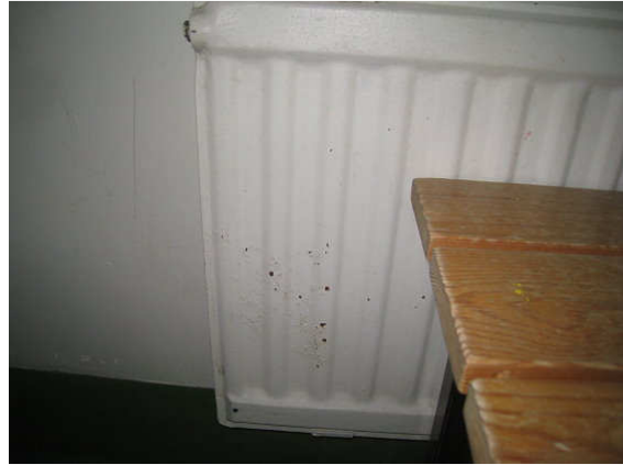
Kuva 28 Patterissa ruostetta.
