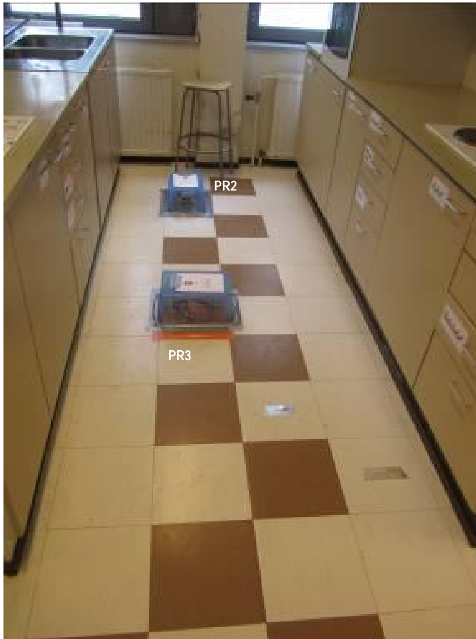
Kuva 10. Esimerkki opetuskeittiö 104 lattiarakenteen porareikämittauksista. Mittaukset käynnissä mittapisteissä PR2 ja PR3. Porareikämittapisteet on suojattu mittausten ajaksi mittapistesuojalaatikoilla.
