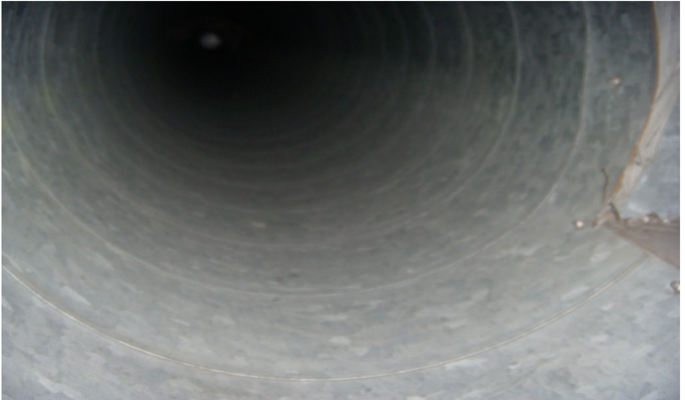
KUVA 17. Yleiskuva nuohotusta tuloilmakanavasta.
