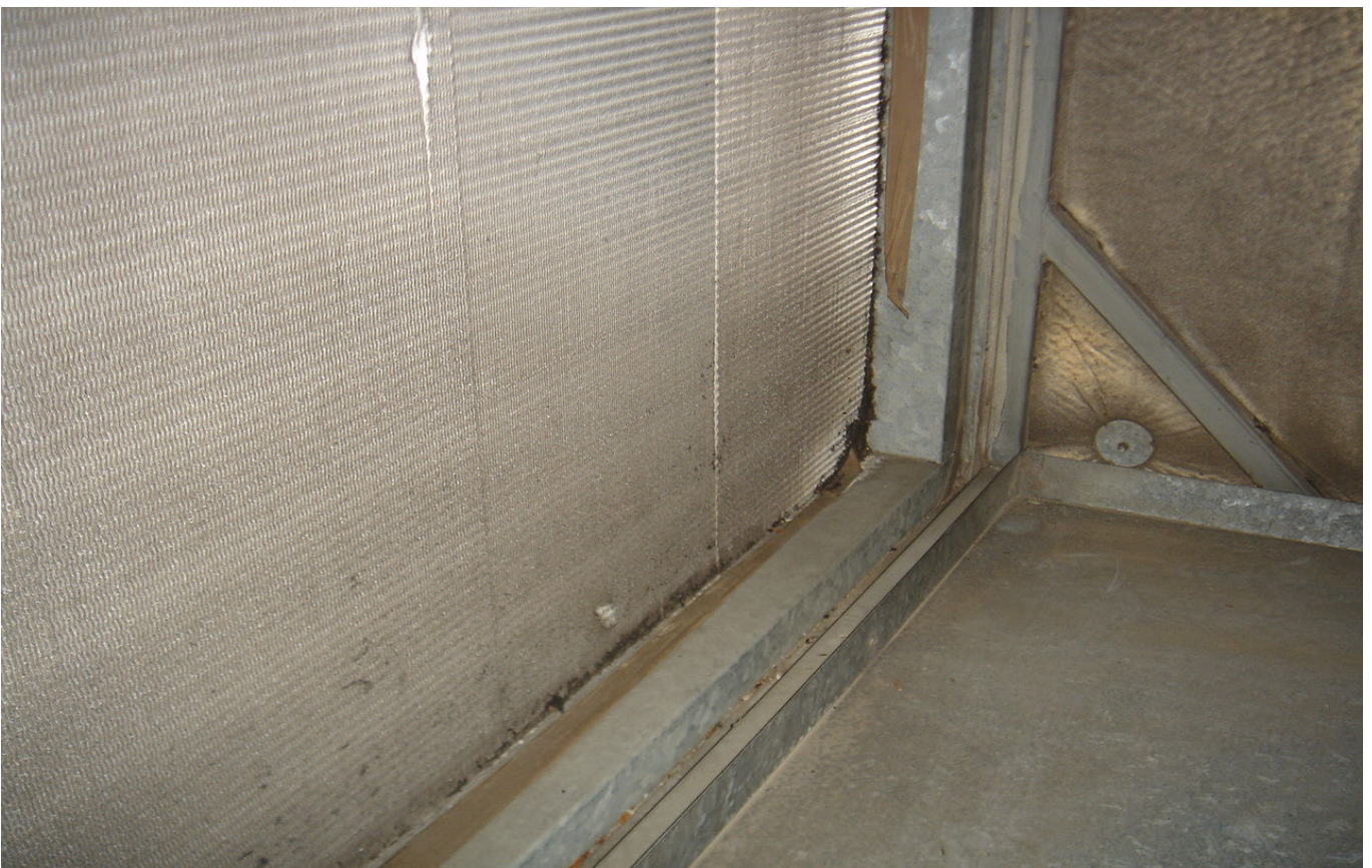
KUVA 14. Lämmityspatterissa on vielä hieman roskaa.
