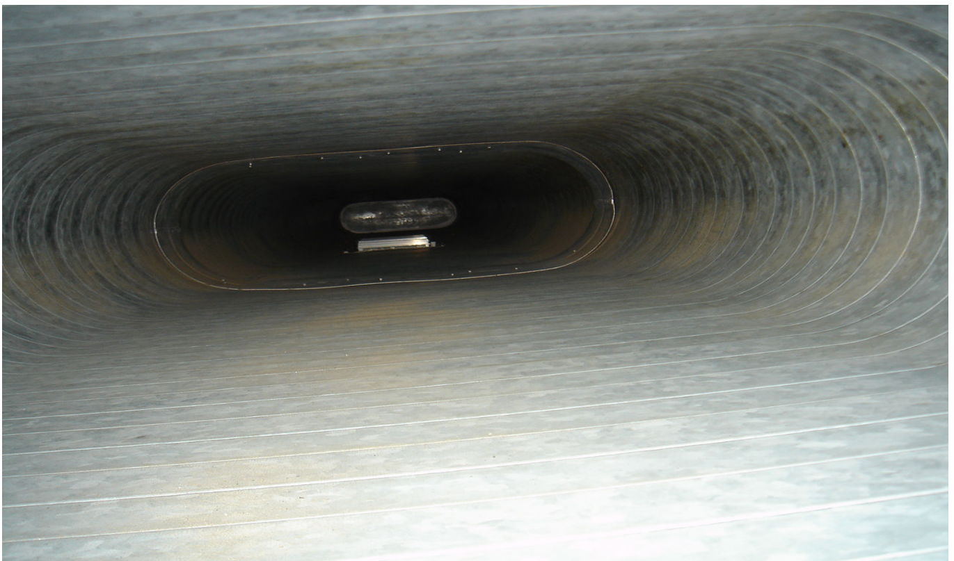
KUVA 16. Yleiskuva nuohotusta tuloilmakanavasta.
