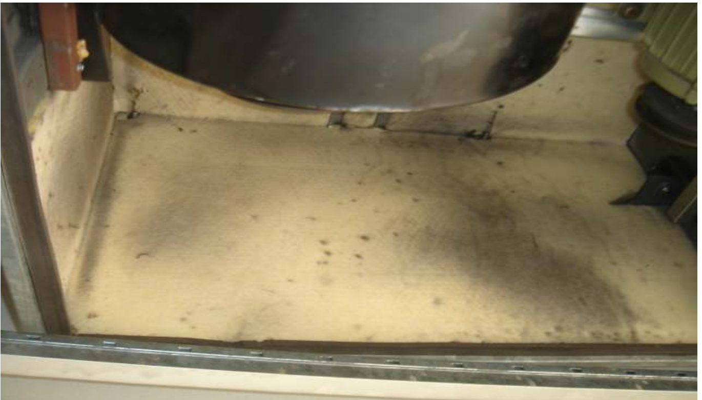
KUVA 22. Tuloilmakoneen kammiot on eristetty mineraalivillalla.
