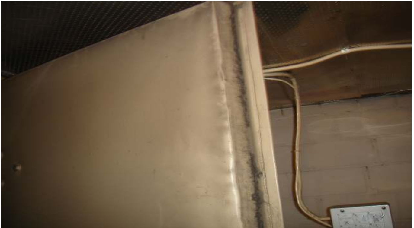
KUVA 2. Luukkujen tiivistys on huono.
