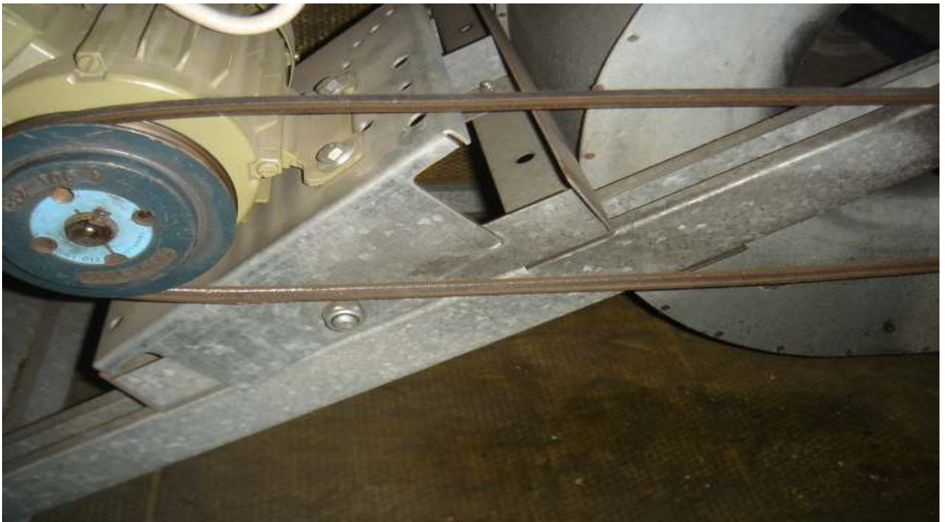
KUVA 8. Hihnat ovat osin melko löysällä.
