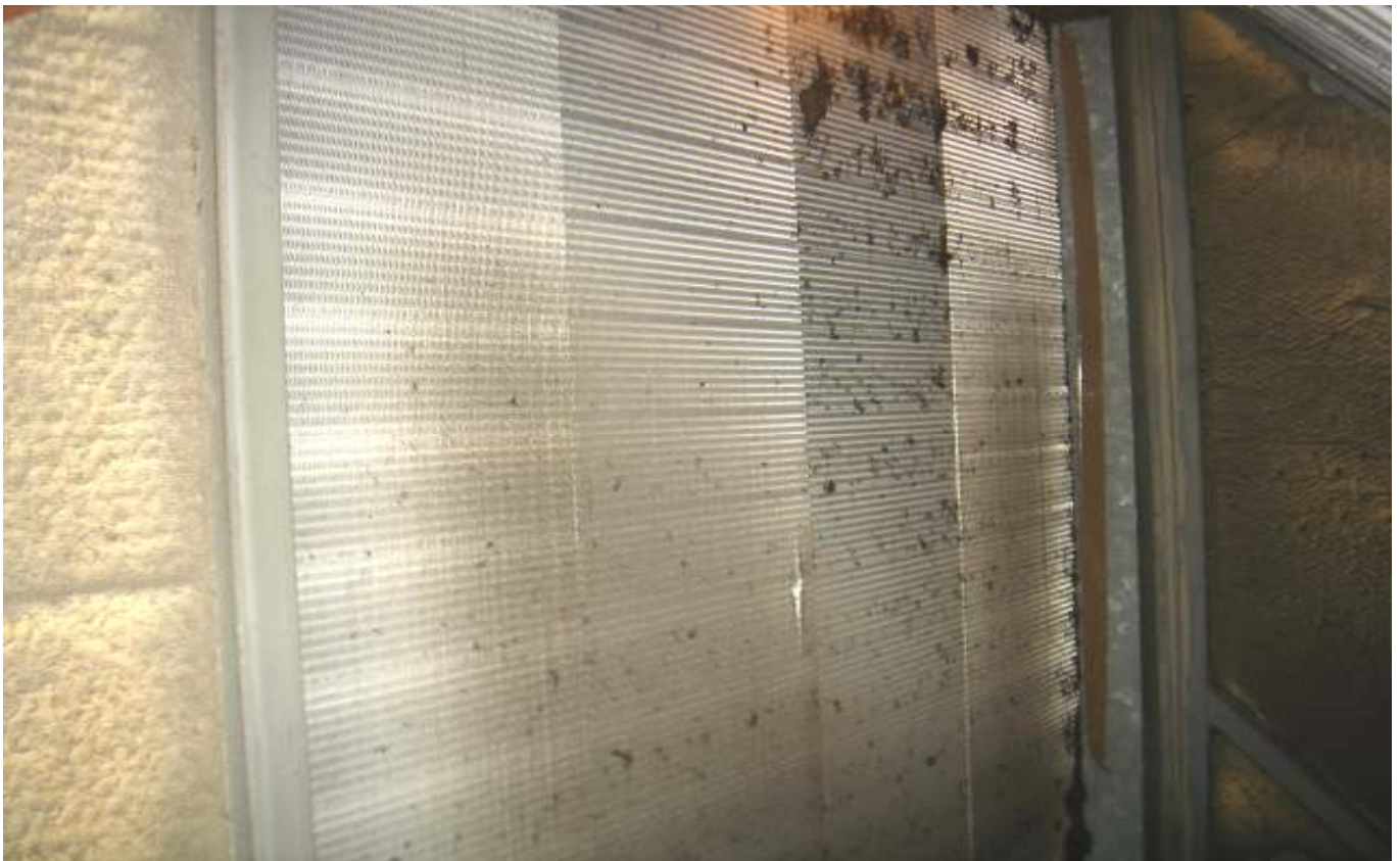
KUVA 20. Lämmityspattereri on pöyinen ja roskainen.
