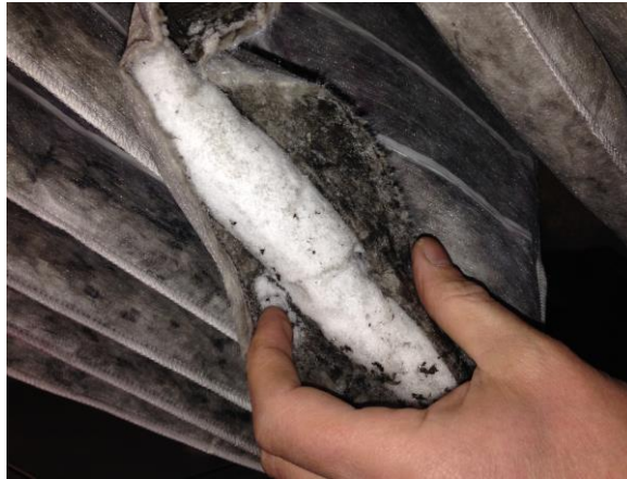
Kuva 2 rikkoutunut suodatint, kone TK 06
