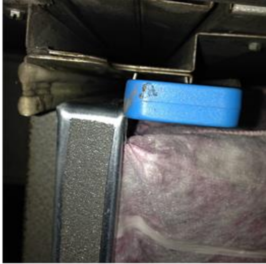
Kuva 1. Suodatin on niin matala, että se saattaa päästä irtomaan kiskosta. KO suodattimia oli koneissa useampia.
