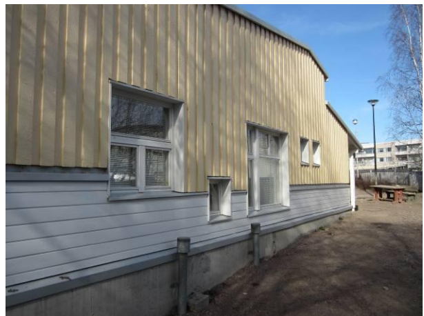
Kuva 6 Eteläpääty, alustatilan tuuletusputkia.
