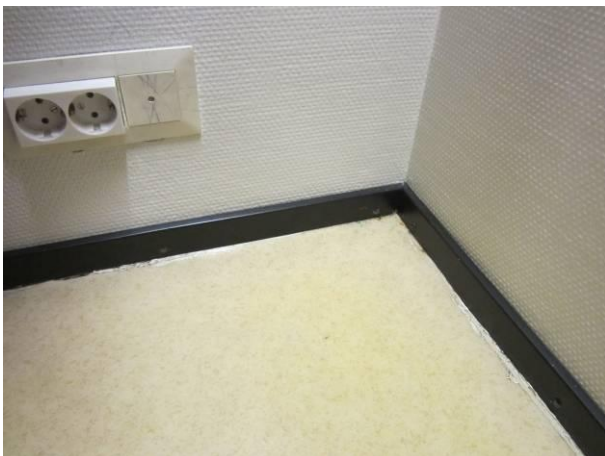
Kuva 47 Lattiarajan tiivistyskittaus
