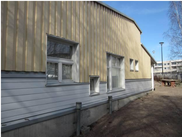
Kuva 15 Pohjoispäätyä, jossa lomalaudoituksesta "ylempi" osa on kunnostettu.
