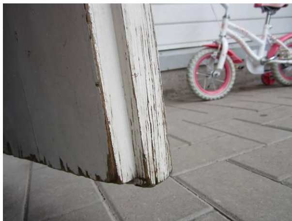
Kuva 22 Kulunut ulko-ovi.
