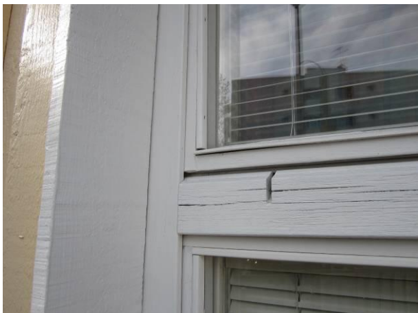
Kuva 19 Halkeillut ikkunakarmi
