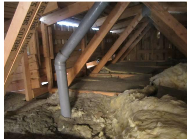
Kuva 28 Eristämätön tuuletusviemäri.
