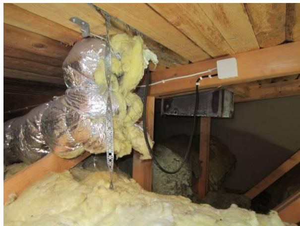
Kuva 29 Eristetty poistopuhaltimen IV-kanava, sen takana vanerinen tuuletuspiippu vesikatolle.
