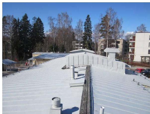
Kuva 24 Kulkusillat ovat puusta, erilaisia läpivientejä on paljon.
