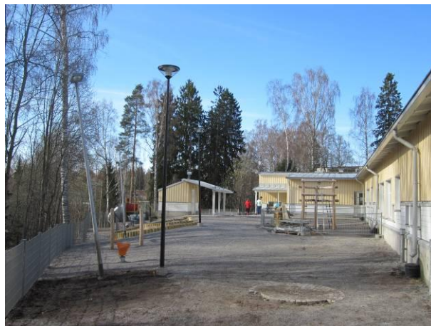
Kuva 5 Länsisivun leikkiapiha, sadevesikaivo
