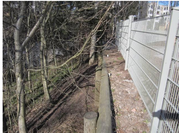
Kuva 4 Luoteissivun pengerrys ja uusi raja-aita
