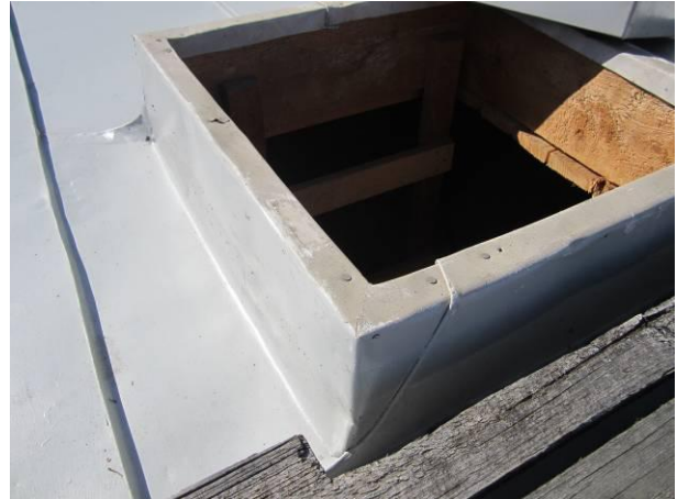
Kuva 26 Hyvin tehty kattoluukun läpivienni.
