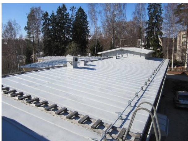
Kuva 23 Vesikatolle pääsee talotikkaita pitkin, räystäällä on lumiesteet.
