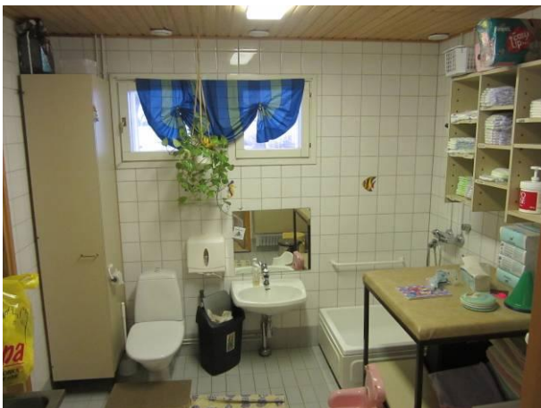
Kuva 35 Pesuhuone-WC-tila 08 10x10 laatat lattiassa.
