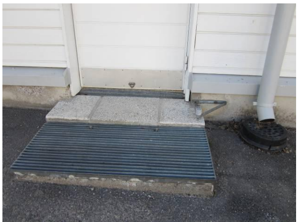
Kuva 12 Sisäänkäyntitaso, rännikaivo ja valesokkeli.
