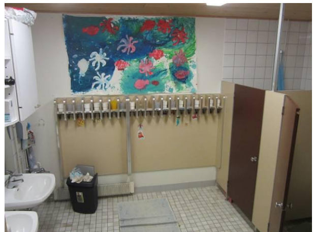
Kuva 36 Pesuhuone-Wc-tila 43, jossa on 5x5 laatat lattiassa.
