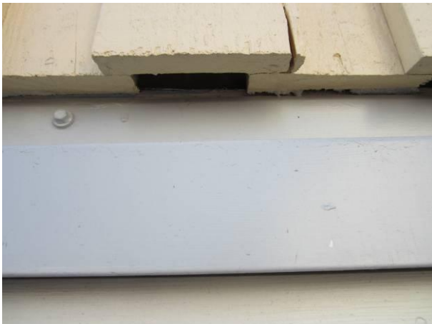
Kuva 17 Kunnostetut lautojen alapäästä ja uusi vesipellititys.
