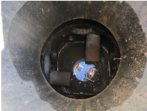
Kuva 3 Luoteisnurkan salaojan tarkastuskaivo.
