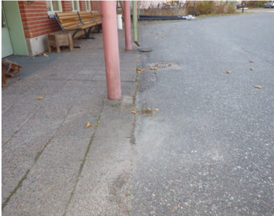
Sisäänkäynnin puoleista piha-alueetta.
