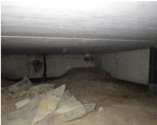
Maa-aines on hienoa hiekkaa ja muovia on paikoin levitetty tilaan epätasaisesti. Alapohjatilaa ja viemäriputkistoja.
