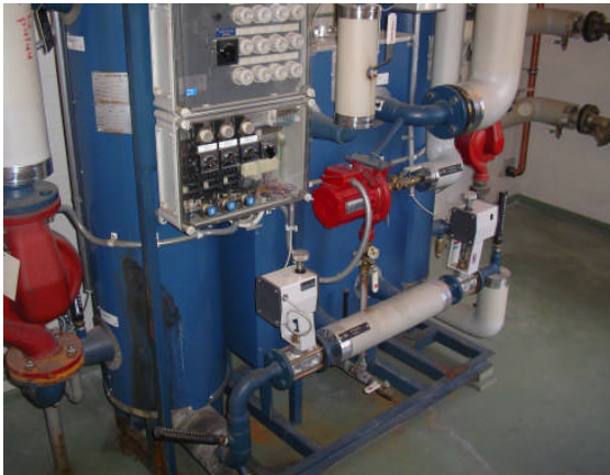
Lämmönjakokeskus.
