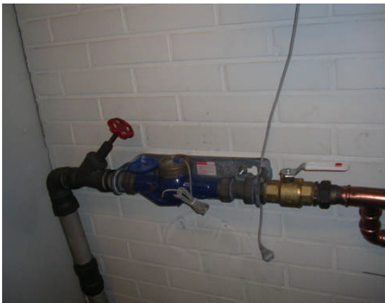
Kiinteistön vesimittari.
