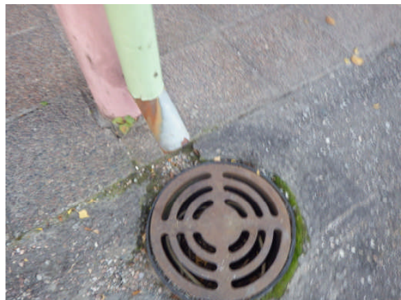
Sadevesiä on osittain ohjattu sadevesikaivoon etupihan puolella.
