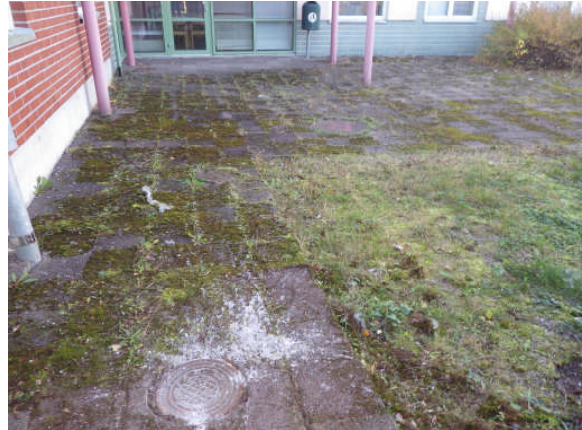
Sivupihalla on betonilaatoituksen pintaan kertynyt sammalkasvustoa ja laatoitus on paikoin muotoutunut epätasaiseksi.
