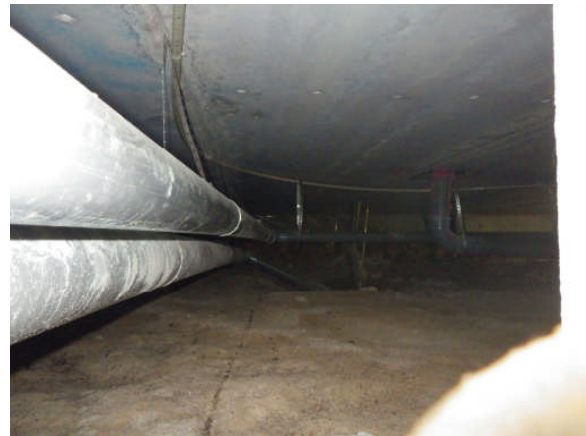
Maa-aines on hienoa hiekkaa ja muovia on paikoin levitetty tilaan epätasaisesti. Alapohjatilaa ja viemäriputkistoja.
