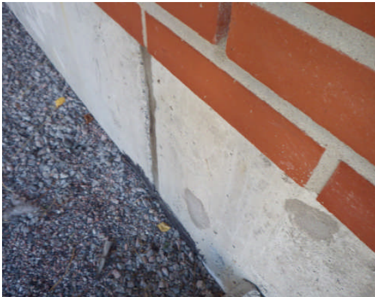
Sokkelipalkit ja elementtien välissä olevaa tiivistystä. Rakennuksen vierustaa.
