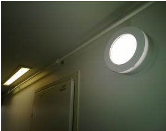
Uusittu led-valaisin ja alkuperäinen loisteputki.
