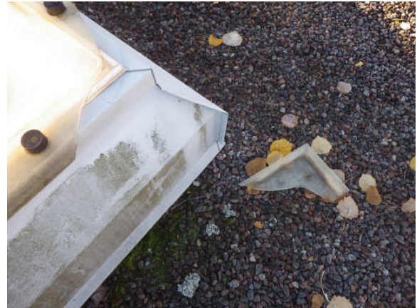
Kattokuvun reunasta on lohjennut palanen.
