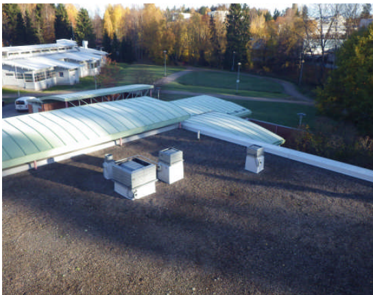
Yleiskuvaa rakennuksien tasakattopinnoista.
