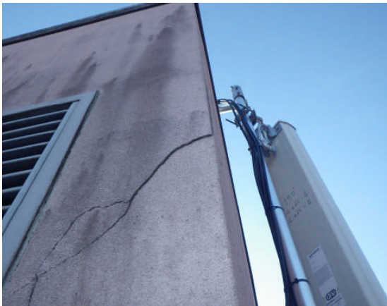
Katolla olevan konehuoneen rappauspinta paikoin haljennut. Julkisivuelementtien pinnoitetta
