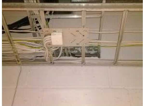
Läpivienti auki, RK 3.1.
