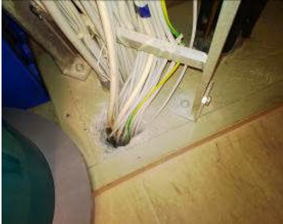
Läpivienti auki, RK 2.4.
