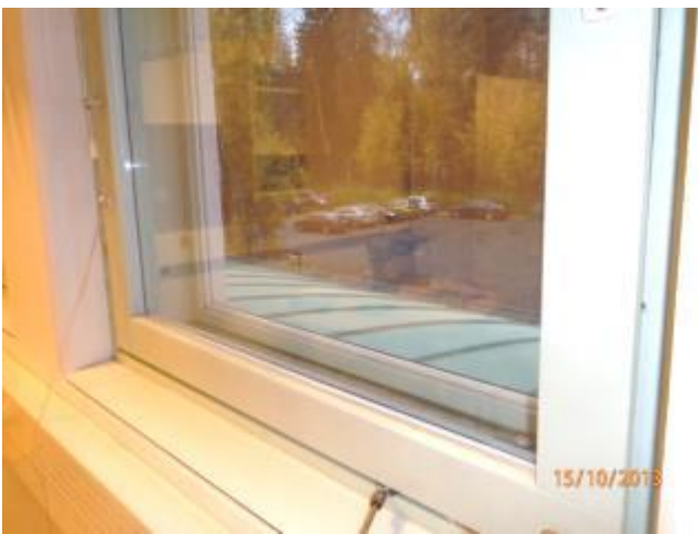
kuva 7 Avattavissa ikkunoissa on 3-kertaiset lasit.
