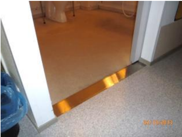
kuva 18 Märkätilojen kynnykset ovat matalia ja...
