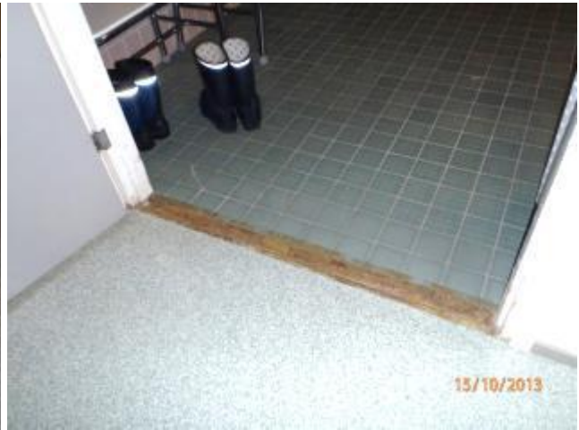
kuva 19 ...joitakin kynnyksiä on irronnut paikoiltaan.
