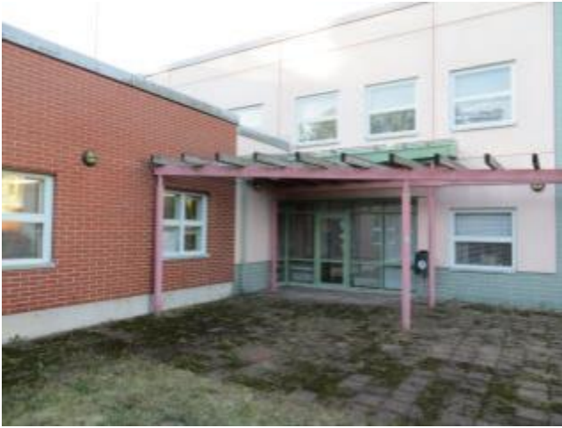
kuva 1 Rakennuksen ulkoseinät ovat sandwich-elementtejä ja tiilimuurattuja seiniä.
