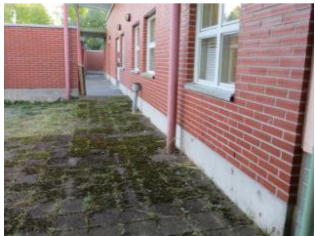
kuva 8 Vesipeltien kaltevuus on riittävä.
