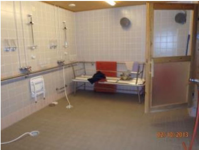
kuva 3 Märkätilojen seinät ovat laatoitettu.
