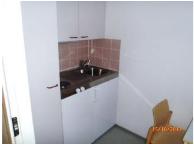
kuva 4 Kuivien huoneilojen vesipisteissä on osalaatoituksia.
