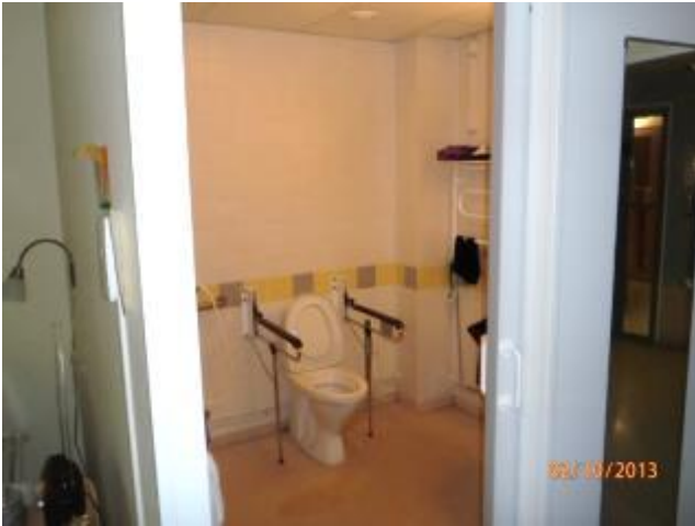
kuva 16 Kylpyhuoneiden seinät ovat laatoitettu.
