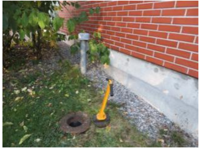
kuva 2 Sokkelit ovat käsittelemätöntä betonia. Etualalla salaojan tarkastusputki.
