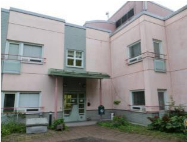
kuva 9 Rakennuksen ulko-ovet ovat metallisia ikkuna-ovia ja...
