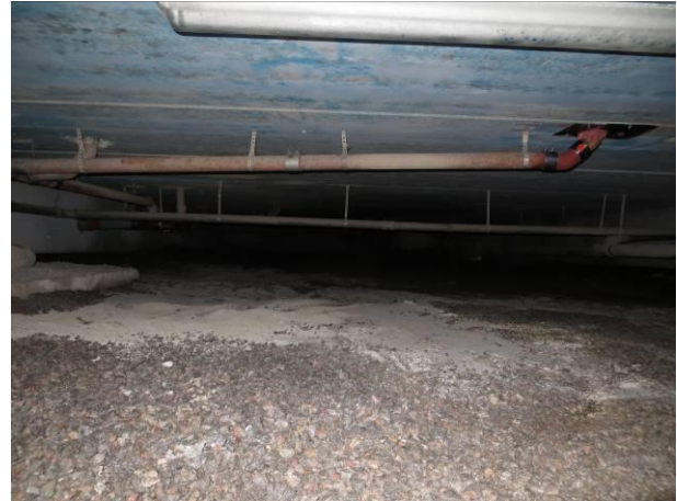
Kuva 24 Uusittu mutka 11.10.13 ja maanpintaan levitettyä kalkkia.
