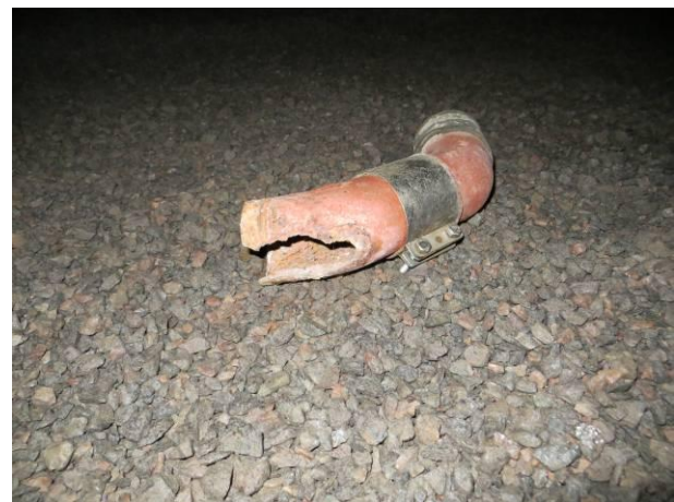
Kuva 22 Vanha aiemmin purettu syöpynyt osa.
