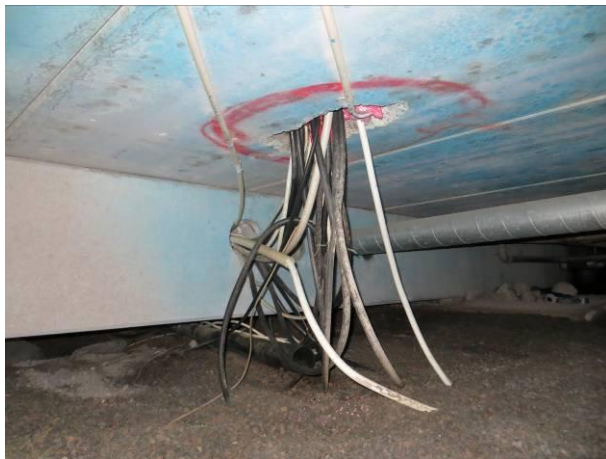
Kuva 25 Epätiivis kaapeliläpivienti. Palkin ali yhteys B-osan lohkoon 2.
