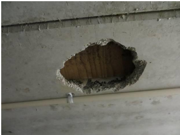
Kuva 37 Vaneria ontelolaatan sisällä.
