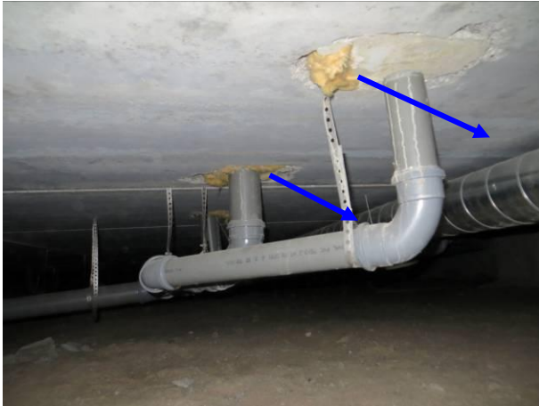
Kuva 15 Viemärläpivientien epätiiviyiskohtia
