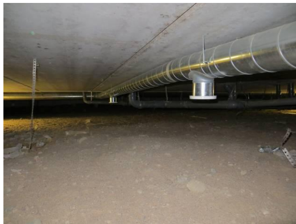
Kuva 8 Poistokanavistoa.
