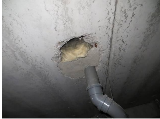
Kuva 36 Epätiivis viemäri­läpivienti.
