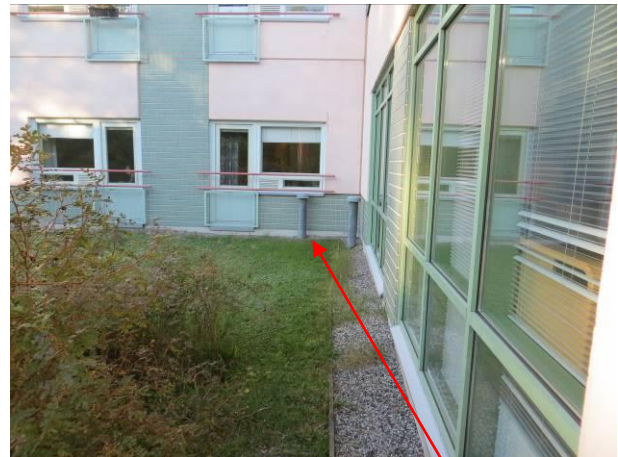
Kuva 4 B- ja C-osan välinen nurkkaus länsisivulla, aivan nurkassa on korvausilmaputkia alustatiloihin.
