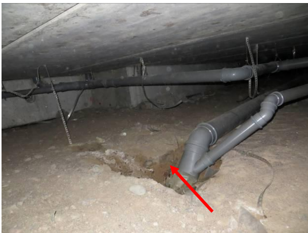
Kuva 29 Kostea hiekka rikotun muovin alla.
