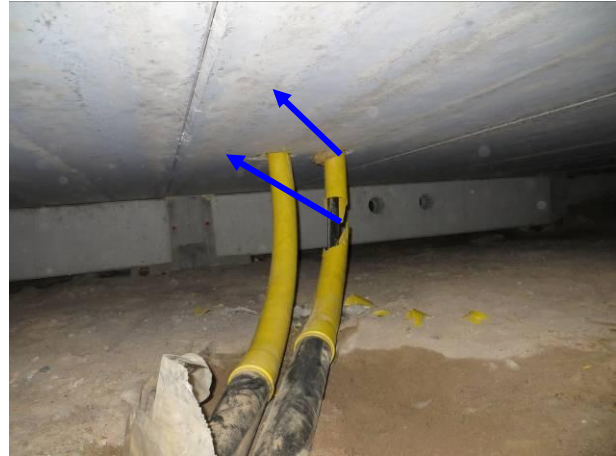
Kuva 16 Epätiivis kaapeliläpivienti.
