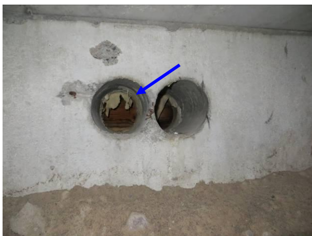
Kuva 13 Sokkelipalkin sisällä märkä vaneri.
