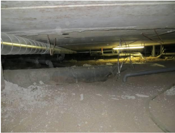
Kuva 39 Yleiskuva D-osan lohkon 9, laastijätettä, katosta törröttäviä teräksiä.
