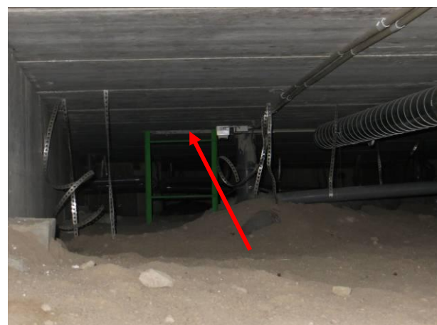
Kuva 44 Yleiskuva lohkon 8 kohti kulkuluukkaa tilan D120 kohdalla.
