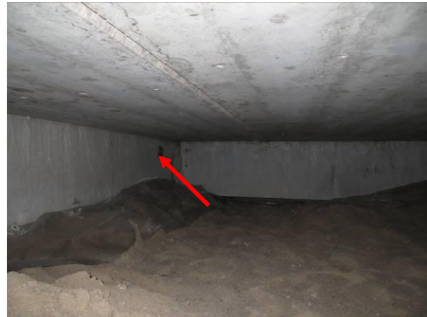
Kuva 42 Lohkon 9 eteläpäätä korvausilmaputki sokkelipalkin läpi.
