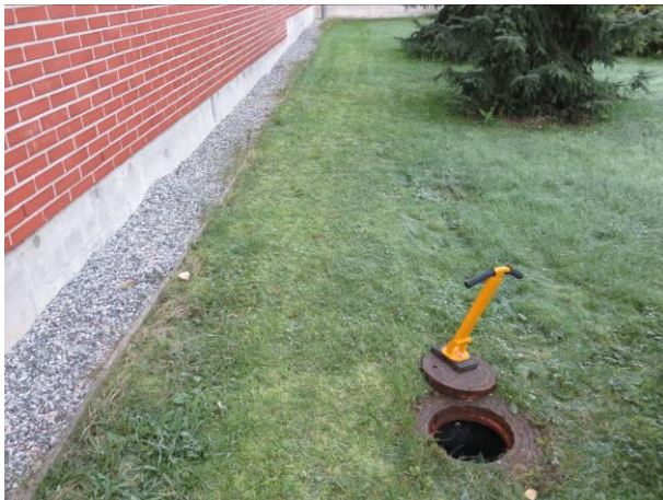
Kuva 3 B-osan länsisivulla väestönsuojan sivua, jossa on tarkastettu salaojien tarkastus-/ perusvesikaivo.
