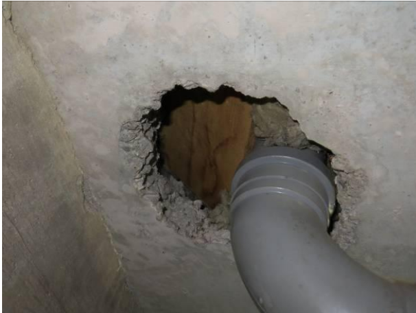
Kuva 19 Tiivistämätön läpivienti.
