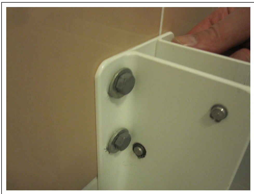
Kuva 16. Tukikaiteen kiinnitys löystynyt
