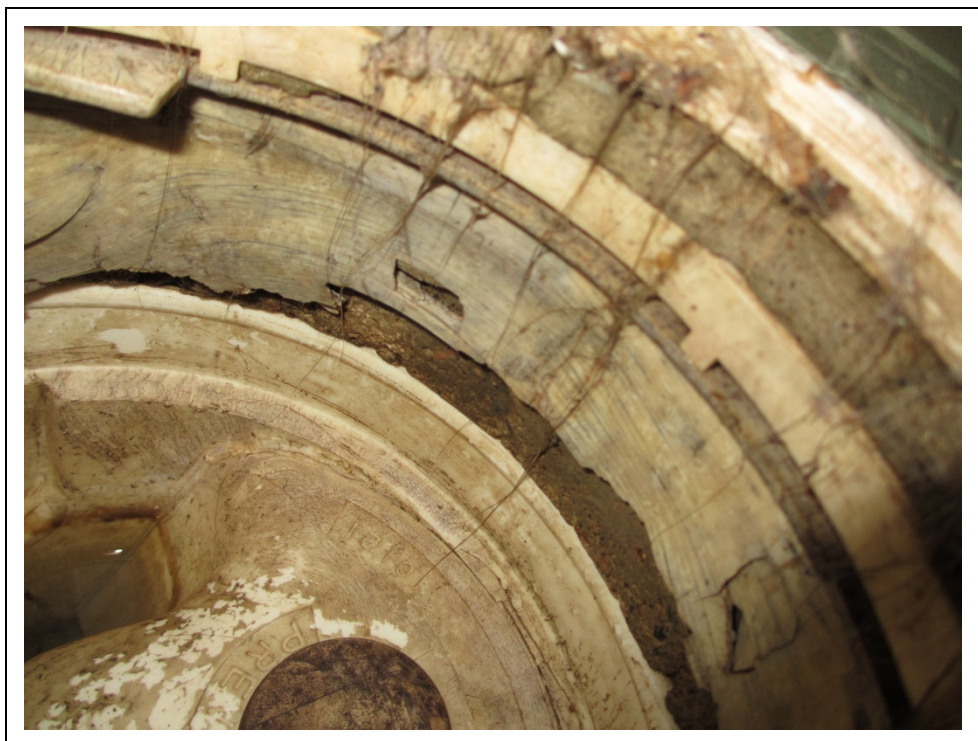
Kuva 18. Yleisen kylpyhuoneen lattiakaivo
