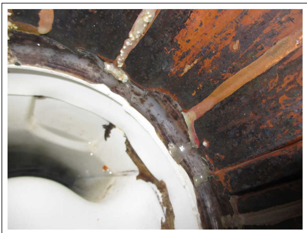
Kuva 6. Lattiakaivon ja korokerenkaan välinen sauma
