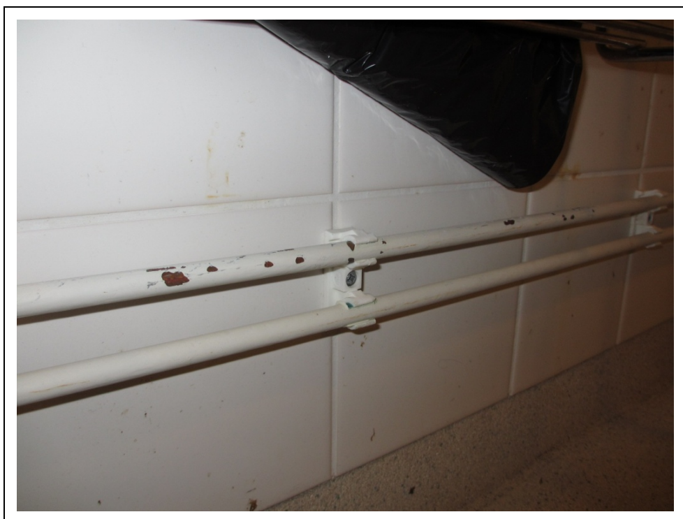
Kuva 18. Vesijohtojen maalivaurio
