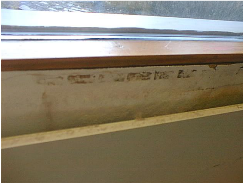
Kuvat 2-3. Huone 111 Ikkunan alla korjaamaton kosteusvaurio.
