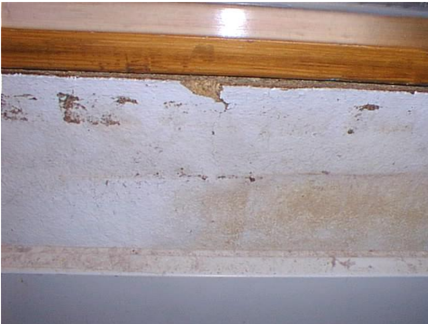
Kuvat 2-3. Huone 111 Ikkunan alla korjaamaton kosteusvaurio.
