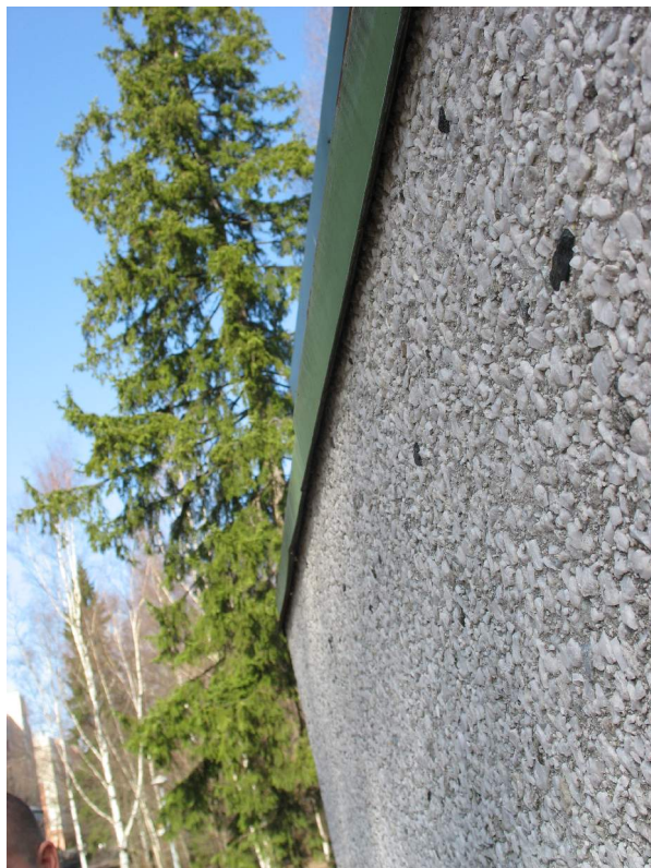
Kuva 7. Rästäspellityksen ovat kiinni elementin pinnassa, näin ollen räystäsrakenne ei mahdollista vesikaton rakenteiden tuulettumista. Myöskään myrskypeltejä ei kohteessa havaittu.
