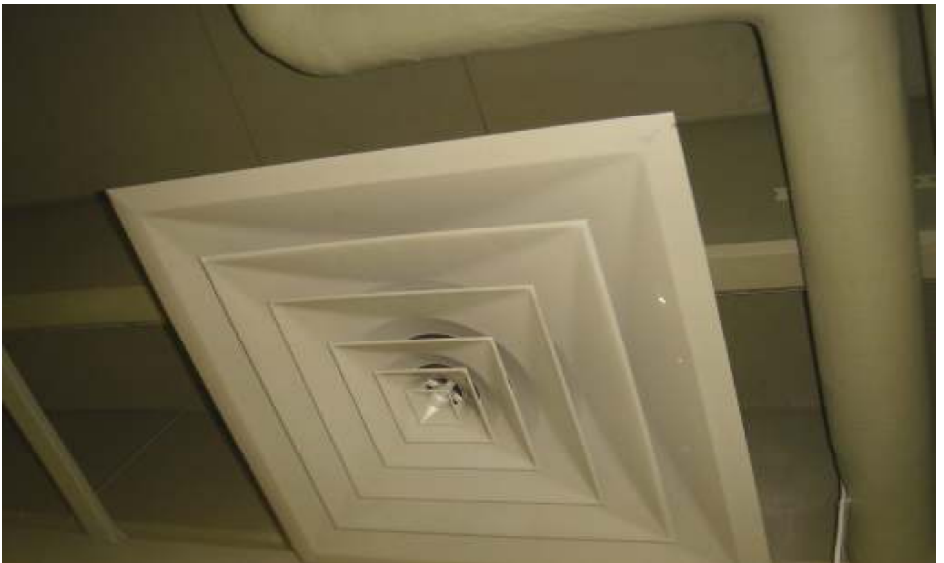
KUVA 26. Yleiskuva luokkatilojen kattohajottajasta.
