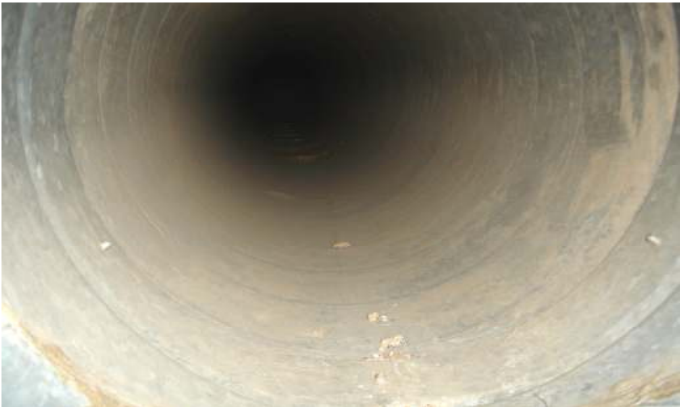
KUVA 24. Yleiskuva näyttämön poistoilmakanavasta.
