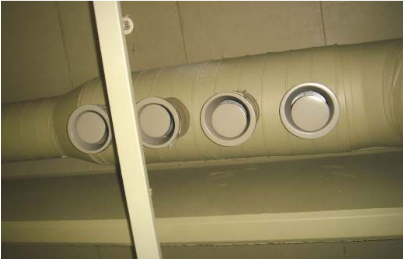
KUVA 27. Yleiskuva poistoilmaventtiileistä.
