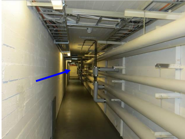
Kuva 19 Putkitunneli PT2 B-alustatilan viereinen osuus, jonka perällä on luukku PT3 putkitunneliin (luukku oli raolleen).
