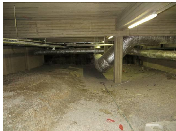
Kuva 2 Kantavia alapohjarakenteita ja perustuksia C-alustatilasta.
