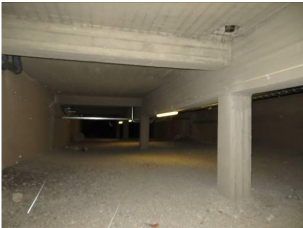
Kuva 41 Yleiskuva PT1-putkitunnelin viereiseen onteloon.
