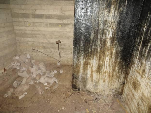
Kuva 43 E1-lohko, hiekkaa pohjalla, rakennusjätettä, sidosteräksiä.
