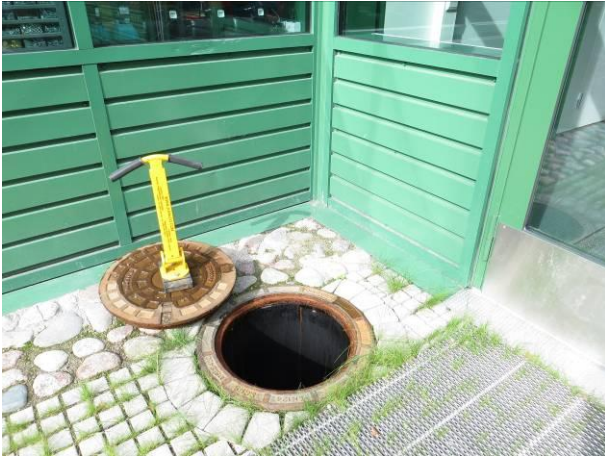
Kuva 3 A-alustatilan vierellä salaojan tarkastuskaivo tilan 090 lähellä.
