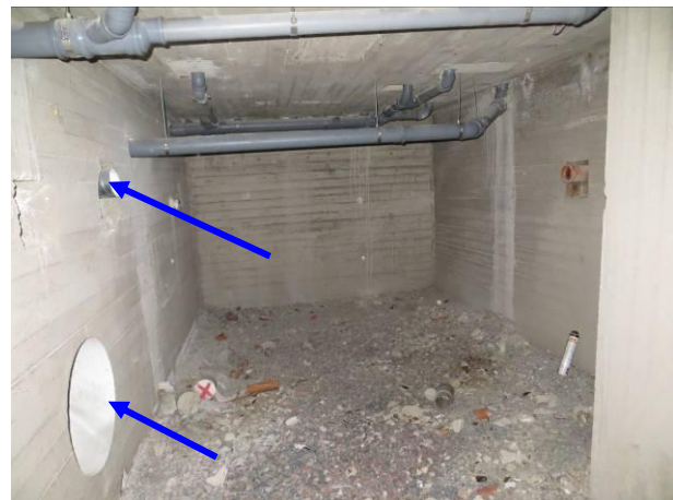
Kuva 18 Poistokanavan venttiilitön pää E2-alustatilassa ja kulkuluukku, jonka suo-javaneri ulkopuolelta on poistettu.
