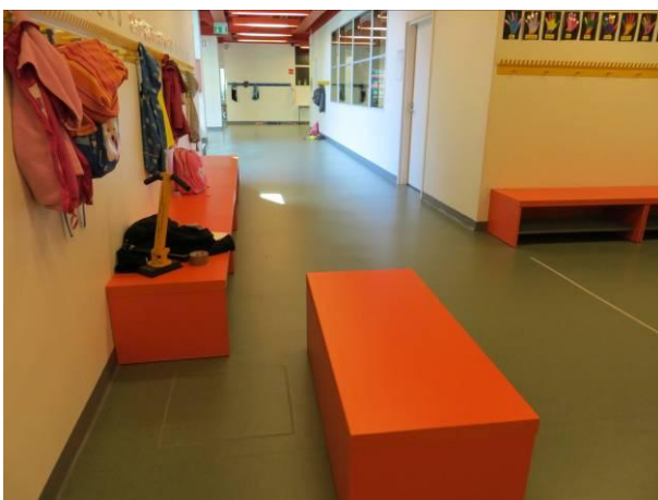
Kuva 51 Käytävä 207, jossa on kaksi tarkastusluukku.
