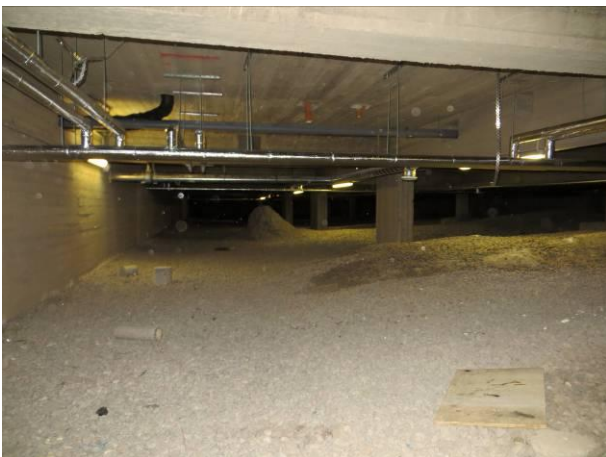
Kuva 29 Yleiskuva B-alustatilasta PT2-putkitunnelin viereiseltä alueelta.
