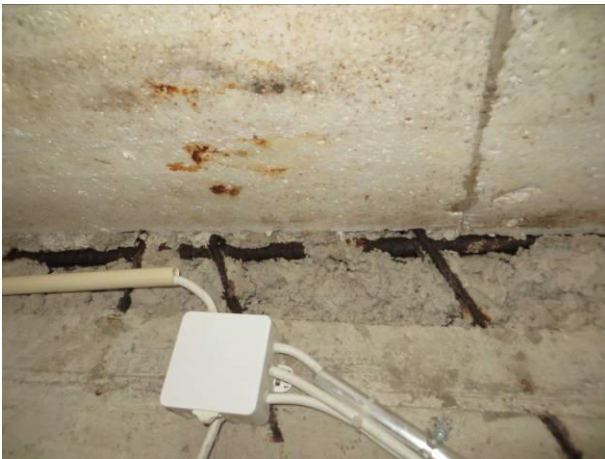
Kuva 23 Ruosteisia rakenneteräksiä.
