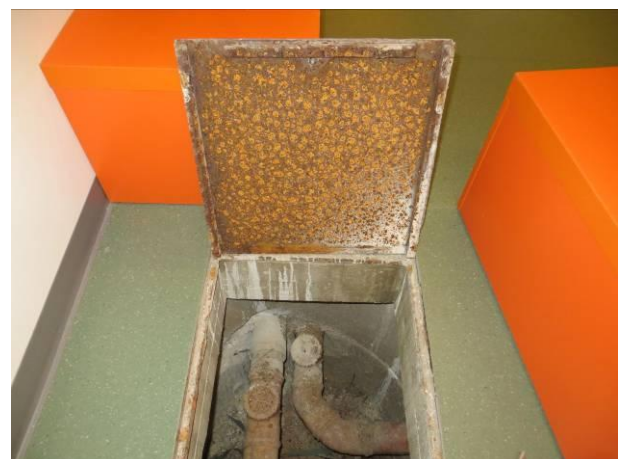
Kuva 52 Käytävän 207 reunoiltaan elastisella kitillä tiivistetty teräsluukku. Tarkastuskaivossa on pohjaviemäreitä.
