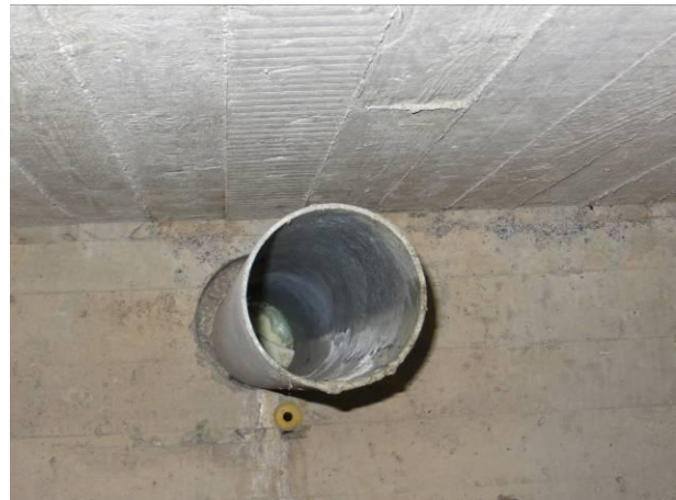
Kuva 10 Uretaanilla tukittu korvausilmaputki, jota ei ole enää esillä maanpinnalla.
