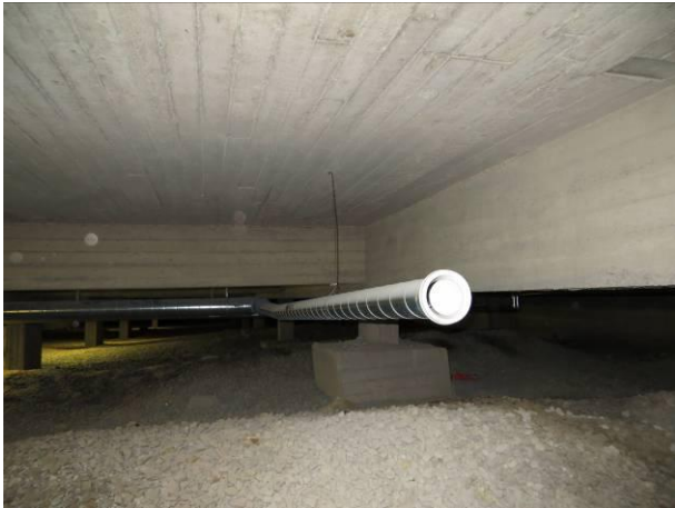
Kuva 11 B-alustatilan poistokanava keskialueella
