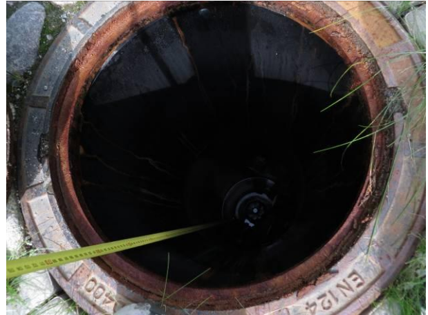
Kuva 4 A-alustatilan vierellä salaojan juoksupintaan on 165 cm kannesta.
