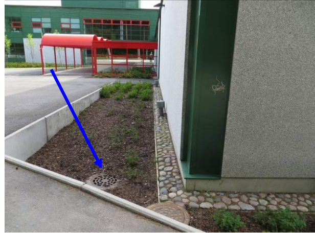
Kuva 8 Oikein asennettu sadevesikaivon kansi B-alustatilan kulmalla.
