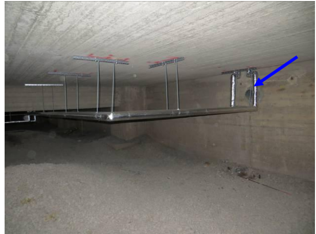
Kuva 12 Korvausilmaputki ulkoseinällä
