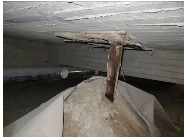
Kuva 24 Maamöykky ja lahoa puuta, maassa on mikrobikasvua
