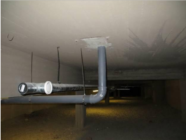
Kuva 15 Poistokanava D-alustatilassa
