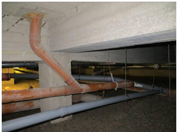
Kuva 26 Ruskea viemäri ei ole käytössä, vaan on poikki.
