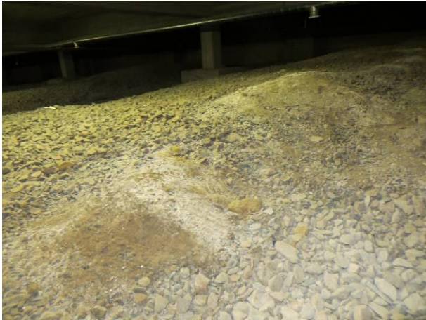
Kuva 31 Mikrobikasvua maaharjanteen päällä.
