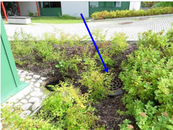
Kuva 5 Rinteessä oleva sadevesikaivo A-alustatilan kulmalla. Vieressä on toinen tarkastetuista salaojakaivoista.
