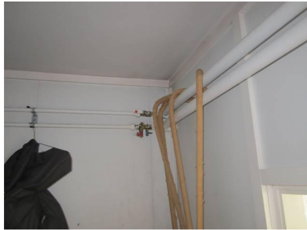
Kuva 50 Eristämättömiä lämpöputkia varastossa 33.
