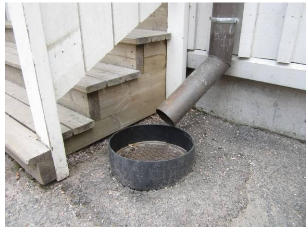
Kuva 6 Sisäpihan rännikaivo, joka on kunnossa.
