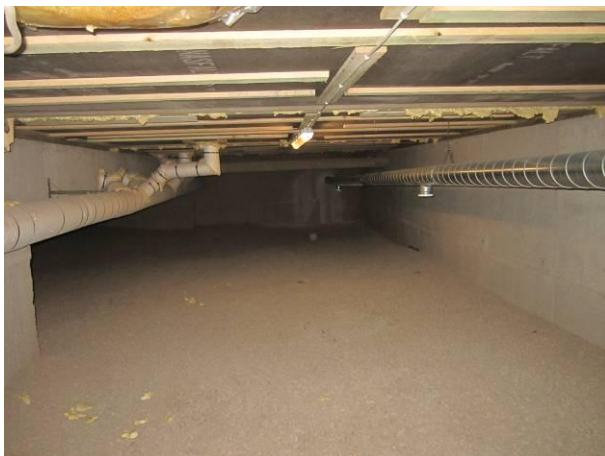
Kuva 9 Kunnossa olevaa alustatilaa, pohjalla on sepeli.
