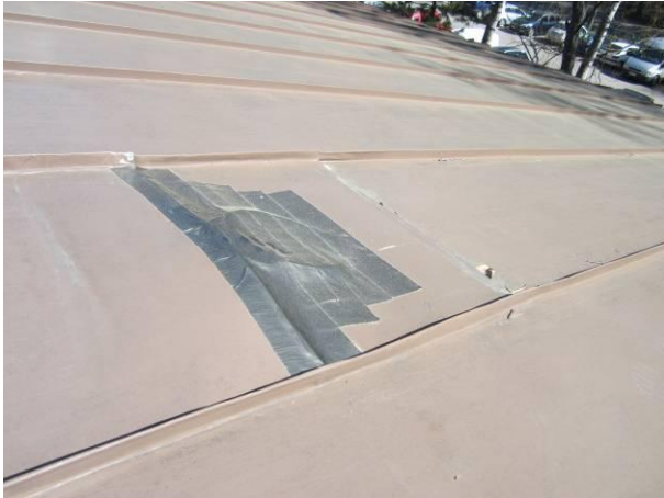
Kuva 31 Lumien viemä tuuletusputki.
