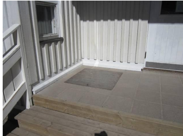
Kuva 24 Ulko-ovi ja sisäänkäynti.
