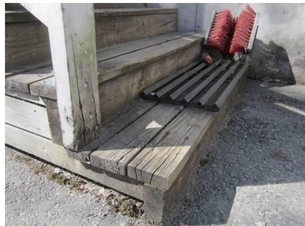
Kuva 26 Keittiön kuluneet ulkortaat.
