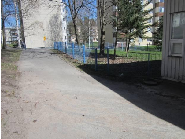
Kuva 3 Yläpäädyssä tilan 50 kulmalla sadevesiä valuu kohti rakennusta.
