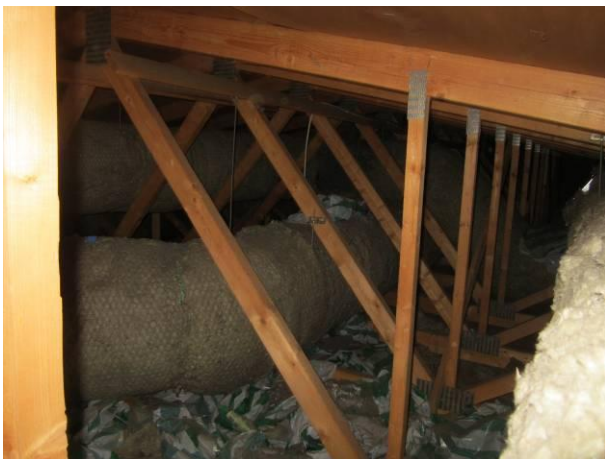
Kuva 33 Yleiskuva, IV-kanavia ja jätettä.
