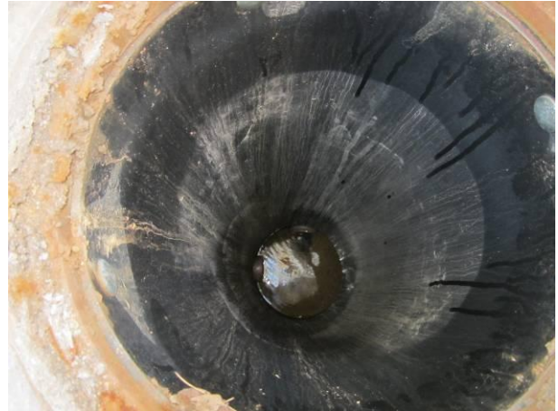
Kuva 8 Yläpäädyn so-kaivossa juoksupinta on n. 1,6 metriä kansitasosta.
