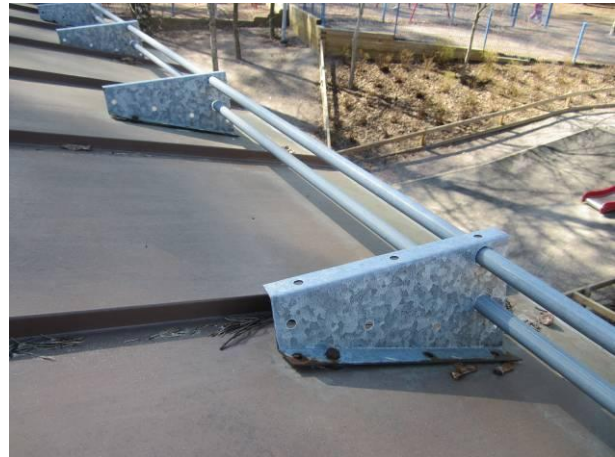
Kuva 30 Vuotoriskit kiinnityksistä.
