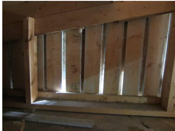
Kuva 38 Päätylaudoitus ei ole sadetiivis.
