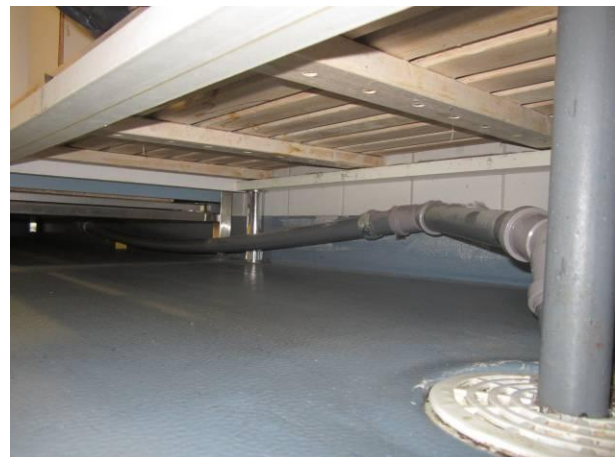
Kuva 50 Eristämättömiä lämpöputkia varastossa 33.
