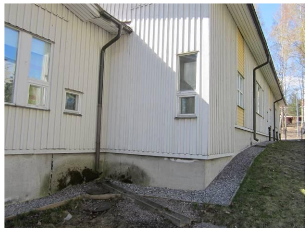
Kuva 2 Porrastuskohta, jossa rännivedet/lumi ovat kasteleet sokkelia, sammalkasvua sokkelissa.
