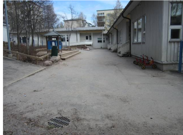
Kuva 4 Yleiskuva sisäpihan sivulta, kaadot ovat ok, pihalla on sadevesikaivo.
