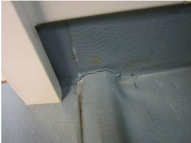
Kuva 15 Vesileikkihuoneen rikkiäinen mat- tosauma.
