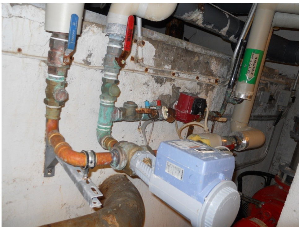
Kuva 4. Naisten suihkuveden sekoitusryhmä (miehillä vastaava).
