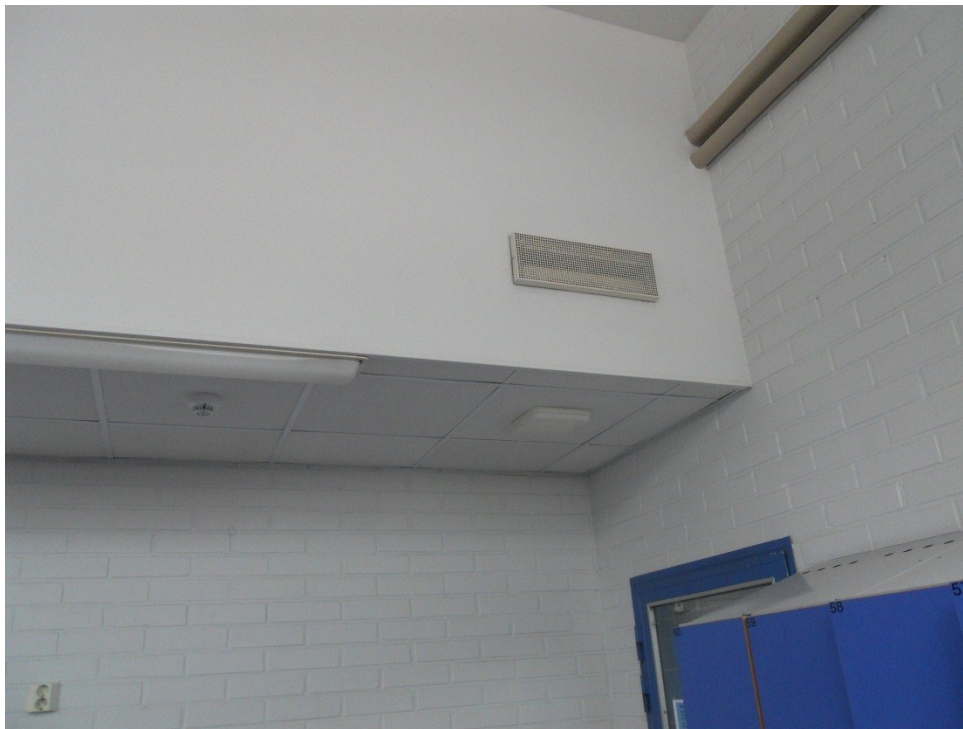
Kuva 26. Pukutilojen poistoilmalaitteita.
