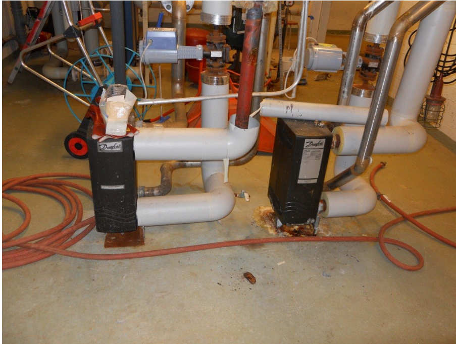
Kuva 1. Allasvesien lämmönsiirtimet ja RAU-toimilaitteita.
