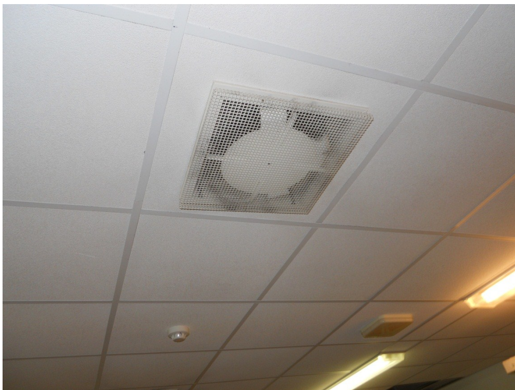
Kuva 34. Kuntosalin tuloilmalaite.
