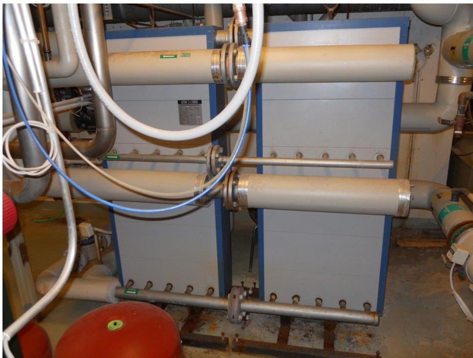
Kuva 3. Käyttöveden lämmönsiirtimet.
