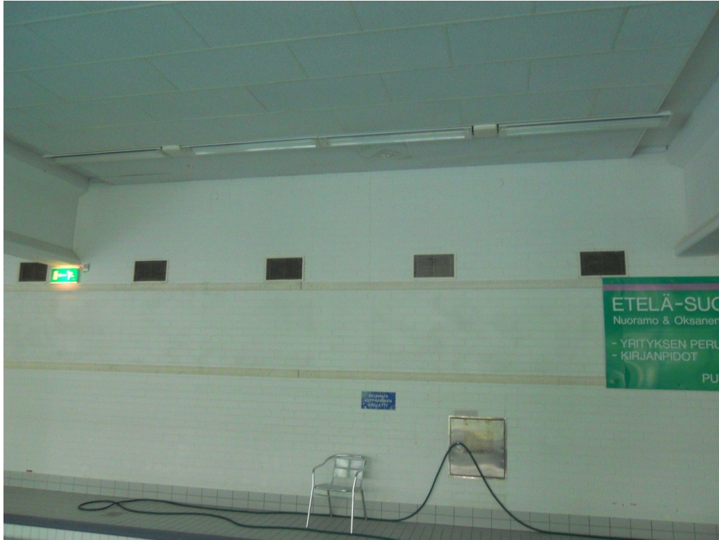
Kuva 28. Allastilojen poistoilmalaitteita.
