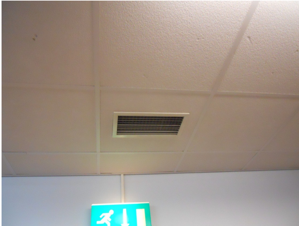
Kuva 35. Kuntosalin poistoilmalaite.
