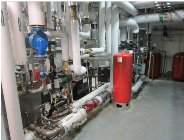
Kuva 40. Kaukolämmön alajakokeskus.
