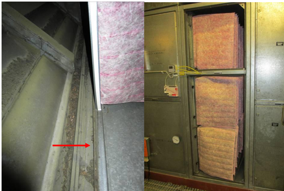
Kuvat 2-3. Tuloilman suodatinkehikon tiiveyttä on parannettu asentamalla tiiviste kehikkoon.
