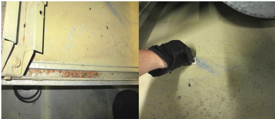
Kuvat 25-26. Ilmanvaihtokoneen puhaltimissa ja kammioissa on havaittavissa melko paljon pölyä ja roskaa.
